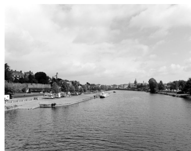
Le port d'aval, sur la rive droite, et, au second plan, le quai du docteur Lelièvre, sur la rive gauche, vus depuis le pont de l'Europe. Phot. François Lasa IVR52_20025300706X
