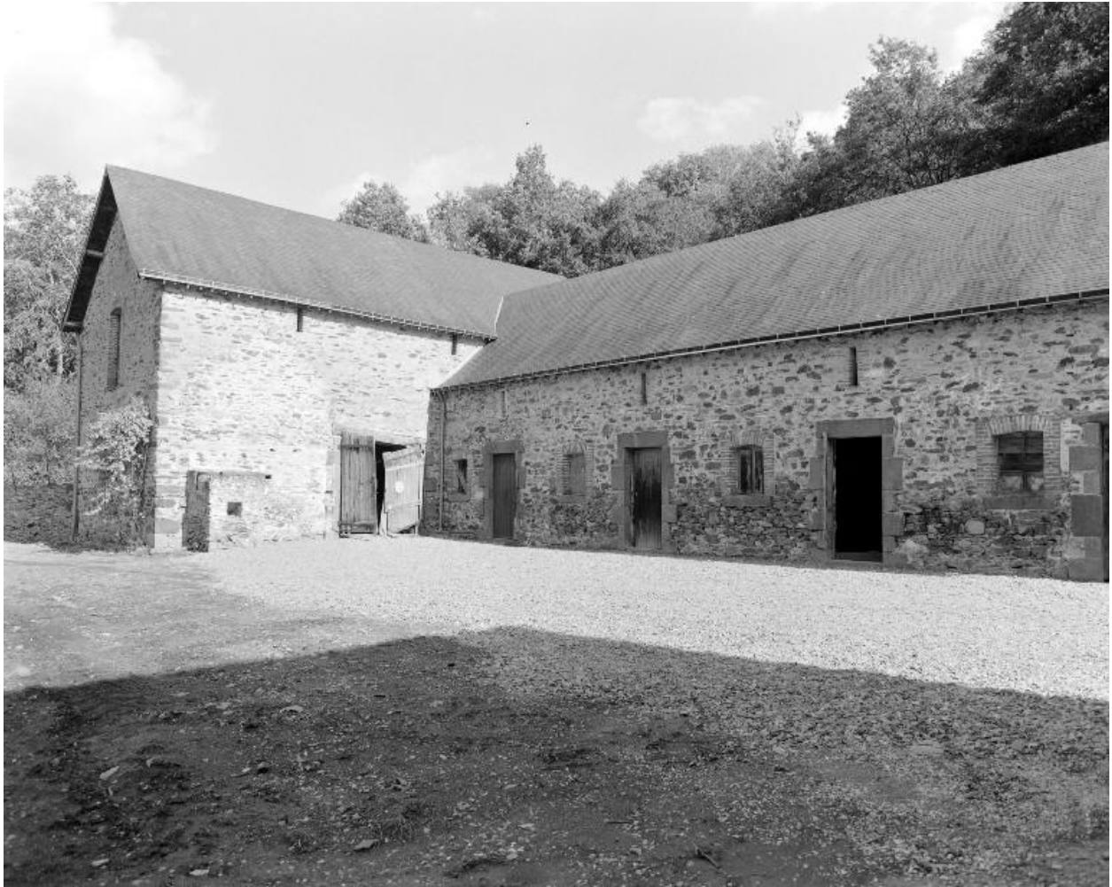
Le bâtiment de dépendances qui abritait à gauche une remise, à droite l'écurie.
