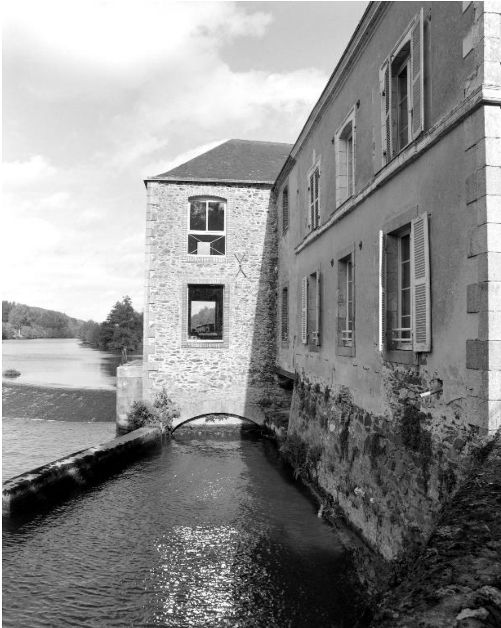
Le canal de fuite du moulin, vu du sud. Façade sud du moulin et façade ouest du logement du meunier.
