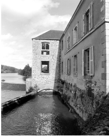
Le canal de fuite du moulin, vu du sud. Façade sud du moulin et façade ouest du logement du meunier. Phot. François Lasa IVR52_20015300500X
