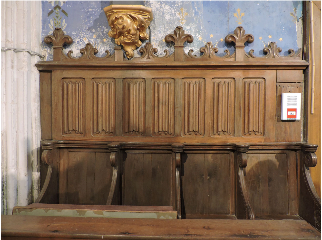
Le lambris au pied du mur du chevet, derrière les stalles.
