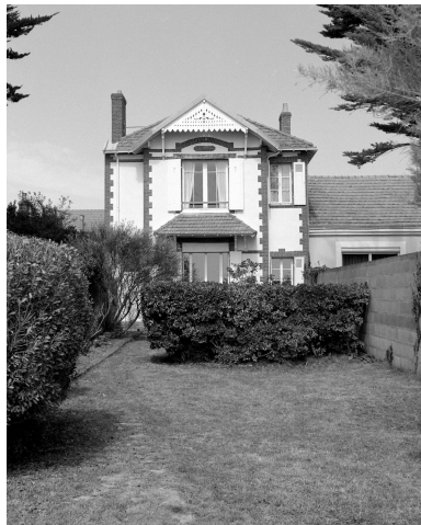
Elévation antérieure. Phot. Denis Pillet IVR52_19974402378X
