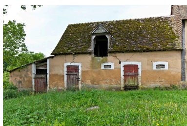
Elévation sur cour des étables en prolongement de la grange-étable Phot. Yves Guillotin IVR52_20127201218NUCA
