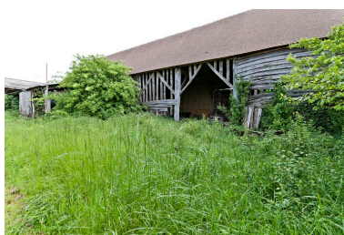
Elevation postérieure de la grange-étable Phot. Yves Guillotin IVR52_20127201215NUCA
