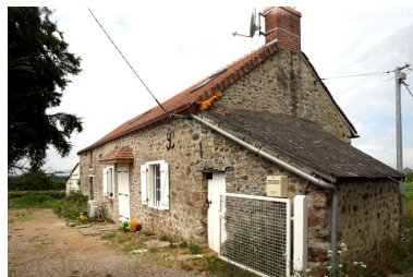
Le logis-étable ouest vu depuis la route au sud-est. Phot. François Lasa IVR52_20055301926NUCA
