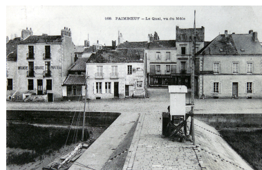
La jetée vue depuis le feu de port vers le quai (1er quart XXe siècle). Autr. Collection L. B. Saint-Nazaire, Phot. Denis (reproduction) Pillet IVR52_20034401747NUCA
