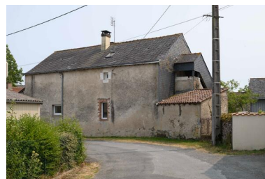
Maison 2 rue de la Promenade depuis le nord. Phot. Armelle Maugin IVR52_20254900687NUCA
