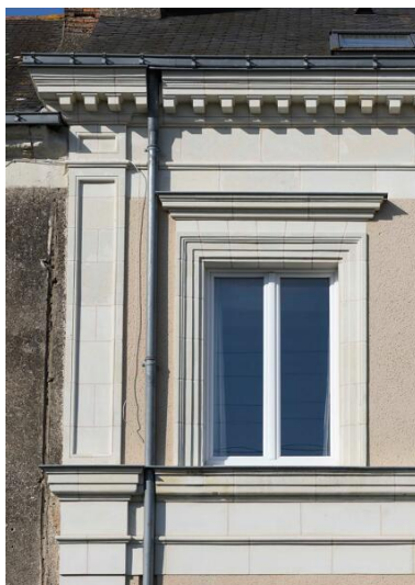
Maison 3 rue d'Anjou : détail d'un pilastre d'angle, d'une baie et de la corniche à modillons. Phot. Armelle Maugin IVR52_20254900245NUCA
