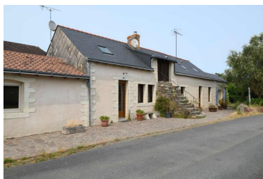
Commanderie de Bourgneuf. Phot. Armelle Maugin IVR52_20254900690NUCA
