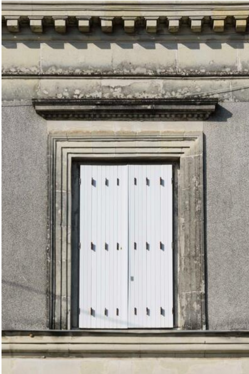
Mason 5 rue d'Anjou : détail d'une baie et de la corniche dentelée.
