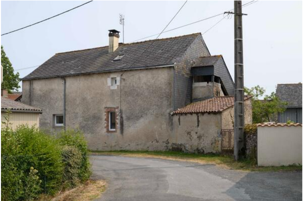
Maison 2 rue de la Promenade depuis le nord.
