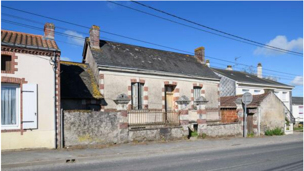
Maisons 11, 13 et 15 rue de la Loire.
