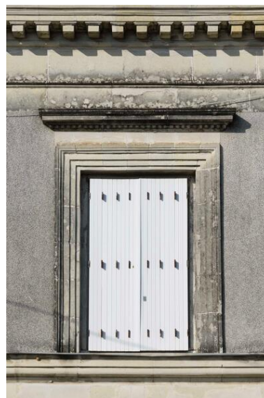
Maison 5 rue d'Anjou : détail d'une baie et de la corniche dentelée. Phot. Armelle Maugin IVR52_20254900244NUCA
