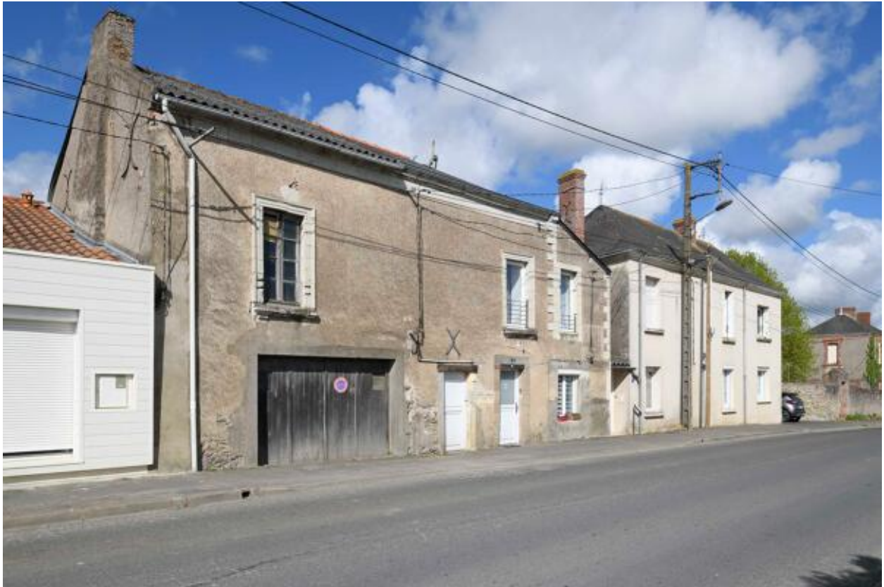
Maisons 3, 5 et 7 rue de la Loire.
