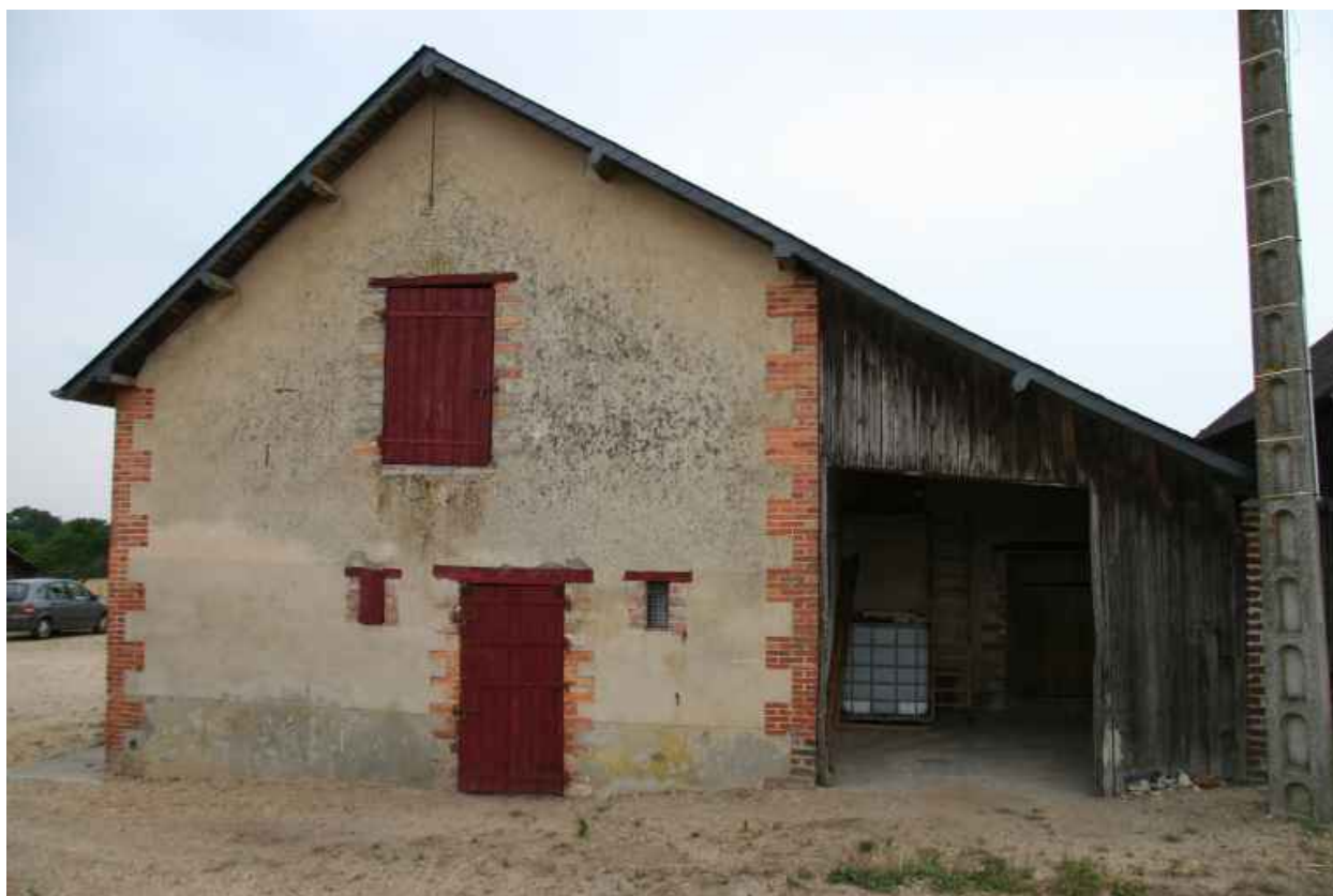
La maison : pignon d'entrée.
