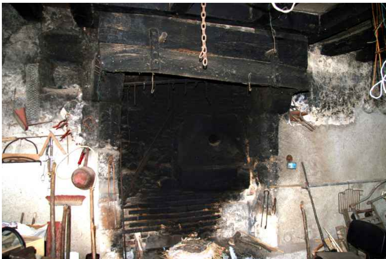
Vieille maison : cheminée et niche.
