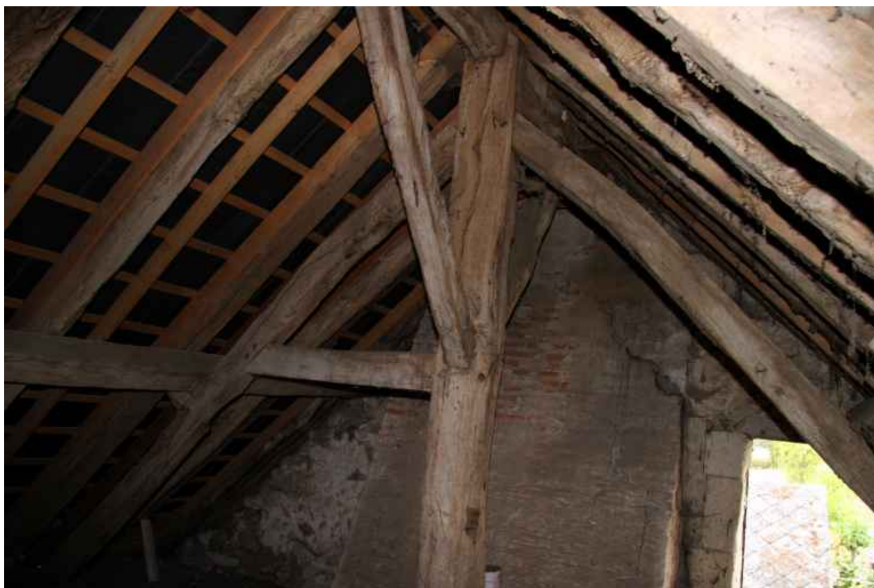
La charpente de la vieille maison.
