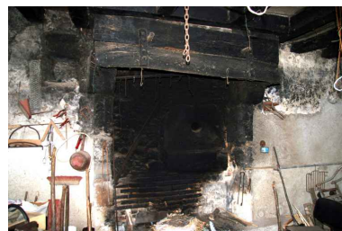
Vieille maison : cheminée et niche. Phot. Jean-Baptiste Darrasse IVR52_20067206512NUCA
