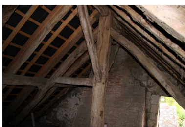
La charpente de la vieille maison. Phot. Jean-Baptiste Darrasse IVR52_20067206516NUCA
