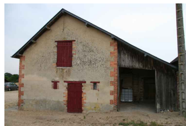
La maison : pignon d'entrée. Phot. Jean-Baptiste Darrasse IVR52_20067206513NUCA
