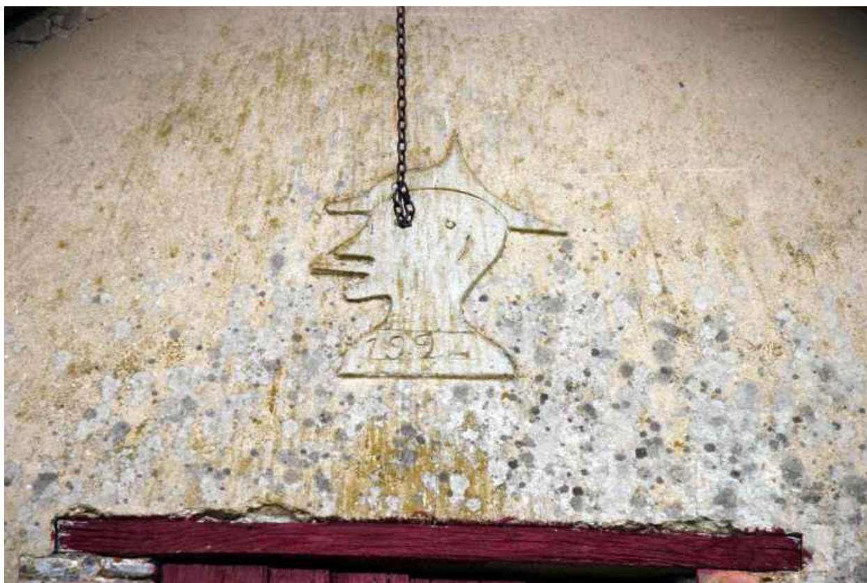
Pignon de la maison portant la date 1922.
