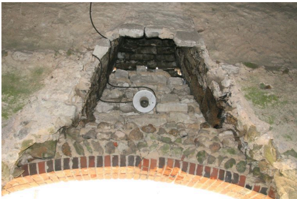
Pignon nord : conduit de cheminée dans le mur.
