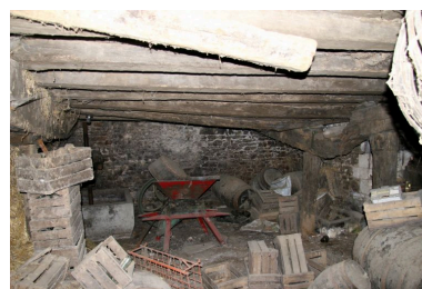
La cave couverte d'un plancher, à droite la porte. Phot. Jean-Baptiste Darrasse IVR52_20077201496NUCA
