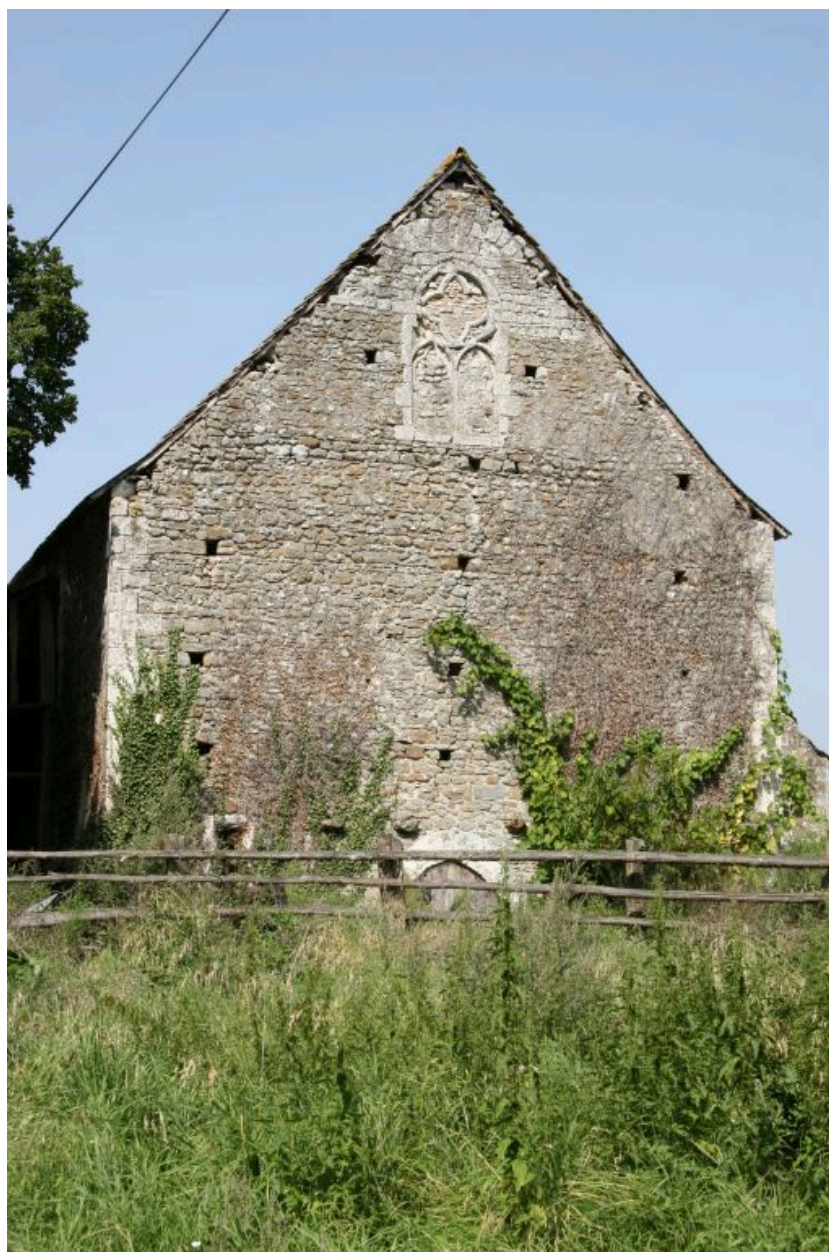
Pignon sud : baie à remplage quadrilobé.
