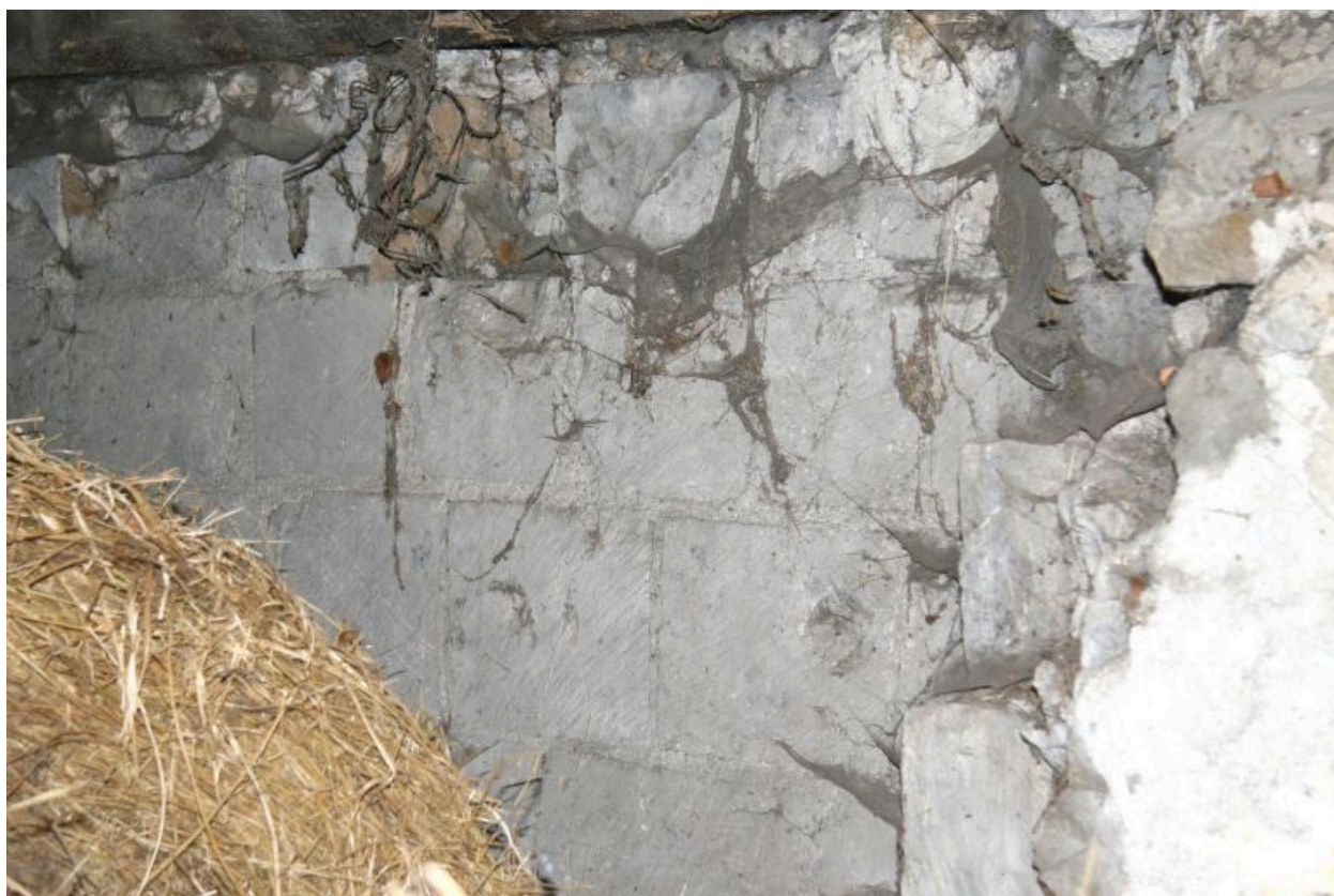
Intérieur du logis, mur ouest : vestige d'un conduit de la première cheminée sur mur goutterot.
