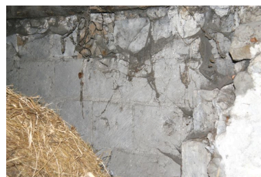
Intérieur du logis, mur ouest : vestige d'u conduit de la prmeière cheminée sur mur goutterot. Phot. Jean-Baptiste Darrasse IVR52_20077201501NUCA
