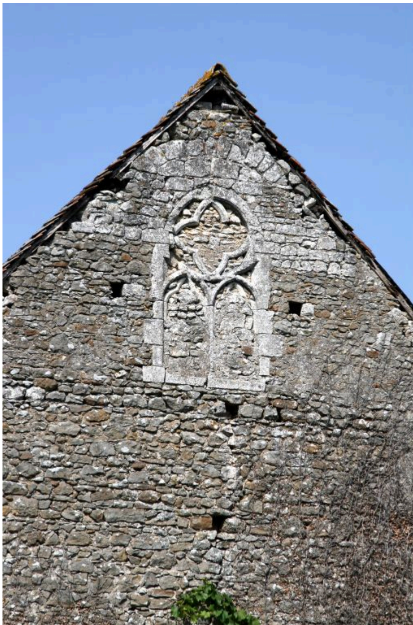
Pignon sud abaissé : baie quadrilobée.
