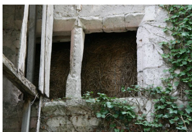
Face ouest, 2e croisée reprise : modification de l'emplacement de la traverse. Phot. Jean-Baptiste Darrasse IVR52_20077201485NUCA
