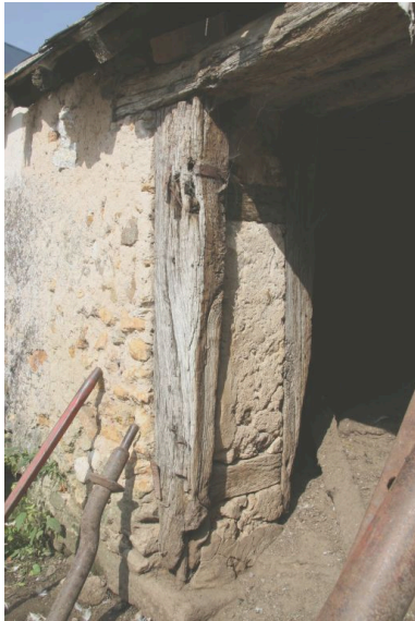
Petite dépendance, détail : cadre en bois pour la porte. Remarquer les fers pour limiter les écartements.
