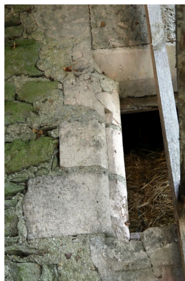
Face ouest, 2e croisée, détail : traverse rehaussée. Phot. Jean-Baptiste Darrasse IVR52_20077201487NUCA
