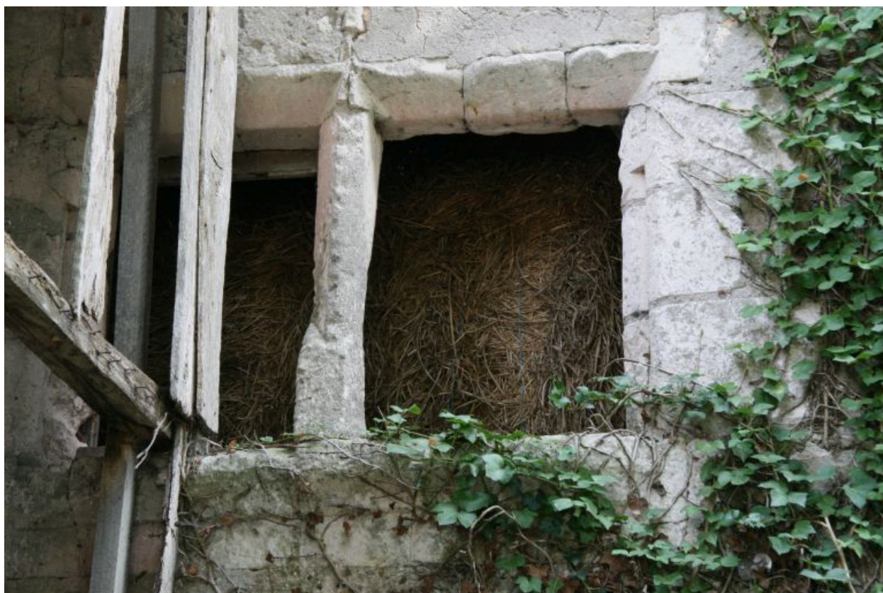
Face ouest, 2e croisée reprise : modification de l'emplacement de la traverse.
