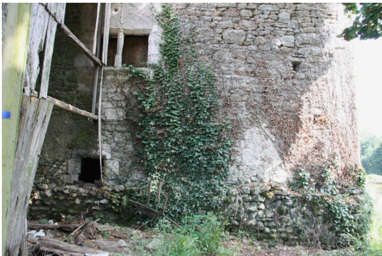
Angle sud-ouest : soubassement de très petits moellons de silex et 2e croisée.
