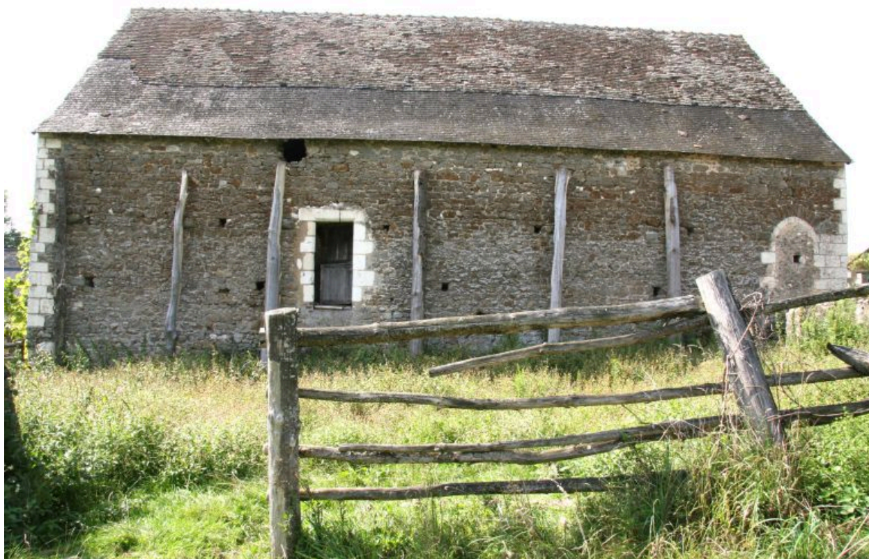
Le logis, façade orientale.
