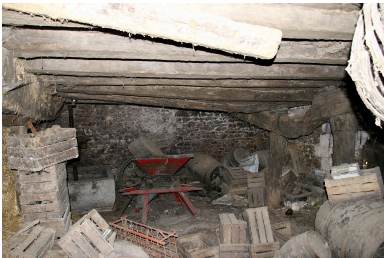
La cave couverte d'un plancher, à droite la porte.
