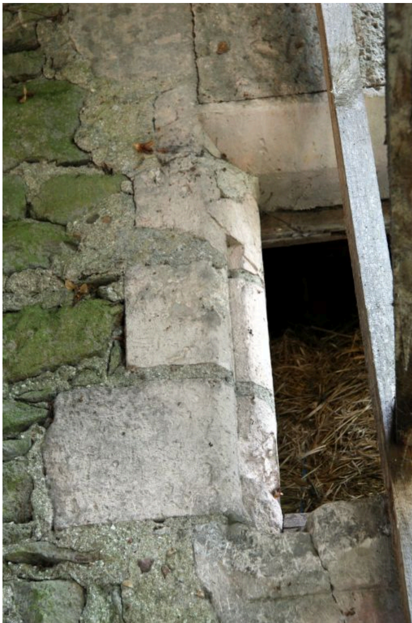
Face ouest, 2e croisée, détail : traverse rehaussée.
