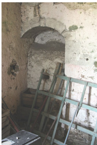
Intérieur du logis : revers de la porte d'entrée dans l'angle nord-est, à droite de l'ancienne cheminée.
