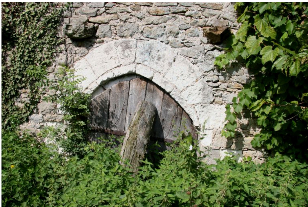
Pignon sud : porte de la cave.
