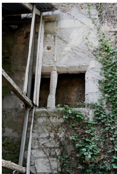
Face ouest, 2e croisée plus ancienne (XIVe siècle ?). Phot. Jean-Baptiste Darrasse IVR52_20077201484NUCA
