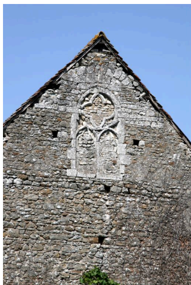
Pignon sud abaissé : baie quadrilobée. Phot. Jean-Baptiste Darrasse IVR52_20077201489NUCA
