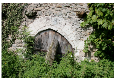
Pignon sud : porte de la cave. Phot. Jean-Baptiste Darrasse IVR52_20077201494NUCA
