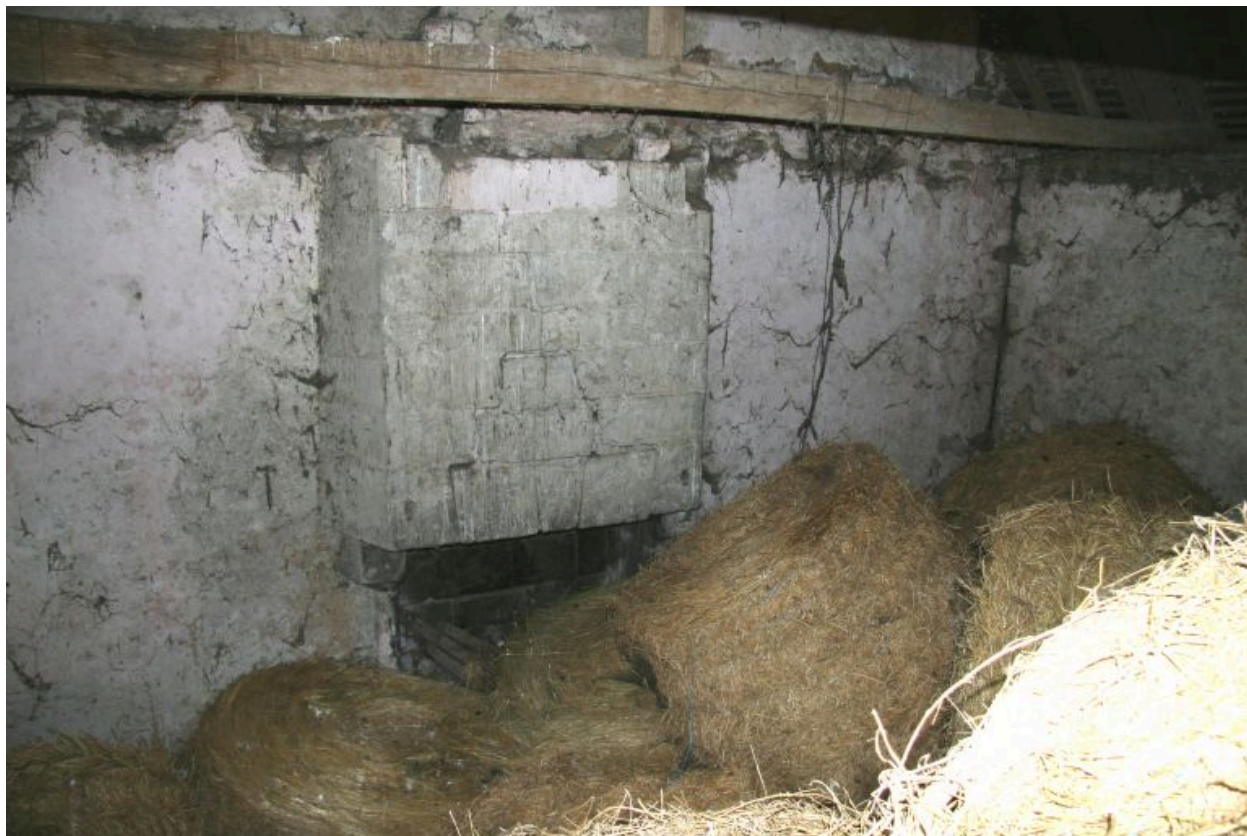
Intérieur du logis, pignon sud : cheminée à hotte droite du XVI e siècle dont le conduit passe devant la baie quadrilobée qui se trouve obstruée.
