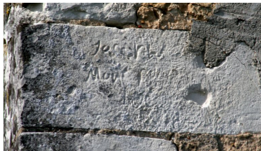
Étables, chaînage d'angle : graffiti de Joseph Montriou. Phot. Jean-Baptiste Darrasse IVR52_20077201515NUCA
