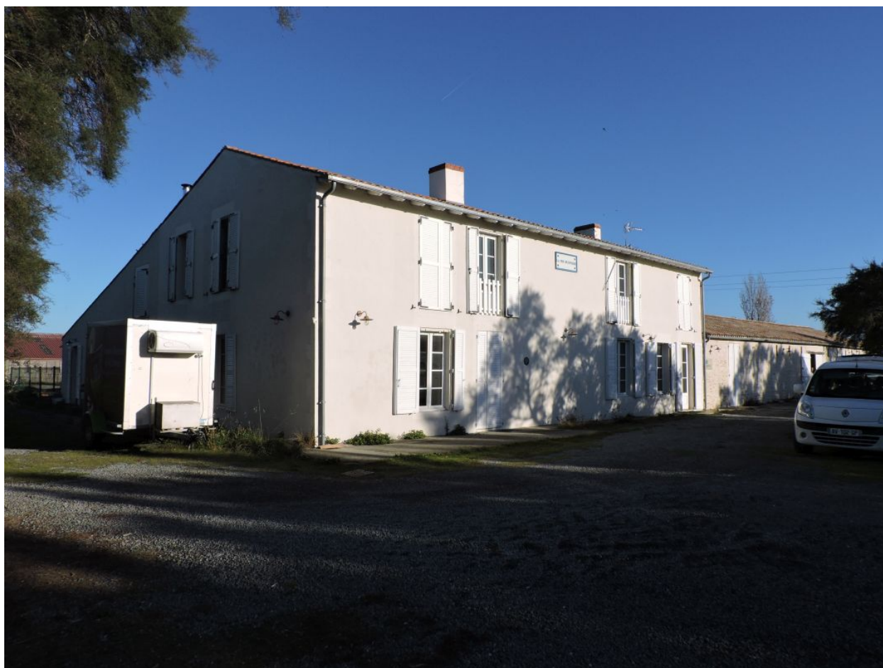
Le logis vu depuis le sud.
