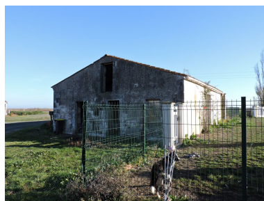
Ancienne dépendance au nord du logis, vue depuis le sud-ouest. Phot. Yannis Suire IVR52_20188500763NUCA
