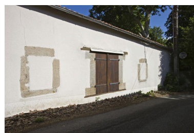
Les dépendances, élévation sur la rue du port de Sem : traces d'un ancien remaniement en habitation. Phot. Yves Guillotin IVR52_20114400595NUCA
