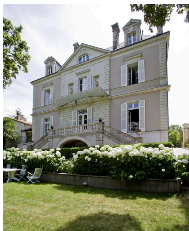
La maison : façade nord sur jardin. Phot. Yves Guillotin IVR52_20104401709NUCA
