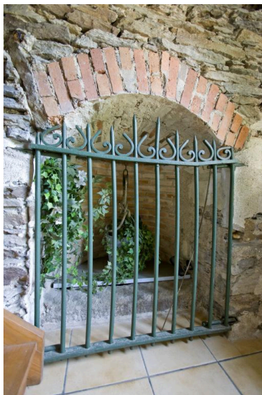
La maison du gardien : le puits, pris dans l'épaisseur du mur pignon. Phot. Yves Guillotin IVR52_20104401731NUCA
