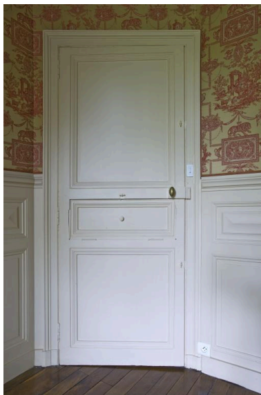
Ancienne salle à manger : porte d'accès à la cuisine avec son passe-plat. Phot. Yves Guillotin IVR52_20104401692NUCA
