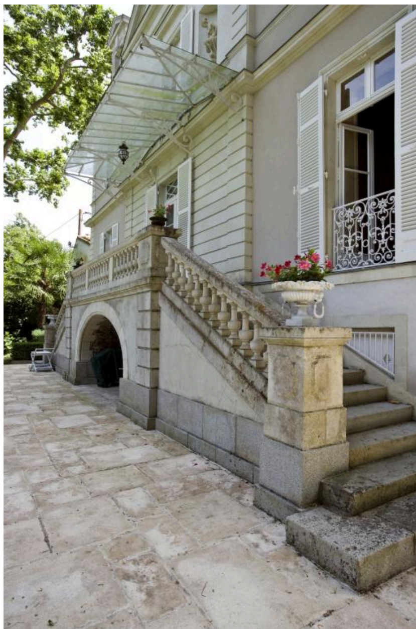
Façade nord : rez-de-chaussée surélevé, détails.
