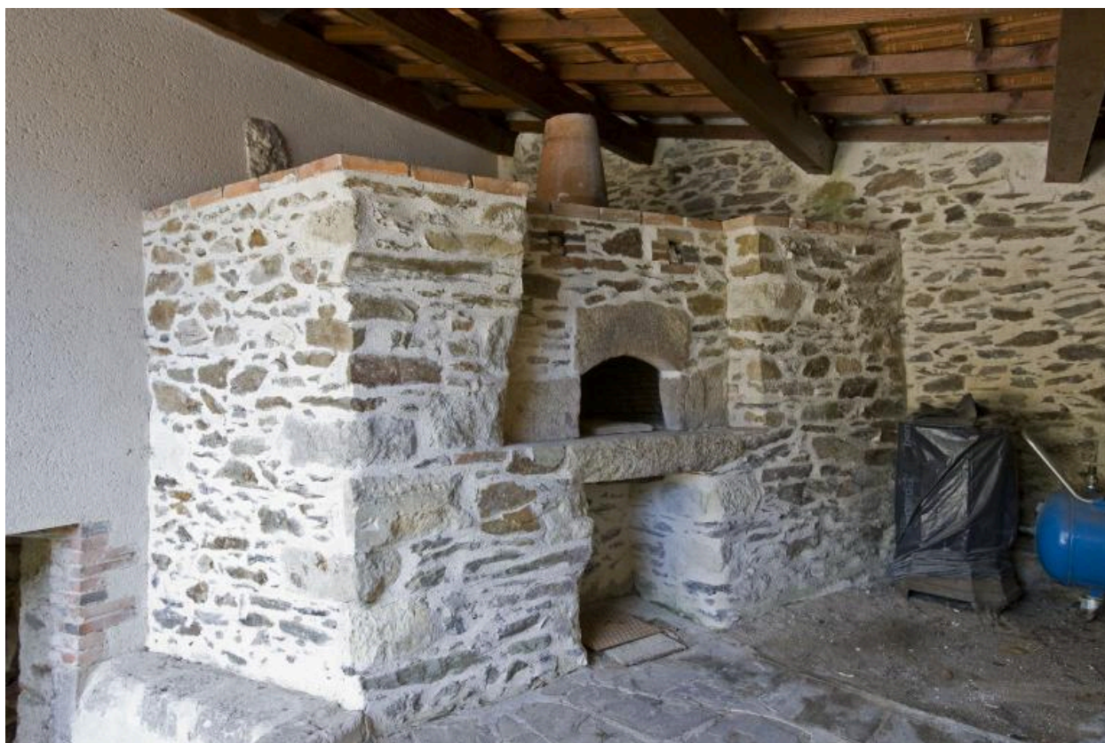
Le four à pain, adossé au pignon sud de la maison de gardien.
