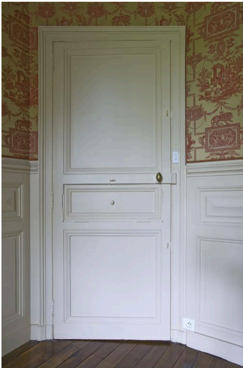
Ancienne salle à manger : porte d'accès à la cuisine avec son passe-plat.
