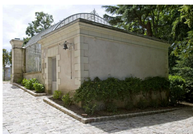
La serre : bâtiment abritant la chaufferie. Phot. Yves Guillotin IVR52_20104401707NUCA
