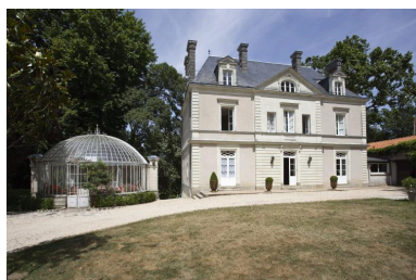
La maison principale : façade sud. Phot. Yves Guillotin IVR52_20104401700NUCA
