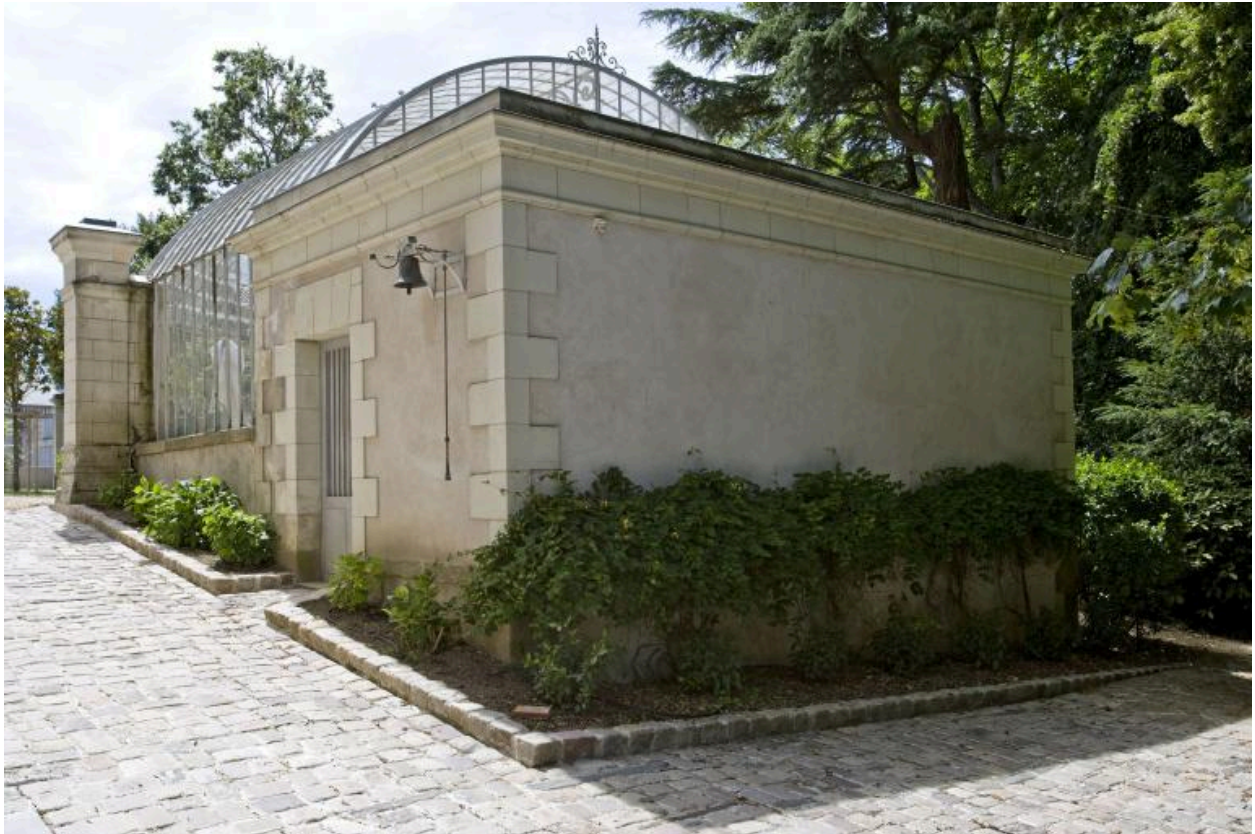
La serre : bâtiment abritant la chaufferie.
