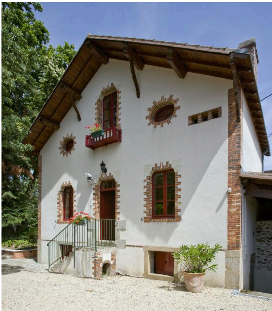
La maison de gardien, conforme aux modèles de la fin du 19e siècle.
