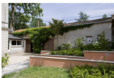
Les dépendances, à l'est de la cour. A gauche, l'extension construite vers 1980. Phot. Yves Guillotin IVR52_20104401723NUCA
