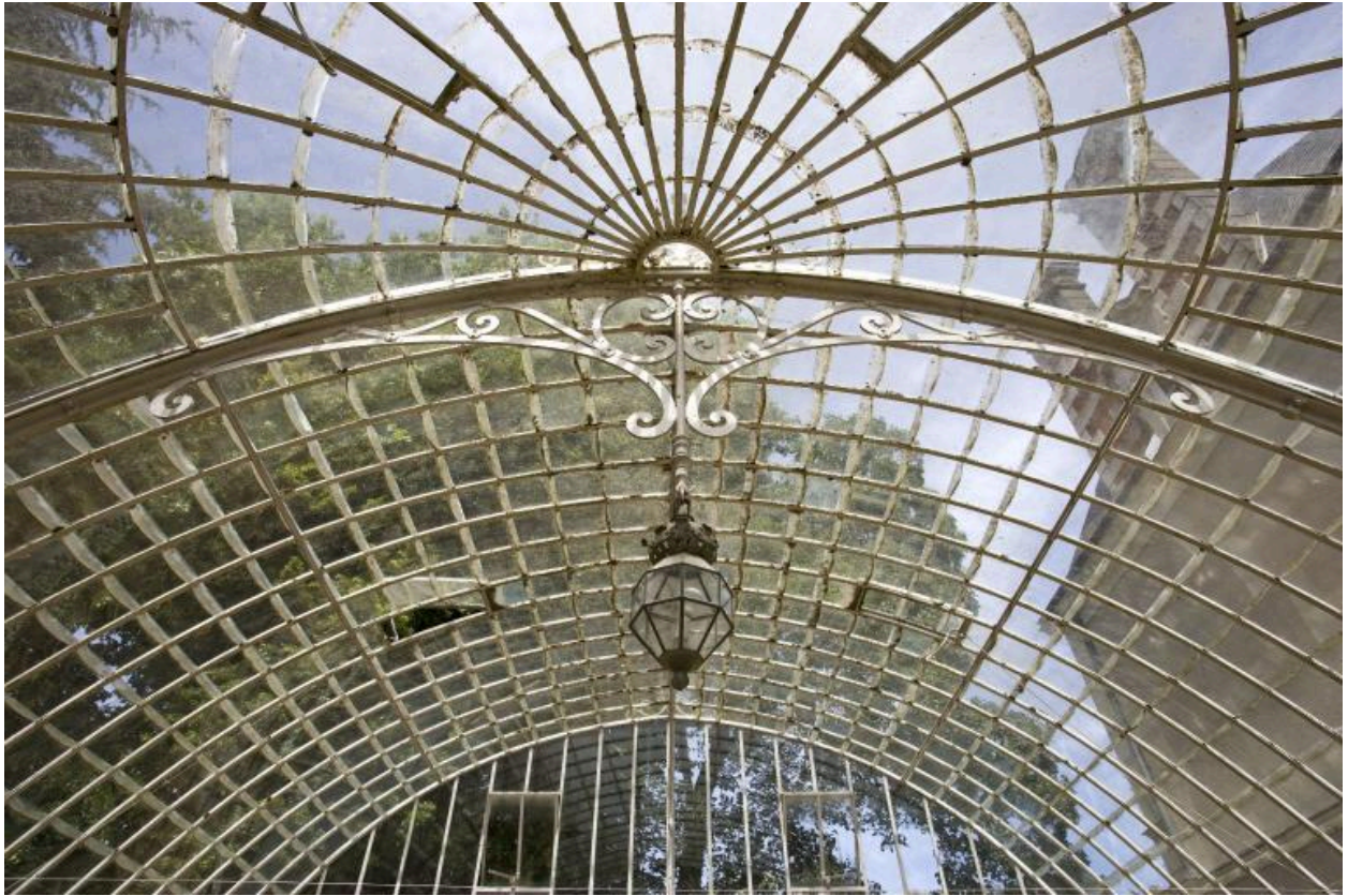
La serre : détail de ferronnerie.
