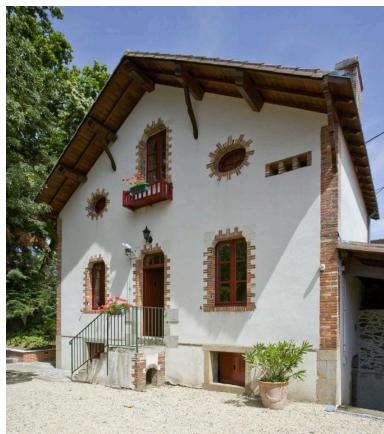
La maison de gardien, conforme aux modèles de la fin du 19e siècle. Phot. Yves Guillotin IVR52_20104401725NUCA
