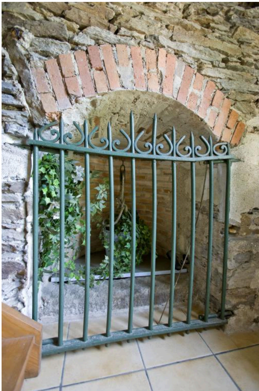
La maison du gardien : le puits, pris dans l'épaisseur du mur pignon.
