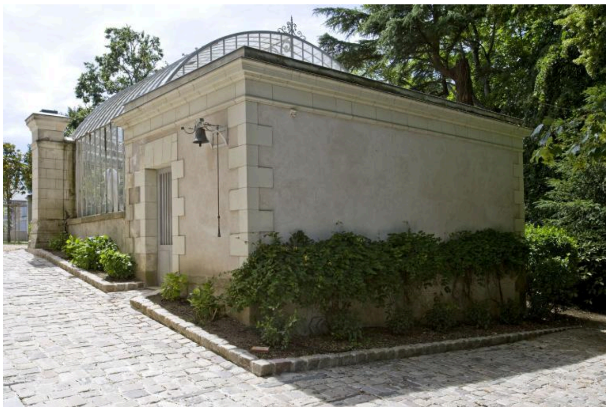
La serre : bâtiment abritant la chaufferie.
