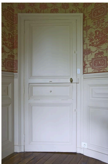
Ancienne salle à manger : porte d'accès à la cuisine avec son passe-plat. Phot. Yves Guillotin IVR52_20104401692NUCA
