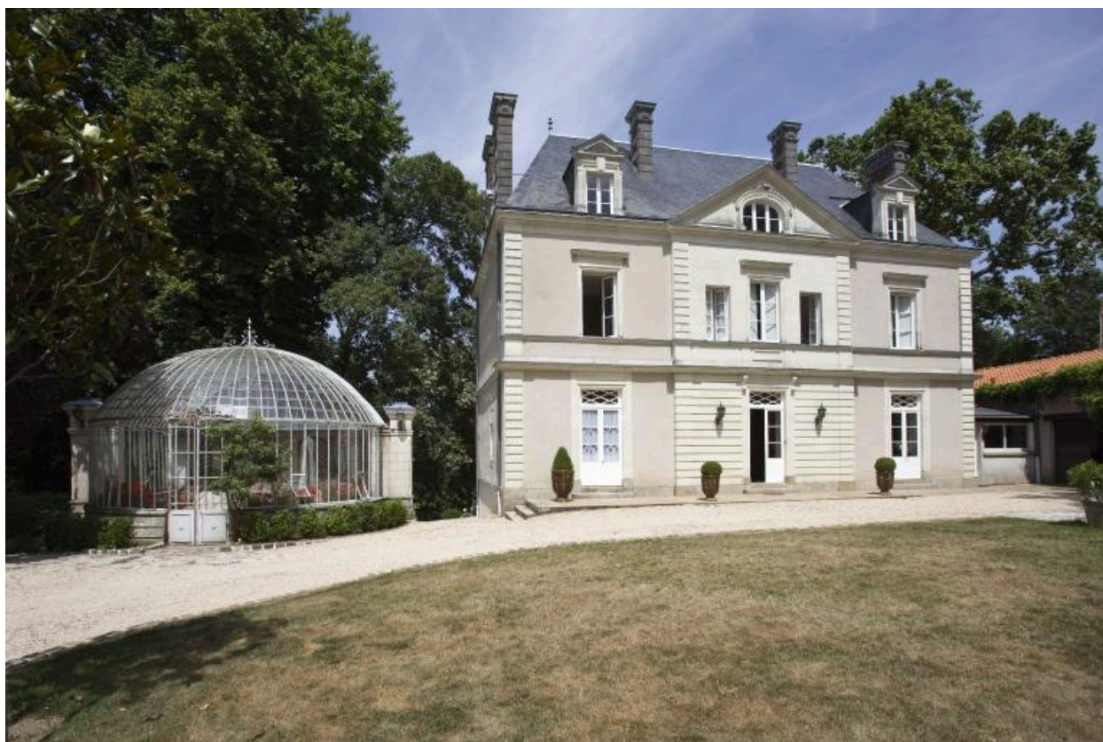
La maison principale : façade sud.
