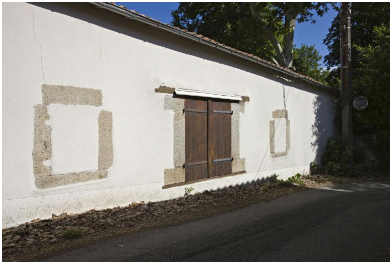
Les dépendances, élévation sur la rue du port de Sem : traces d'un ancien remaniement en habitation.
