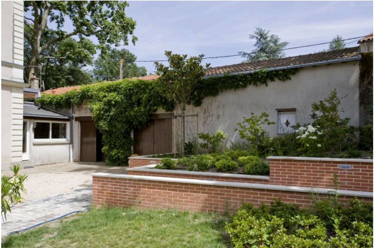
Les dépendances, à l'est de la cour. A gauche, l'extension construite vers 1980.
