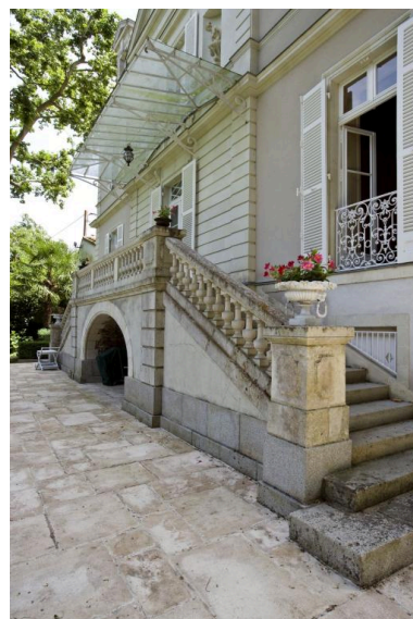
Façade nord : rez-de-chaussée surélevé, détails. Phot. Yves Guillotin IVR52_20104401712NUCA
