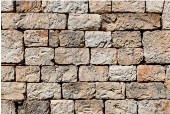
Grange-étable de la ferme des Loges, appareillage en grès blanc (Rennes-en-Grenouilles).
