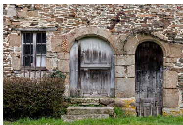
Portes encadrées de blocs de granite, à Montoger (Thuboeuf). Phot. Yves Guillotin IVR52_20195300574NUCA
