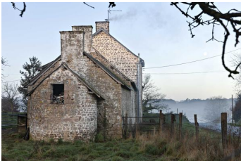
Ferme du Haut-Guené, four à pain surmonté d'un séchoir, contre le pignon d'une des maisons
