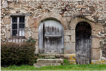
Portes encadrées de blocs de granit, à Montoger (Thuboeuf).
