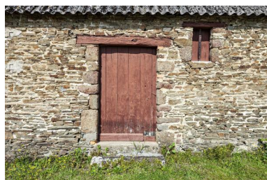
Porte d'étable, entourée d'une maçonnerie de moellon de schiste et de grès, surmontée d'un linteau de bois, à la Conillère (La Baroche-Gondouin). Phot. Yves Guillotin IVR52_20215300864NUCA
