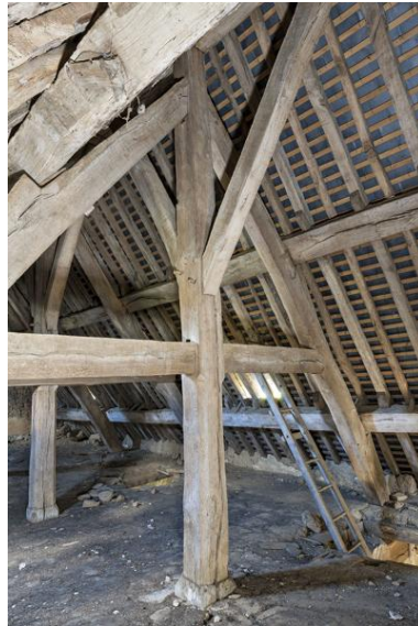
Charpente d'un manoir. Phot. Yves Guillotin IVR52_20185300487NUCA
