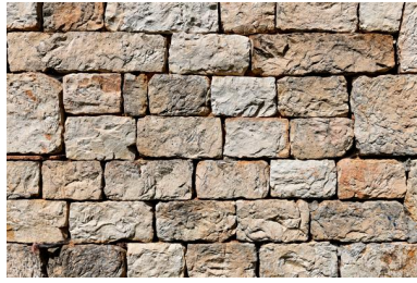
Grange-étable de la ferme des Loges, appareillage en grès blanc (Rennes-en-Grenouilles). Phot. Yves Guillotin IVR52_20195300443NUCA
