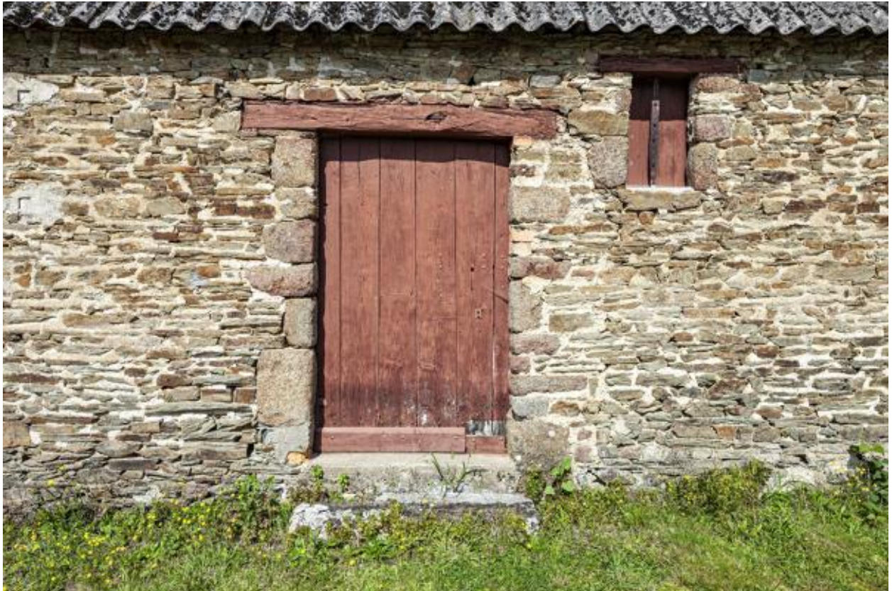
Porte d'étable, entourée d'une maçonnerie de moellon de schiste et de grès, surmontée d'un linteau de bois, à la Conillère (La Baroche-Gondouin).
