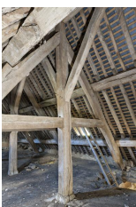
Charpente d'un manoir.
