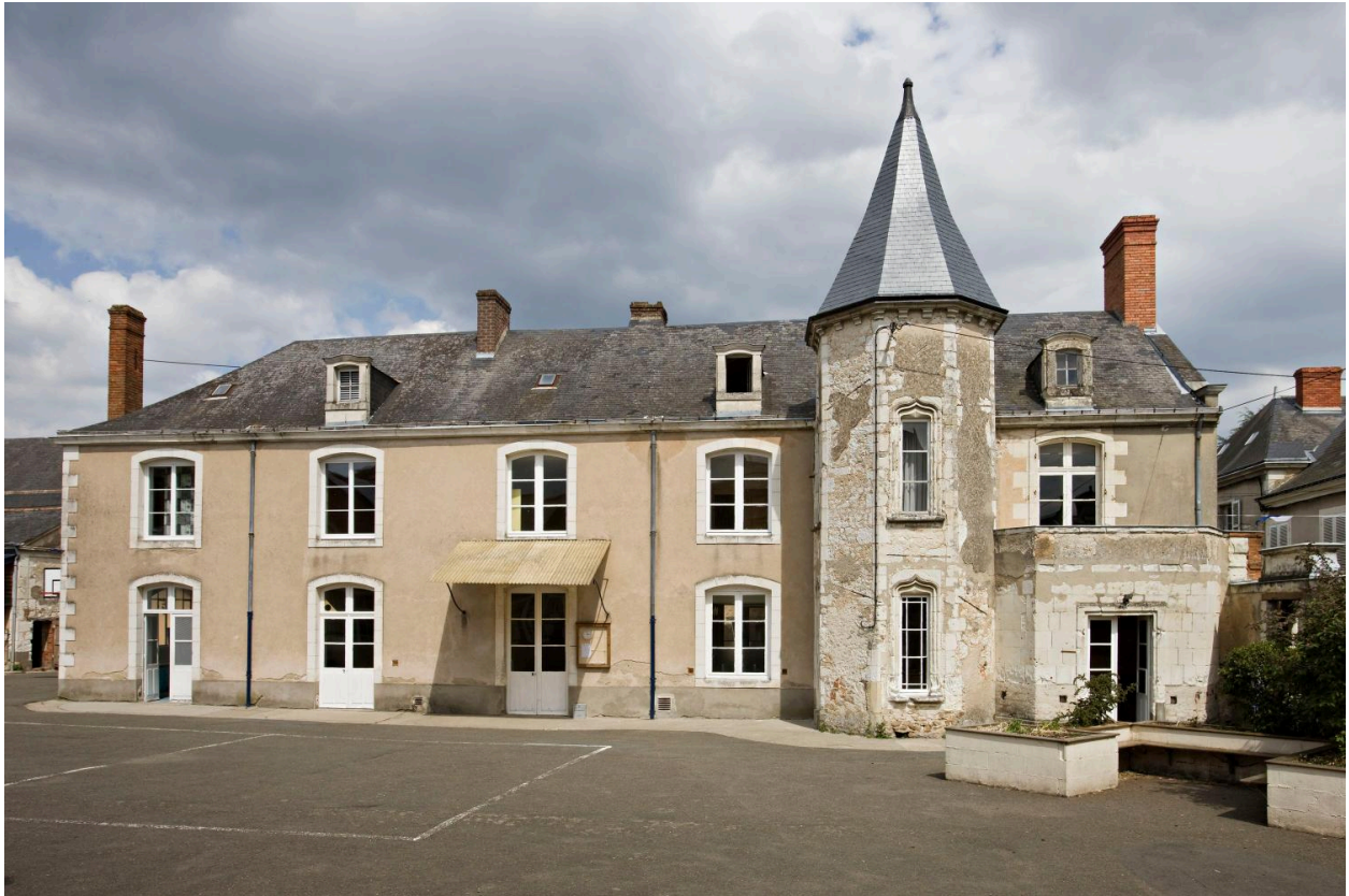
Façade antérieure sur cour.
