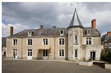
Façade antérieure sur cour. Phot. Yves Guillotin IVR52_20117200762NUCA
