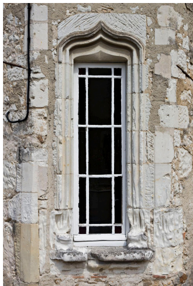
Façade antérieure sur cour, tourelle, détail : demie baie du rez-de-chaussée. Phot. Yves Guillotin IVR52_20117200760NUCA
