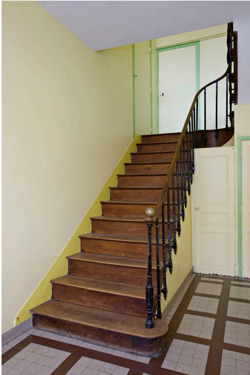
Escalier dans l'aile basse attenante au logis..
