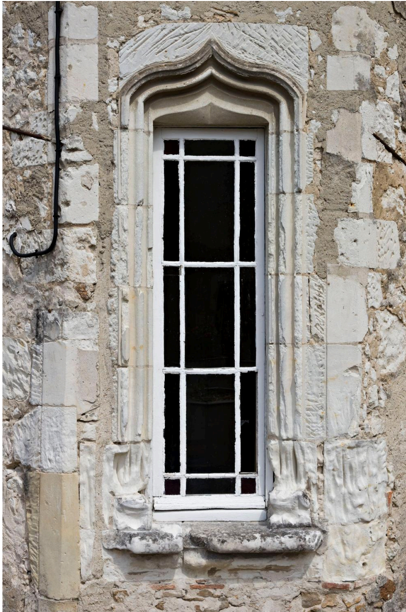
Façade antérieure sur cour, tourelle, détail : demie baie du rez-de-chaussée.
