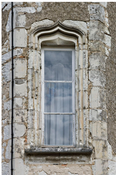
Tourelle d'escalier, détail : fenêtre. Phot. Yves Guillotin IVR52_20117200761NUCA
