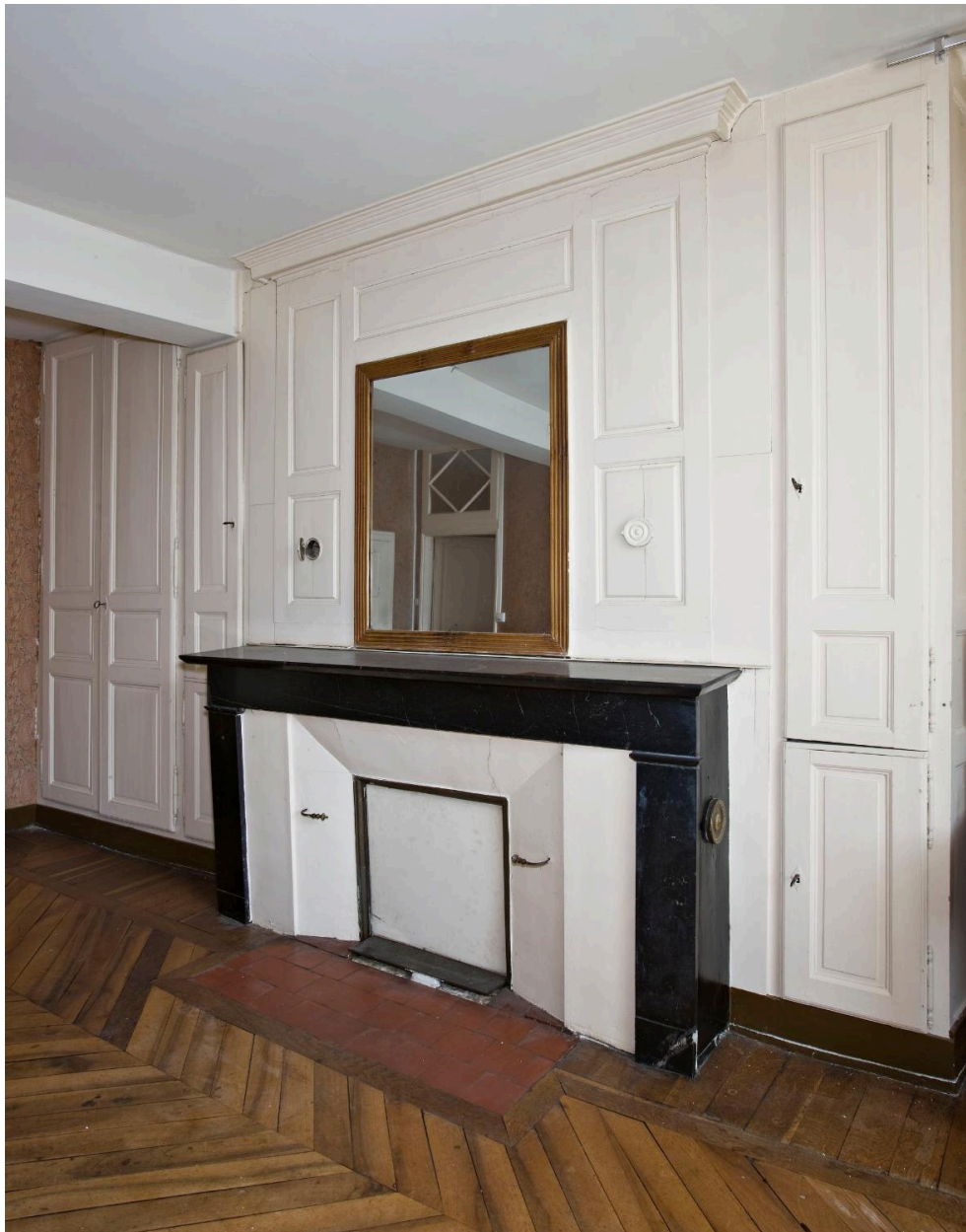
Le logis, 1er étage, chambre 2 : cheminée et lambris.
