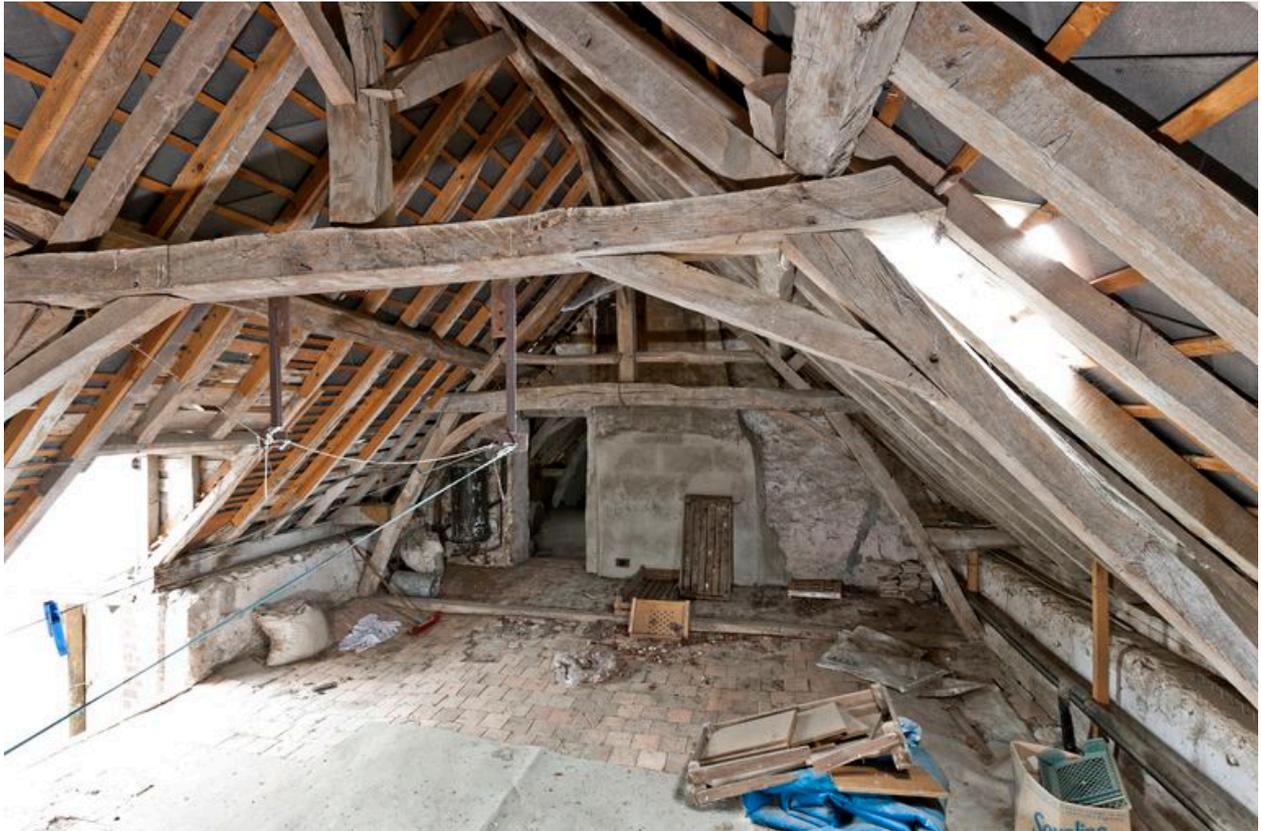
La charpente à pannes primitive a été remaniée : les entrails sont retirés et les poinçons coupés sont supportés par une potence.
