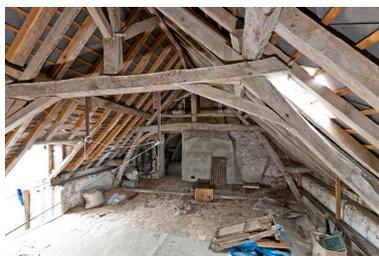
La charpente à pannes primitive a été remaniée : les entrants sont retirés et les poinçons coupés sont supportés par une potence.
