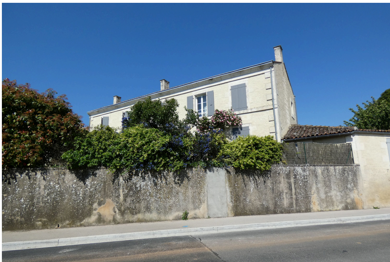
Le logis vu depuis l'est.
