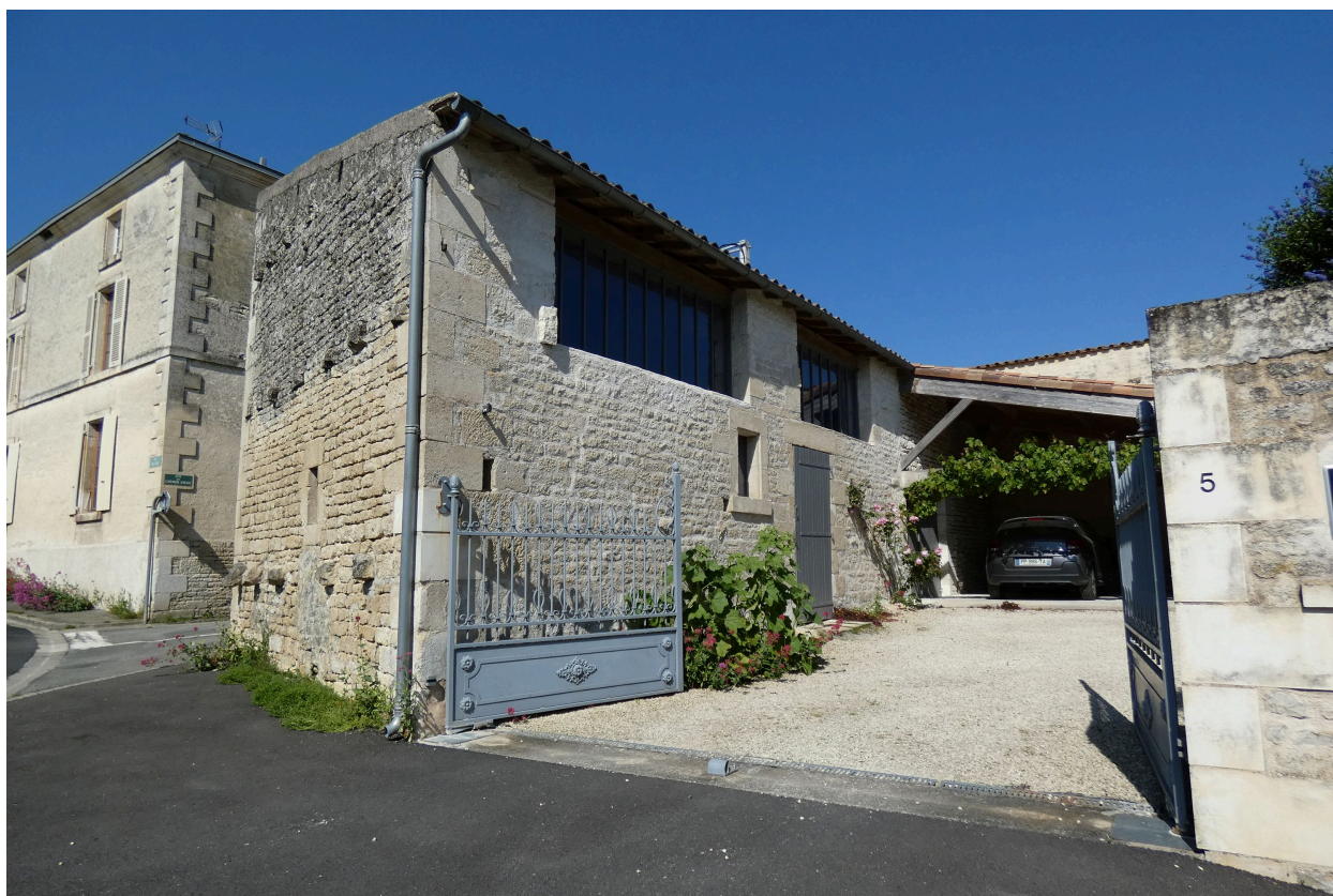
Les dépendances, étable et fenil, sur le côté ouest de la cour.
