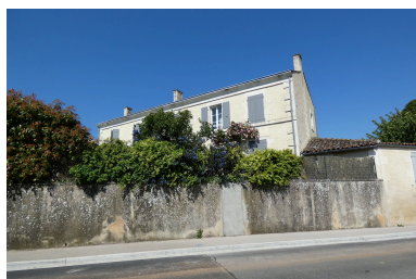
Le logis vu depuis l'est. Phot. Yannis Suire IVR52_20238501713NUCA
