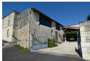
Les dépendances, étable et fenil, sur le côté ouest de la cour. Phot. Yannis Suire IVR52_20238501695NUCA
