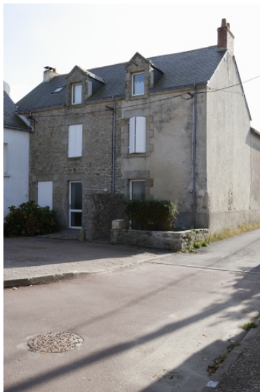
Vue d'ensemble depuis le nord. Phot. Denis Pillet IVR52_20074401359NUCA
