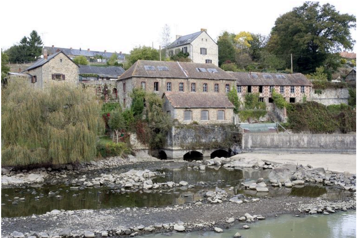
Vue d'ensemble de l'usine depuis l'aval, pendant les écourues de 2009.
