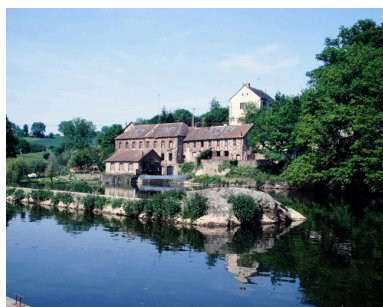
Vue d'ensemble de l'usine depuis la rive gauche en amont. Phot. François Lasa IVR52_19985300090XA
