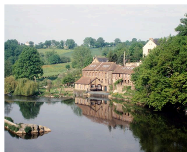
Vue d'ensemble de l'usine depuis le pont de Rochefort. Phot. François Lasa IVR52_19985300076XA
