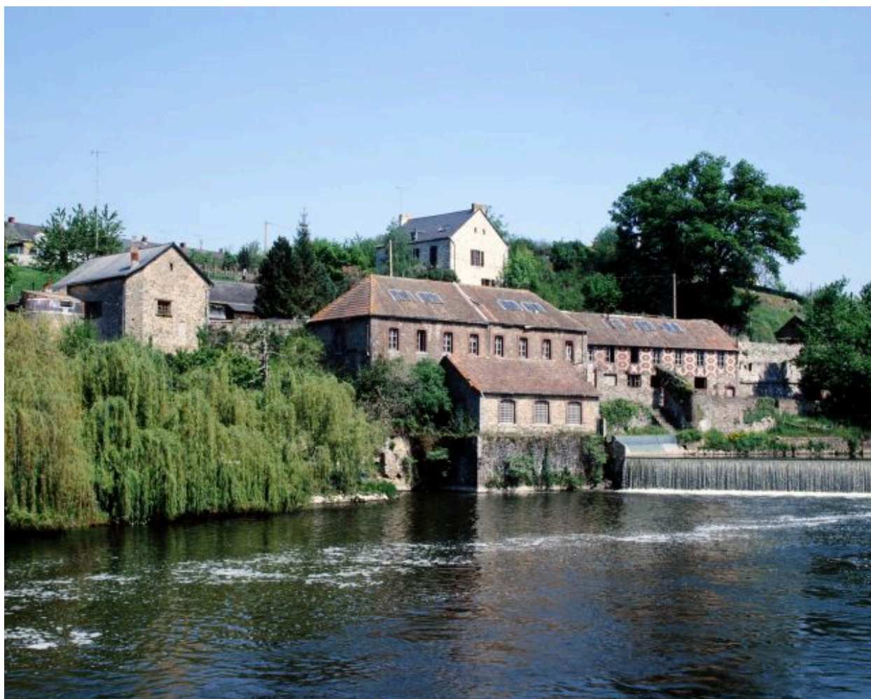
Vue d'ensemble de l'usine depuis la rive gauche en aval.
