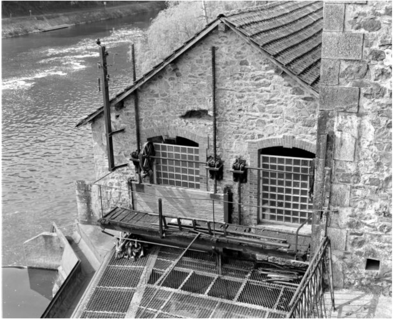
Pignon nord du bâtiment abritant les turbines. Au-devant la vanne motrice.
