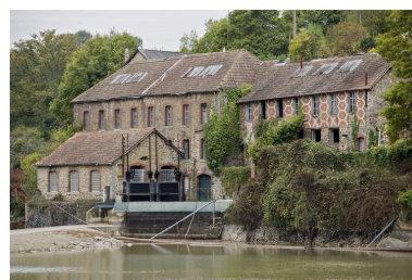
Les deux corps principaux de l'usine et le bâtiment des turbines, vus depuis l'amont, pendant les écources de 2009. Phot. Yves Guillotin IVR52_20095300467NUCA
