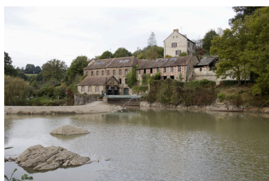
Vue d'ensemble de l'usine depuis l'amont, pendant les écources de 2009. Phot. Yves Guillotin IVR52_20095300460NUCA
