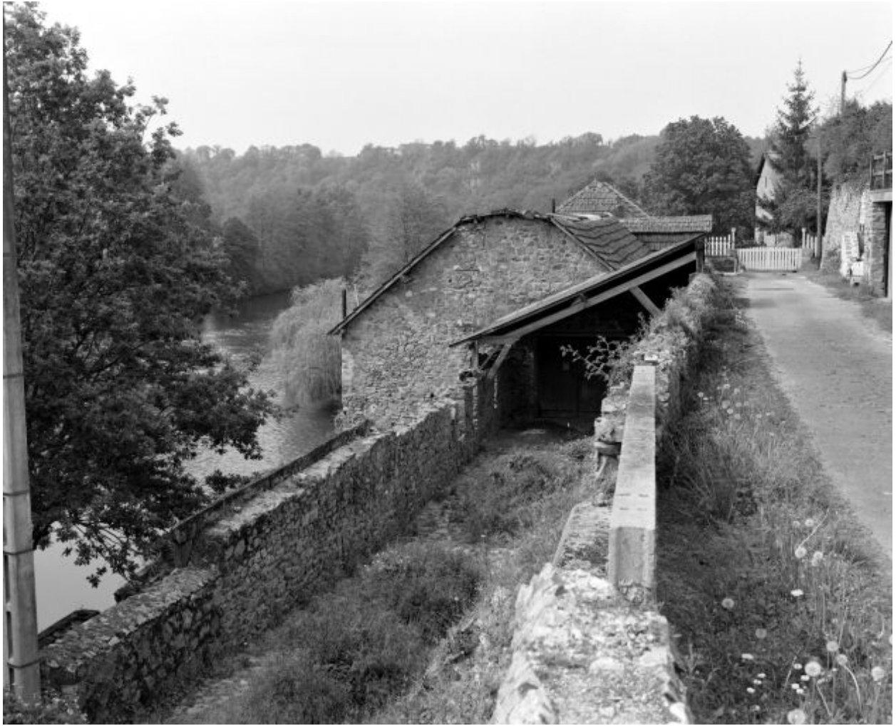
L'entrée principale (au nord) des bâtiments contenant les ateliers de fabrication.
