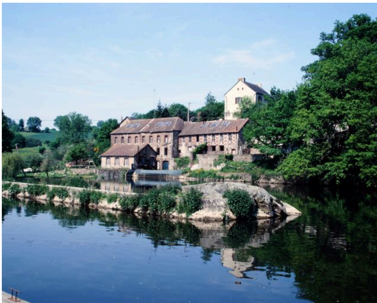
Vue d'ensemble de l'usine depuis la rive gauche en amont.
