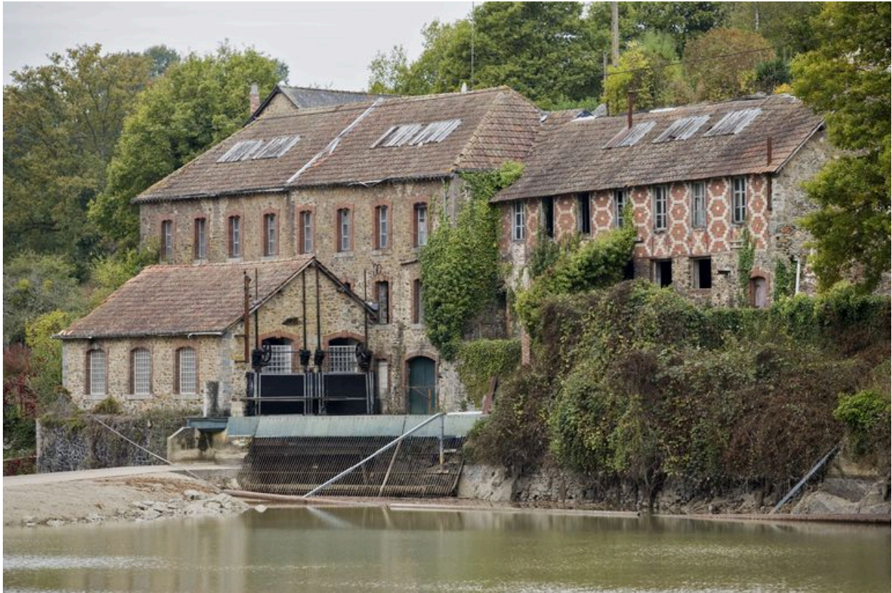
Les deux corps principaux de l'usine et le bâtiment des turbines, vus depuis l'amont, pendant les écoures de 2009.
