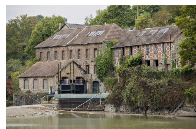
Les deux corps principaux de l'usine et le bâtiment des turbines, vus depuis l'amont, pendant les écoures de 2009. Phot. Yves Guillotin
