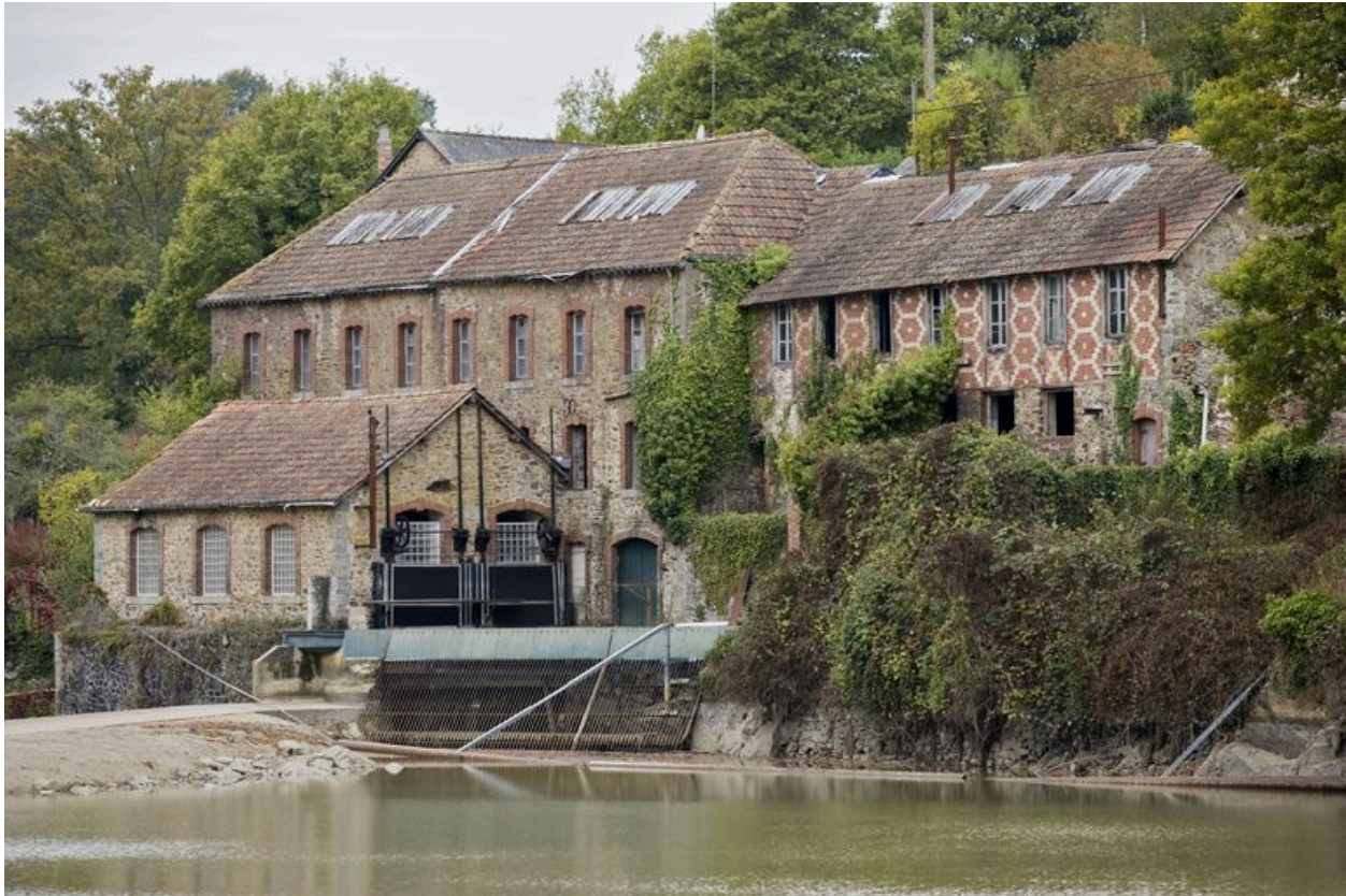
Les deux corps principaux de l'usine et le bâtiment des turbines, vus depuis l'amont, pendant les écourues de 2009.
