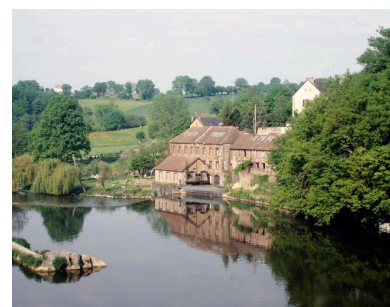
Vue d'ensemble de l'usine depuis le pont de Rochefort. Phot. François Lasa IVR52_19985300076XA
