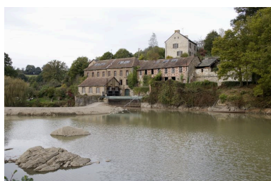
Vue d'ensemble de l'usine depuis l'amont, pendant les écoures de 2009. Phot. Yves Guillotin IVR52_20095300460NUCA
