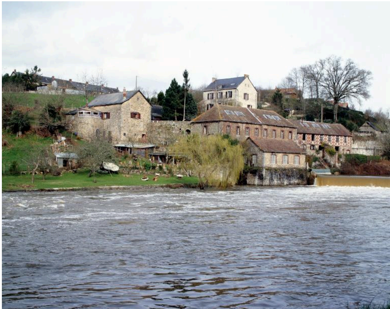
Vue d'ensemble de l'usine depuis la rive gauche en aval.
