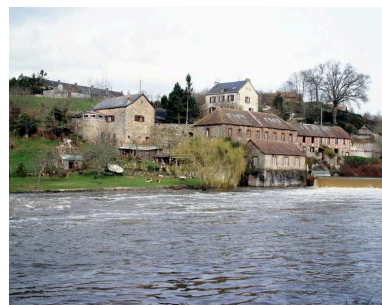
Vue d'ensemble de l'usine depuis la rive gauche en aval. Phot. François Lasa IVR52_20025300399XA
