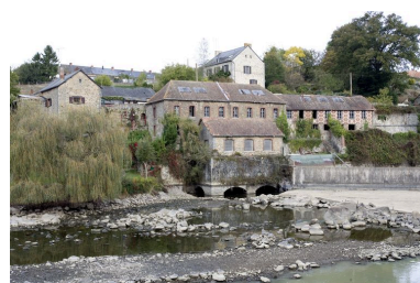
Vue d'ensemble de l'usine depuis l'aval, pendant les écoures de 2009. Phot. Yves Guillotin IVR52_20095300463NUCA
