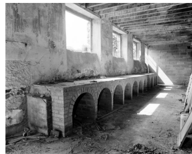
Salle de préparation des métaux, appelée laboratoire.
