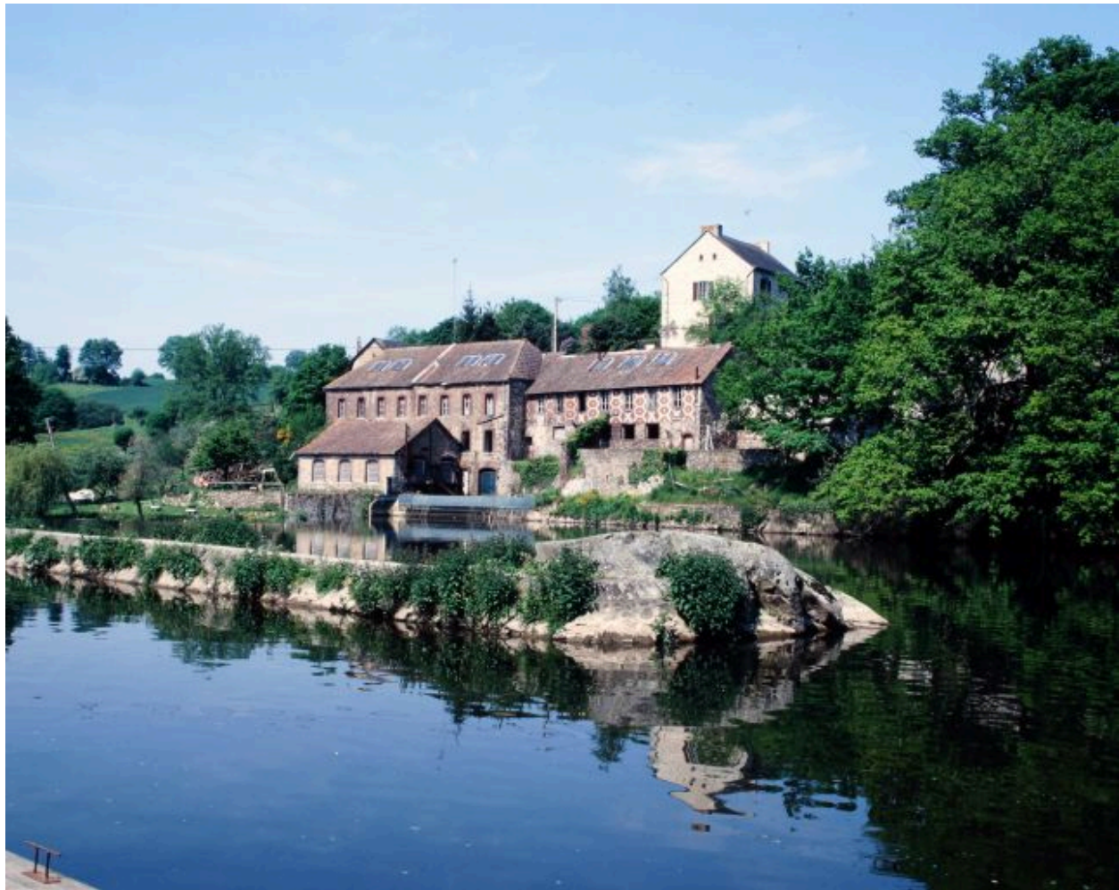
Vue d'ensemble de l'usine depuis la rive gauche en amont.
