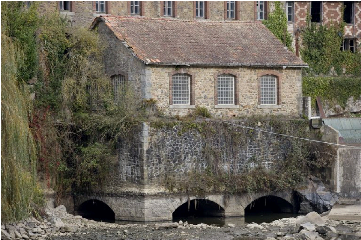
Le bâtiment des turbines vu depuis l'aval, pendant les écourues de 2009.
