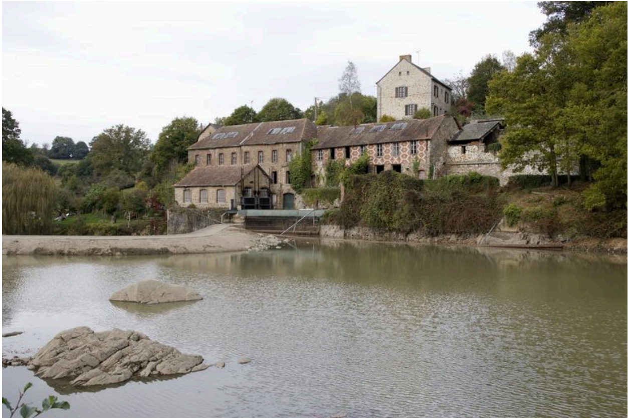
Vue d'ensemble de l'usine depuis l'amont, pendant les écourues de 2009.
