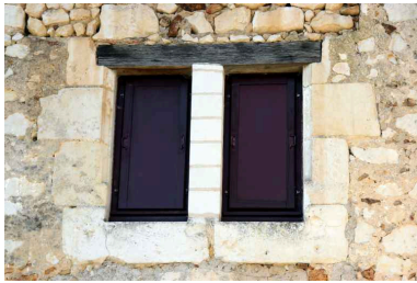
La croisée du XVI e s. a disparu pour laisser la place à une baie récente remontée avec une partie des anciens jambages. Phot. Jean-Baptiste Darrasse IVR52_20067205659NUCA
