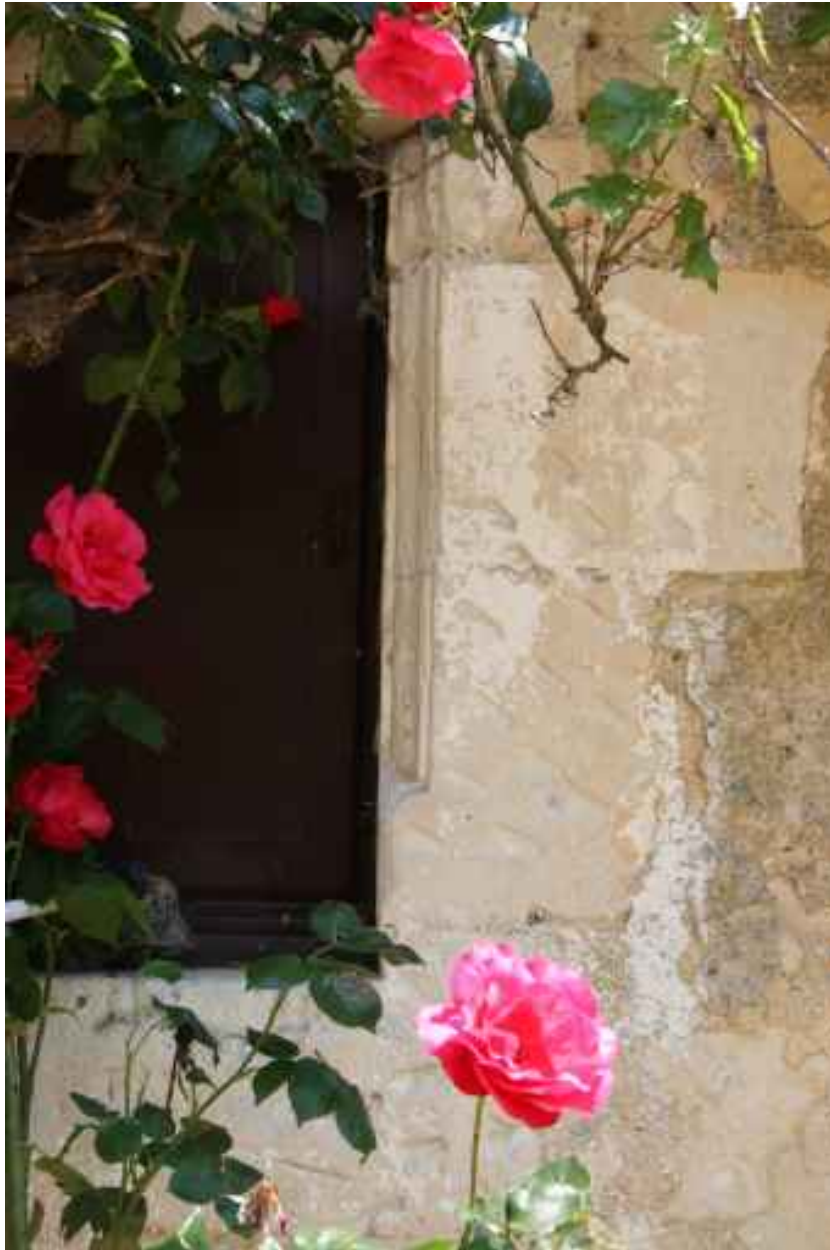
Le logis, façade antérieure, détail : baie avec moulures du XVIe s.
