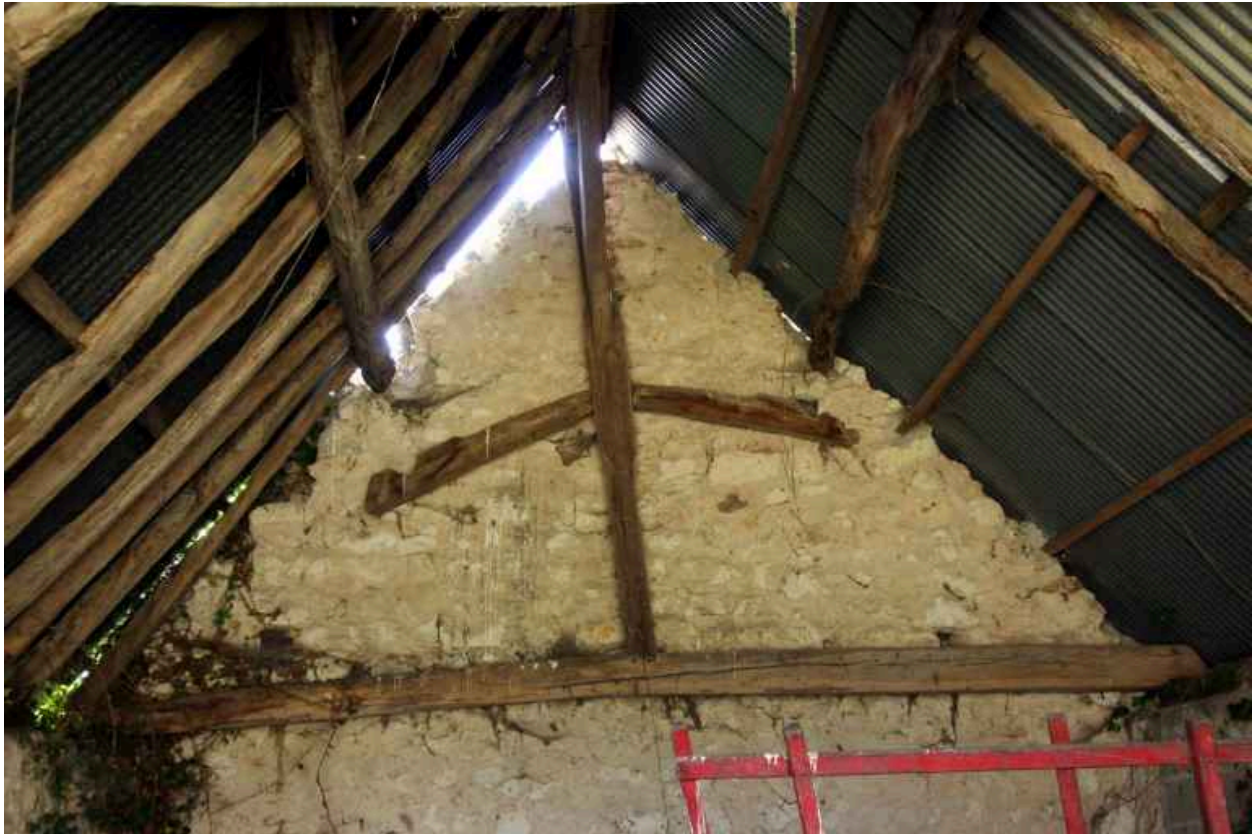
Ancienne grange : vestiges de la charpente à pannes.
