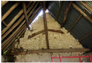
Ancienne grange : vestiges de la charpente à pannes. Phot. Jean-Baptiste Darrasse IVR52_20067205654NUCA
