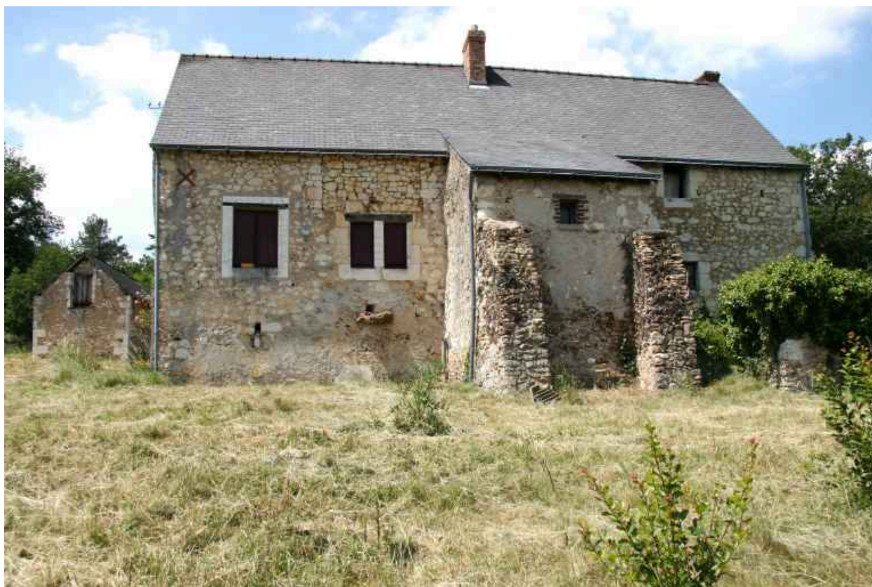
Le logis, façade postérieure.
