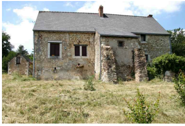
Le logis, façade postérieure. Phot. Jean-Baptiste Darrasse IVR52_20067205656NUCA
