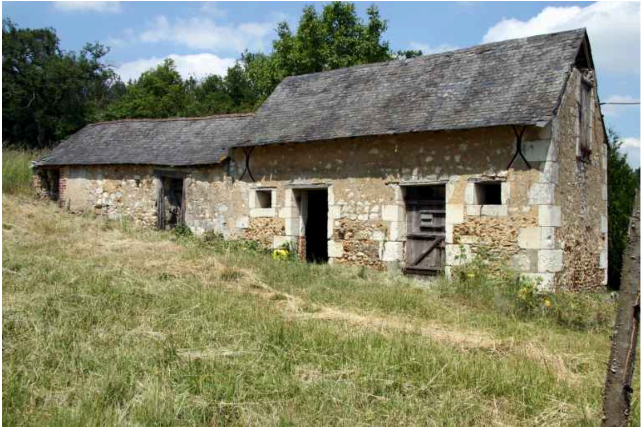
Toit à porcs et écuries.
