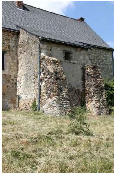
Le logis, façade postérieure : appenti avec contreforts. Phot. Jean-Baptiste Darrasse IVR52_20067205657NUCA
