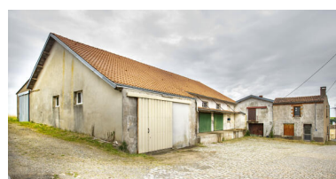
Façade et quai du magasin ; à gauche, accès au local de lavage des fûts. Phot. Pierre-Bernard Fourny IVR52_20224400259NUCA
