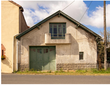
Bâtiment de bureaux. Phot. Pierre-Bernard Fourny IVR52_20234400172NUCA
