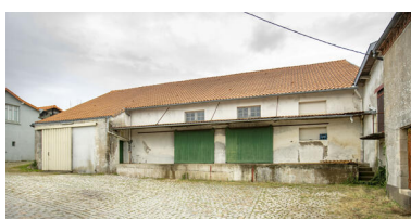
Façade et quai du magasin Phot. Pierre-Bernard Fourny IVR52_20224400258NUCA
