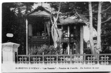
Premier état, élévation antérieure. Carte postale, [début 20e siècle]. Repro. Denis Pillet IVR52_19954400099X
