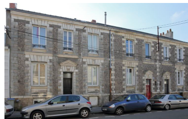
Rue Duplex, lotissement la Maisonnnette, construit en 1910. Phot. Denis Pillet IVR52_20134401274NUCA
