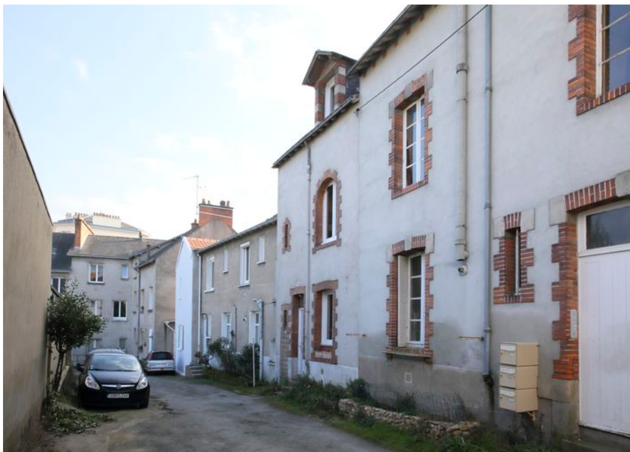
Rue Dupleix, façades arrières d'immeubles.
