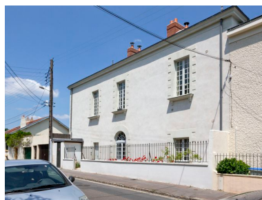
Maison construite au XVIIIe siècle. Phot. Denis Pillet IVR52_20134402233NUCA
