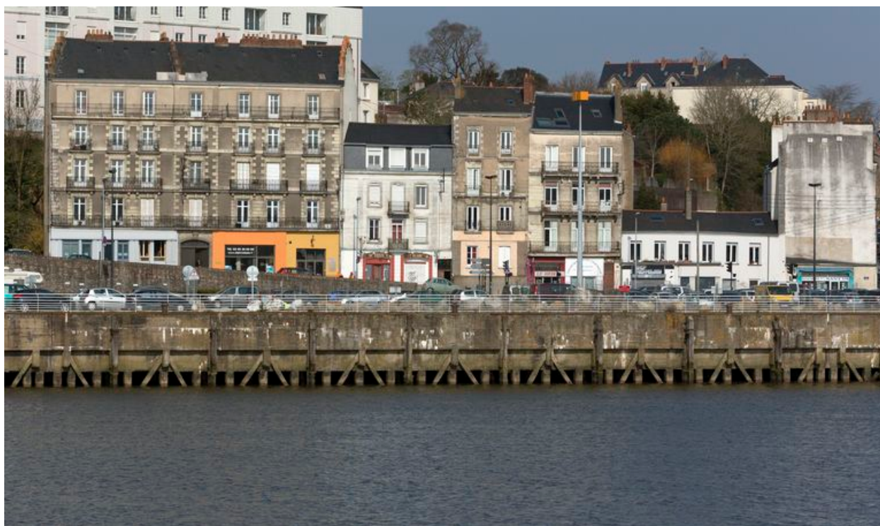
Rue de l'Hermitage, immeubles alignés en 1857.
