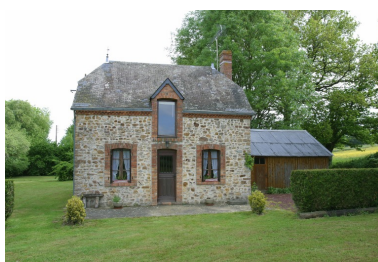
Le logis, vu du sud. Phot. François Lasa IVR52_20035301694NUCA
