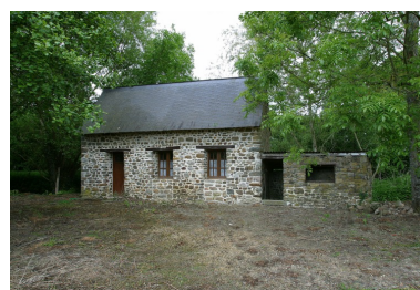
L'ancienne porcherie. Phot. François Lasa IVR52_20035301693NUCA
