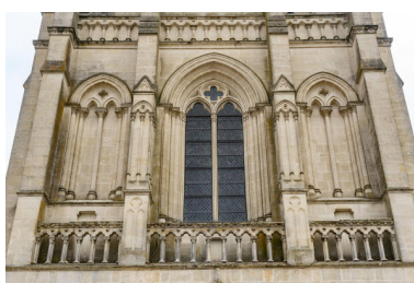
La fenêtre et les arcatures de la façade occidentale. Phot. Pierre-Bernard Fourny IVR52_20215301149NUCA
