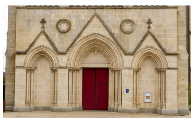
Le portail principal. Phot. Pierre-Bernard Fourny IVR52_20215301147NUCA
