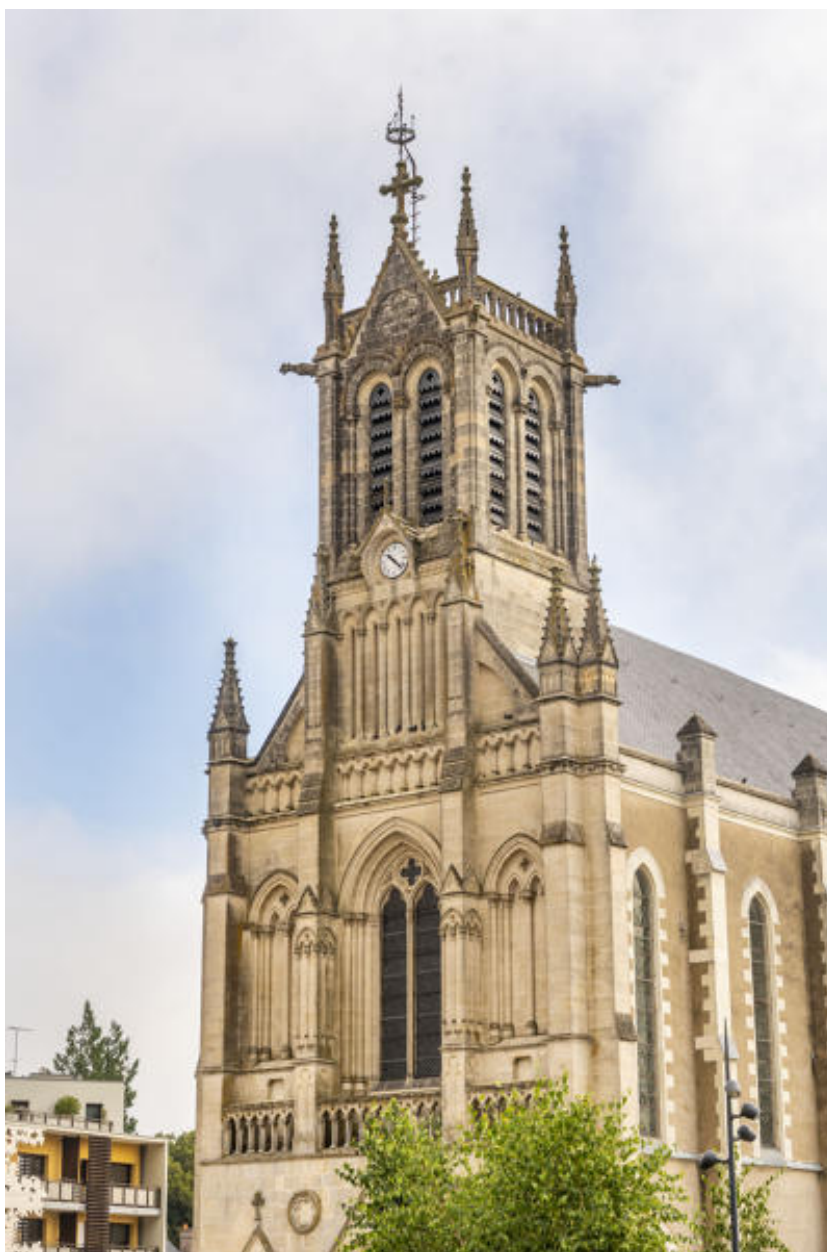
La façade occidentale et le clocher.
