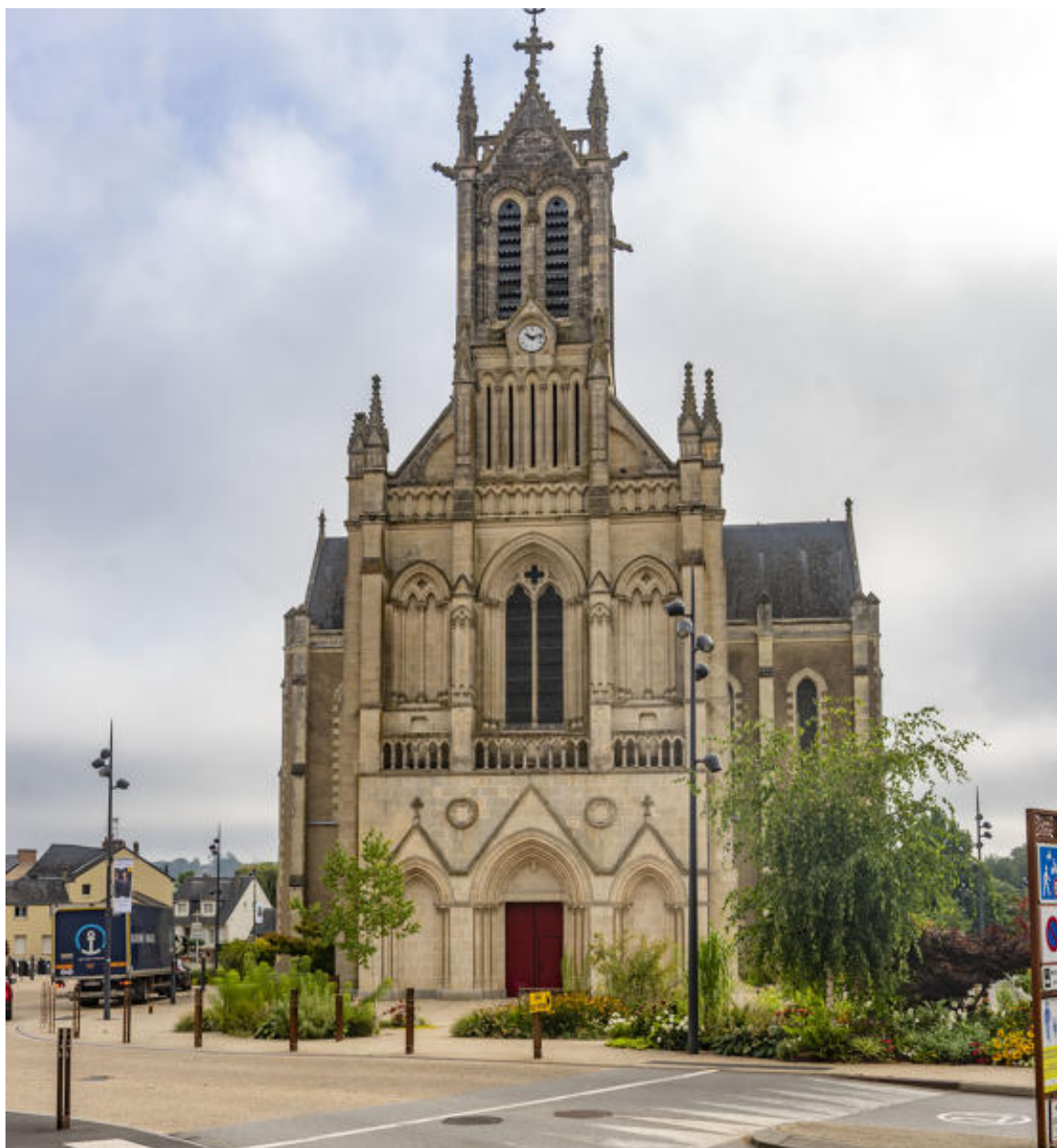
La façade occidentale.
