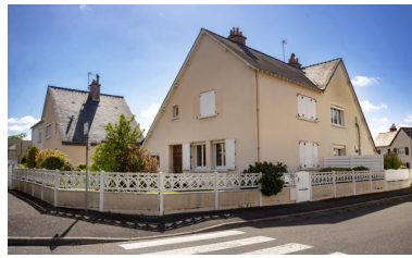
Vue d'un pavillon double de 4 pièces pour agents de maîtrise. Phot. Pierre-Bernard Fourny IVR52_20217200632NUCA
