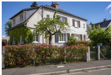
Vue d'un pavillon pour agents de maîtrise de type A. Phot. Pierre-Bernard Fourny IVR52_20217200629NUCA
