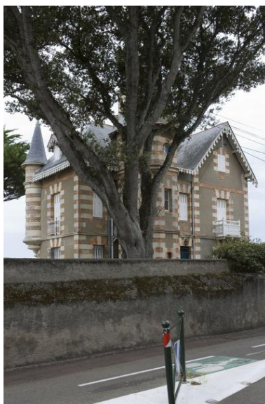
Villa Ker Awil, vue du sud-est. Phot. Denis Pillet IVR52_20094400675NUCA
