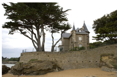
Villa Ker Awil, face à la mer. Phot. Denis Pillet IVR52_20094400676NUCA
