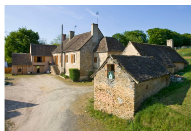
Vue générale depuis le nord-est. Phot. Yves Guillotin IVR52_20117200587NUCA
