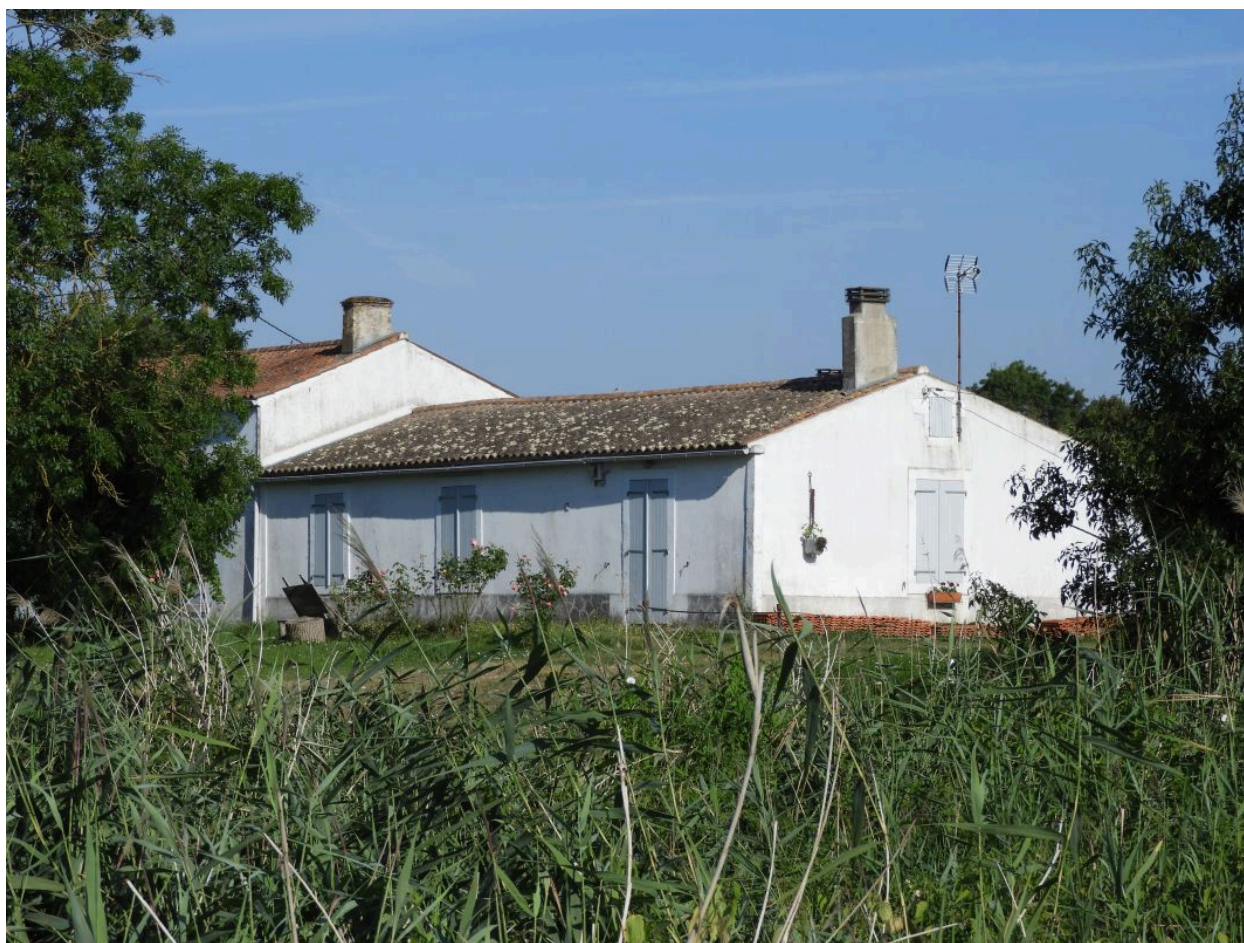
L'extension en rez-de-chaussée vue depuis le sud-est.
