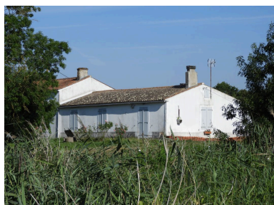
L'extension en rez-de- chaussée vue depuis le sud-est.
