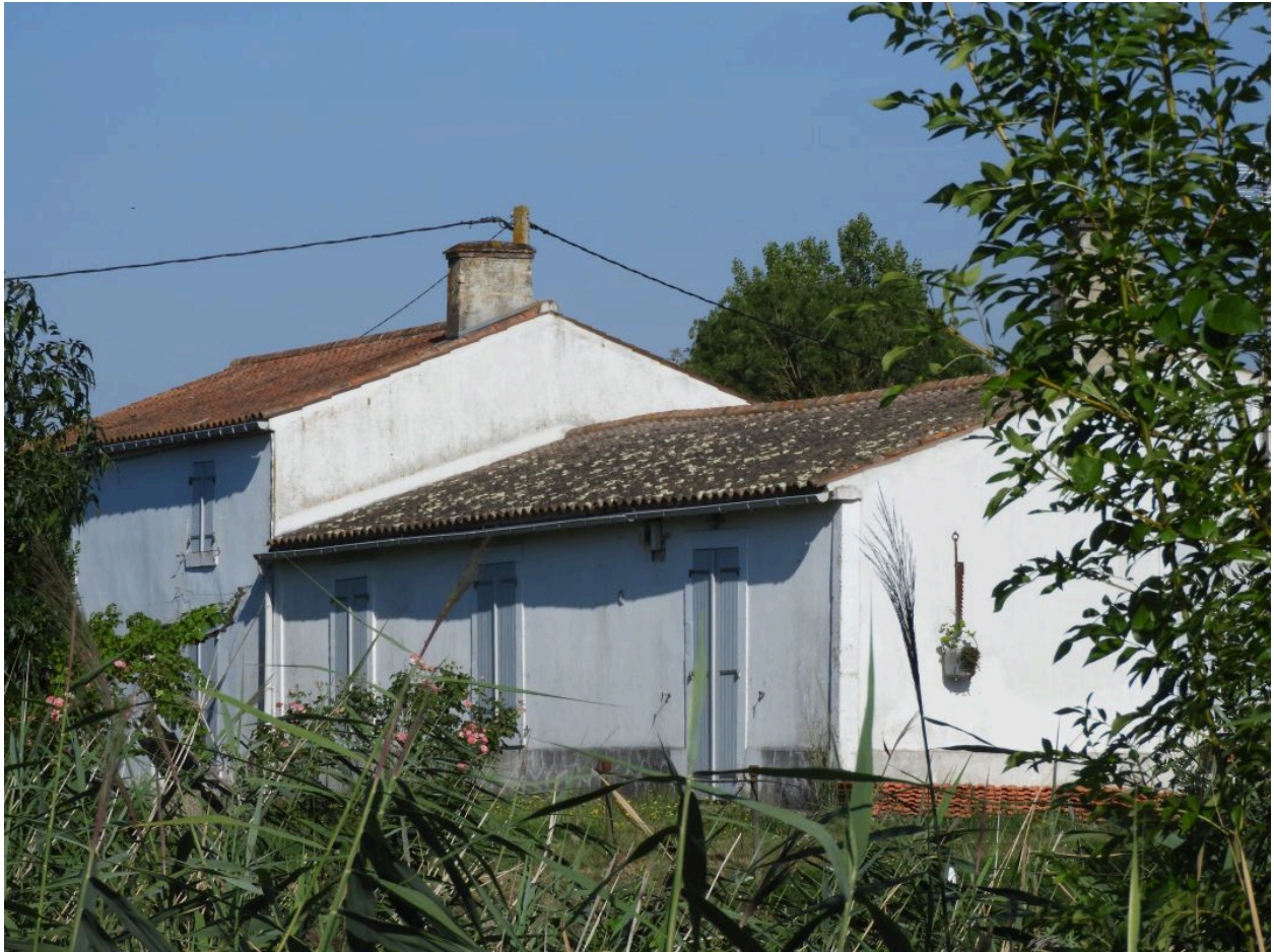
Le logis et son extension vus depuis l'est.
