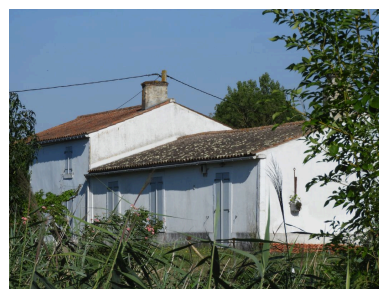
Le logis et son extension vus depuis l'est.
