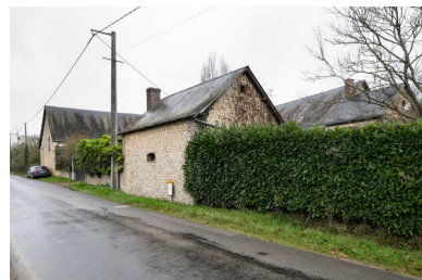
Fournil. Phot. Thierry Seldubuisson IVR52_20247200406NUCA
