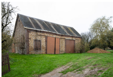
Grange. Phot. Thierry Seldubuisson IVR52_20247200407NUCA
