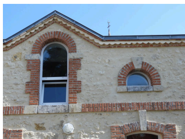
Détail du décor en brique des communs. Phot. Yannis Suire IVR52_20188501305NUCA
