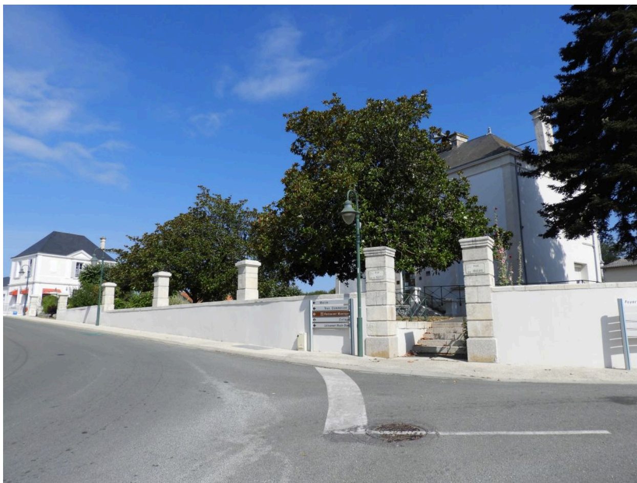
La mairie et son mur de clôture, au sommet de l'avenue de la Gare, vus depuis le sud-est.
