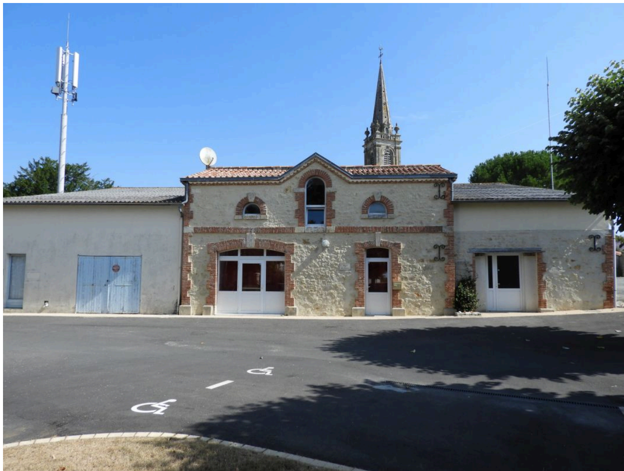
Les communs au nord de la mairie, vus depuis le sud.
