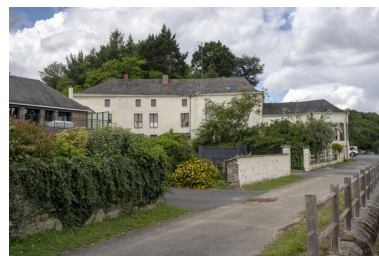
Une vue d'ensemble de l'ancien hôtel. Phot. Pierre-Bernard Fourny IVR52_20225300537NUCA
