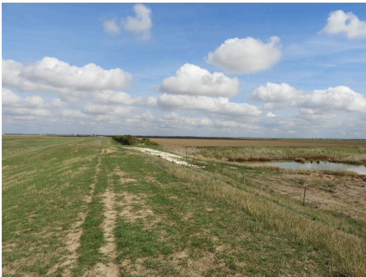
A la jonction entre la digue d'En bas (au premier plan) et la digue de la Bosse (à droite), vue en direction du nord-est.
