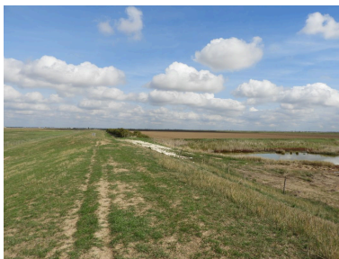
A la jonction entre la digue d'En bas (au premier plan) et la digue de la Bosse (à droite), vue en direction du nord-est.
