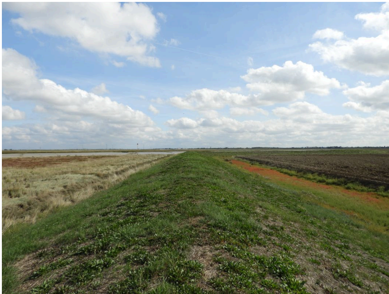
La partie nord de la digue de la Bosse, vue en direction de l'est ; à gauche, les vasières inondables ; à droite, le marais desséché de la Bosse.
