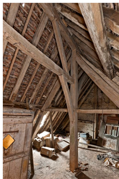
Vue de la charpente Phot. Yves Guillotin IVR52_20137200413NUCA
