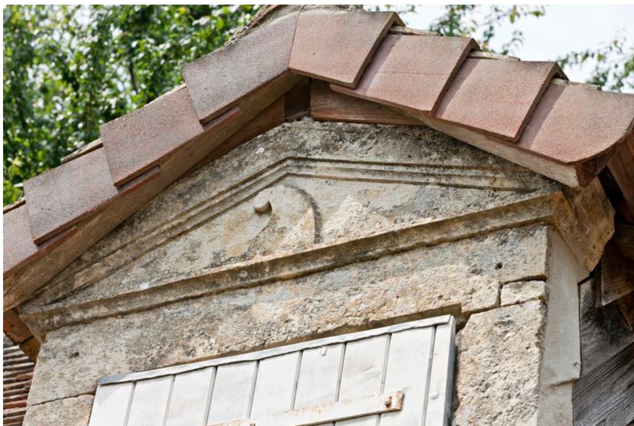
Détail du fronton-pignon de la porte haute des communs
