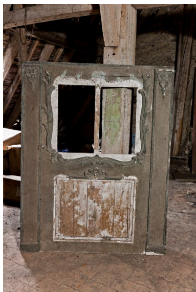
Vestige d'un trumeau de cheminée (?) du XVIIIe siècle déposé dans le comble de la maison Phot. Yves Guillotin IVR52_20137200414NUCA
