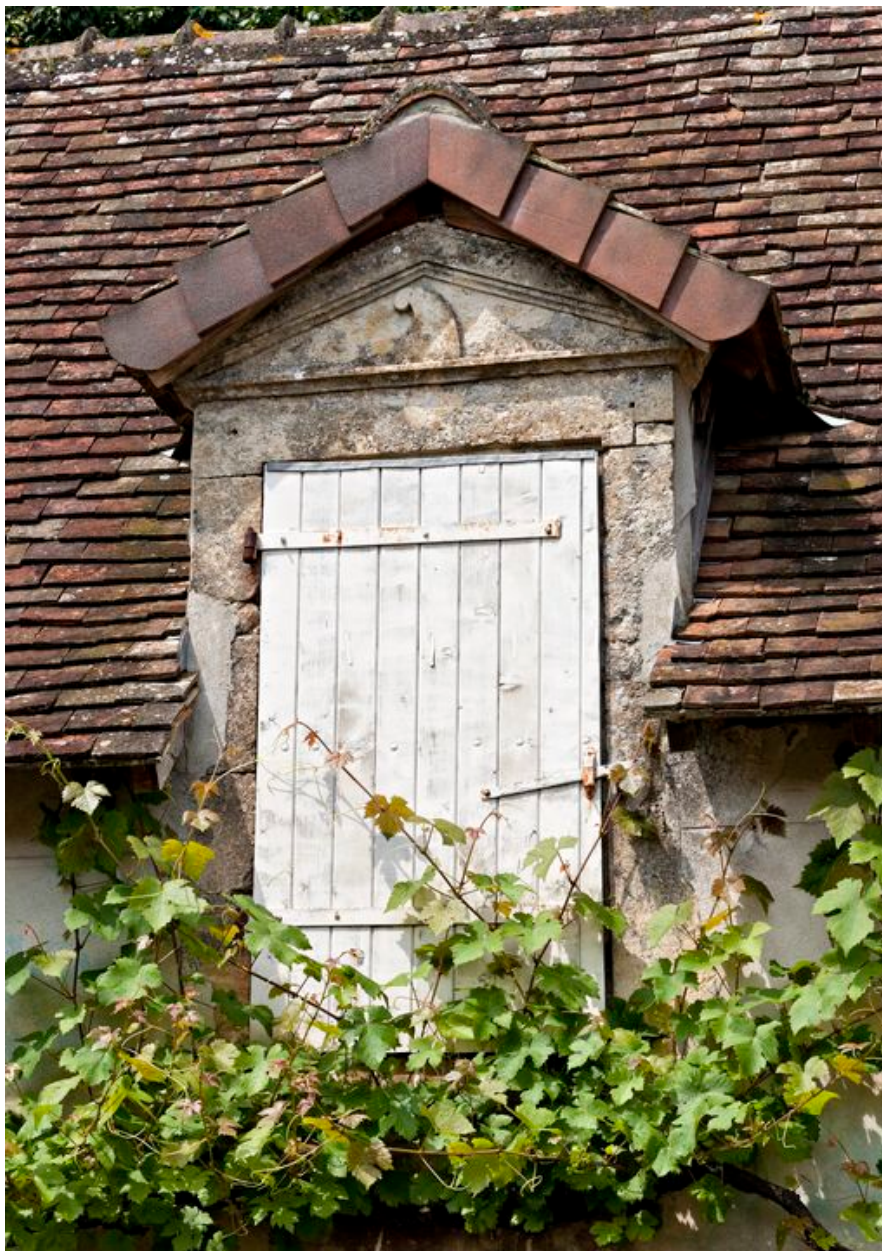
Porte haute passante des communs
