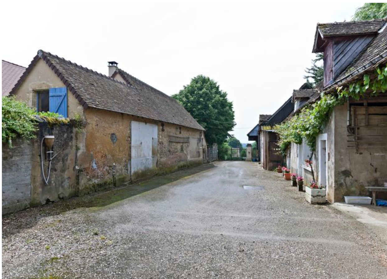
Vue d'ensemble de la cour depuis la maison
