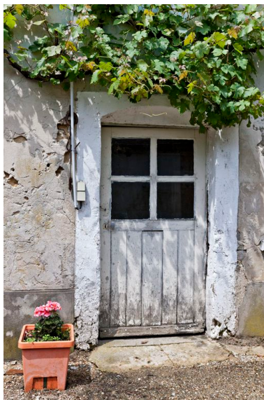
Porte des commons Phot. Yves Guillotin IVR52_20137200419NUCA
