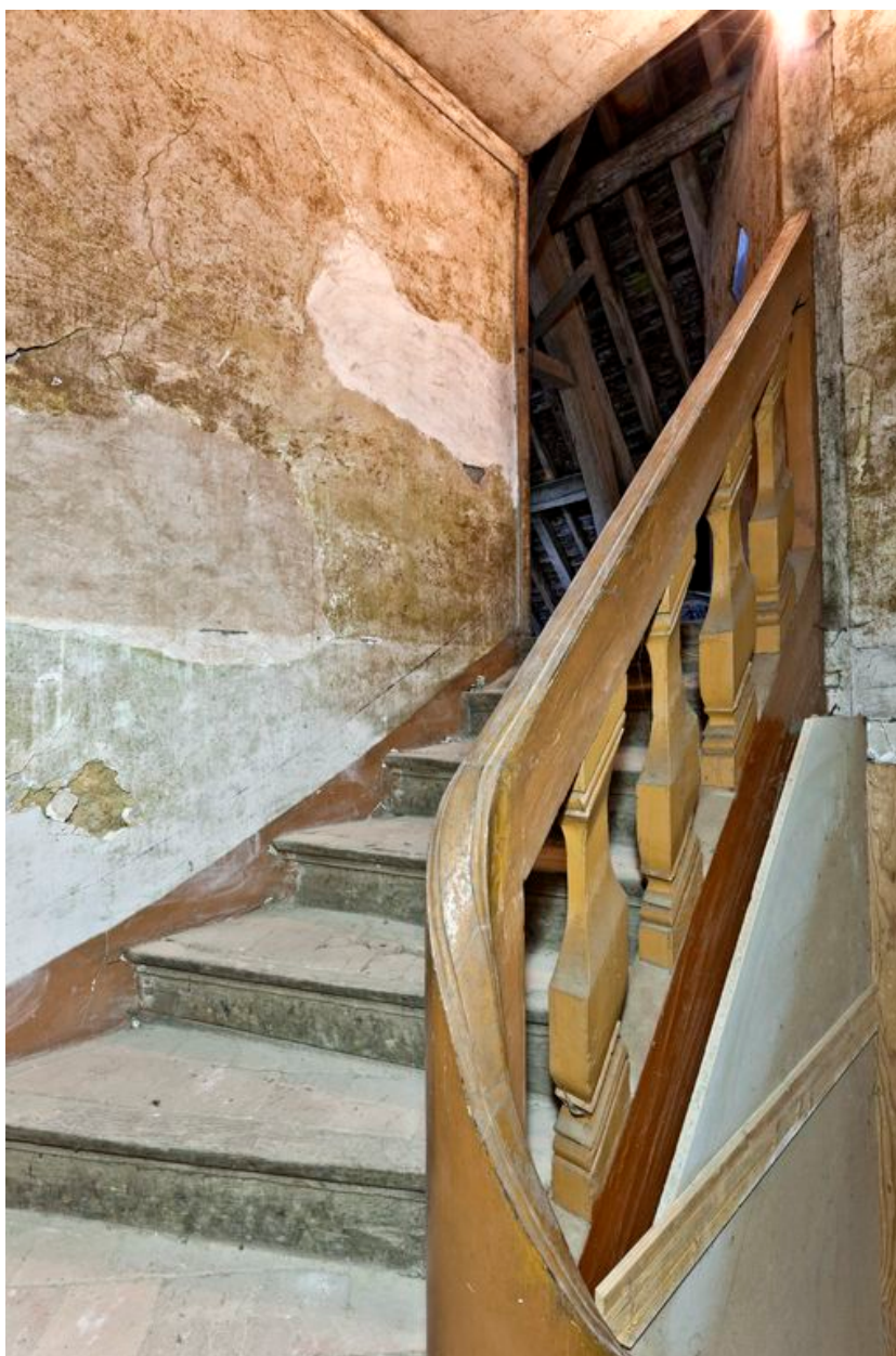
Vue de l'escalier depuis le premier étage
