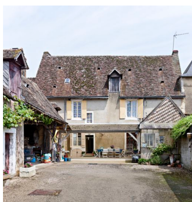
Elevation sur cour de la maison Phot. Yves Guillotin IVR52_20137200421NUCA
