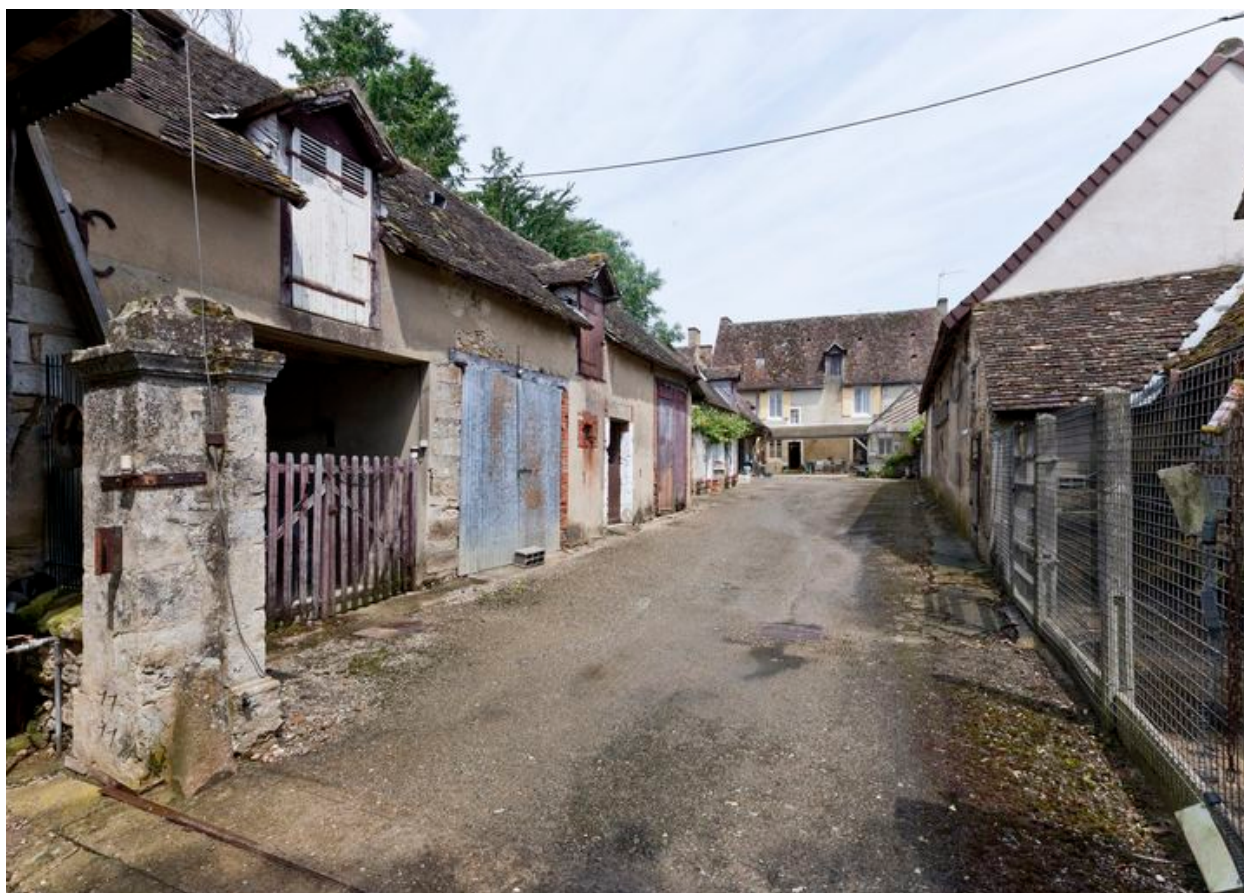
Vue d'ensemble de la cour vue depuis le portail
