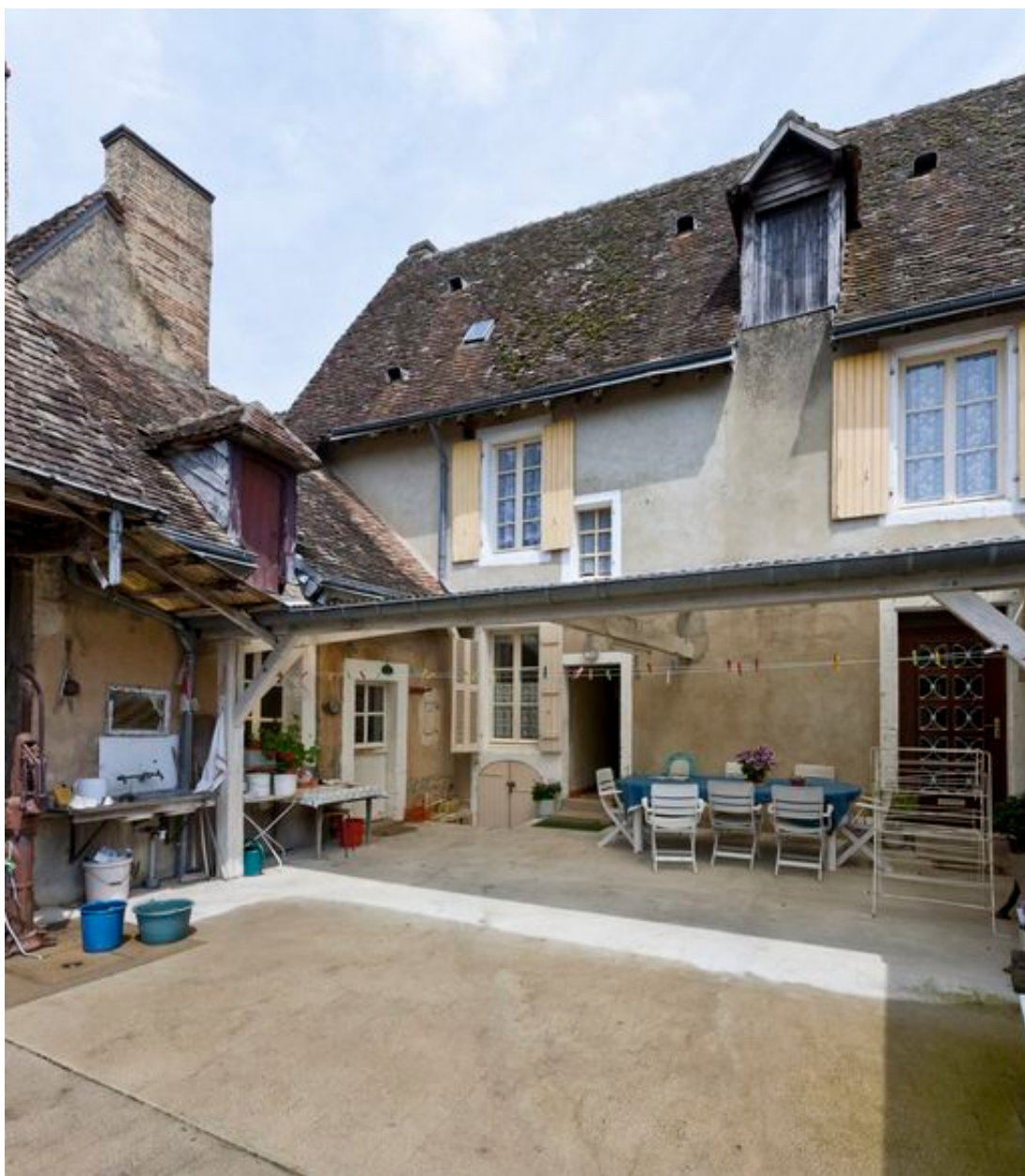
Détail des élévations sur cour de la maison et communs (à gauche)
