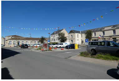
La place vue depuis le sud-ouest. Phot. Yannis Suire IVR52_20238501330NUCA
