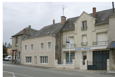
Vue depuis la rue. La maison est au centre. Phot. François Lasa IVR52_20045303341NUCA
