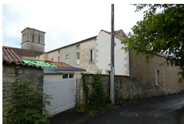
L'école vue depuis le nord-est. Phot. Yannis Suire IVR52_20238501425NUCA
