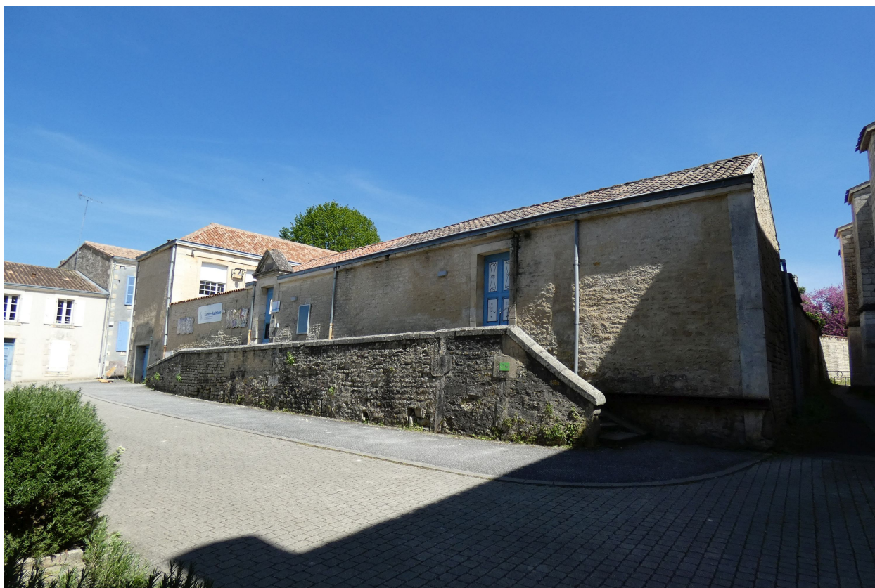
L'école vue depuis le sud-ouest.
