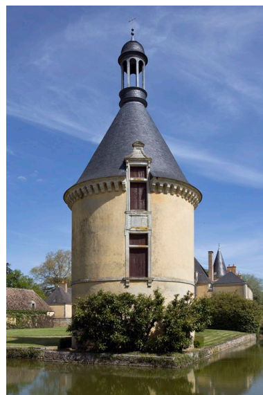
Tour de la basse- cour vue depuis le sud. Phot. Yves Guillotin IVR52_20107202090NUCA
