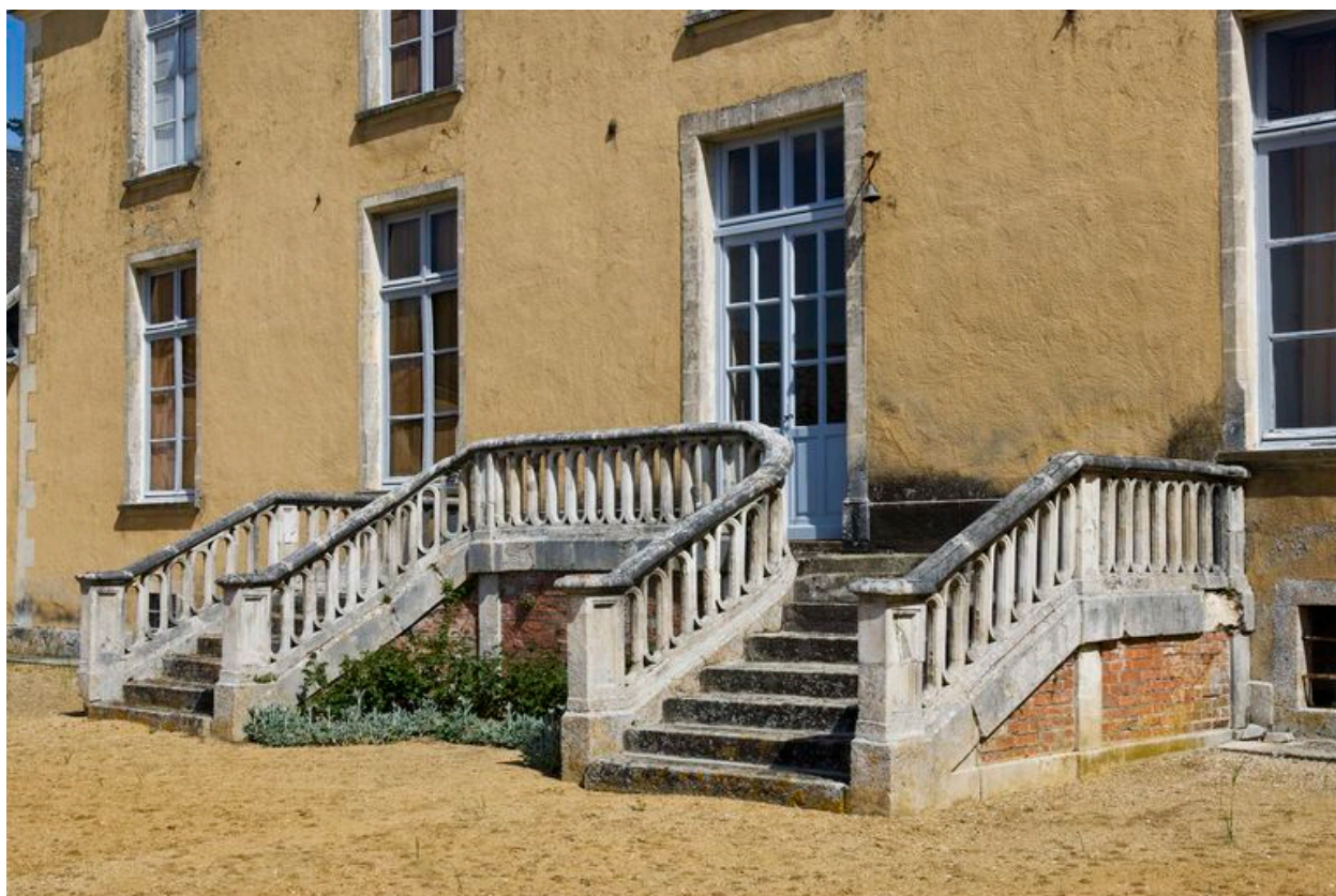
Escalier d'accès au corps central du logis.
