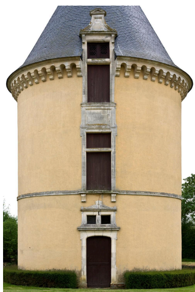
Détail de l'élévation nord de la tour. Phot. Yves Guillotin IVR52_20107202116NUCA
