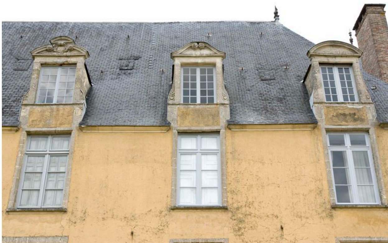
Parties hautes du corps central : travée centrale et des travées droites.
