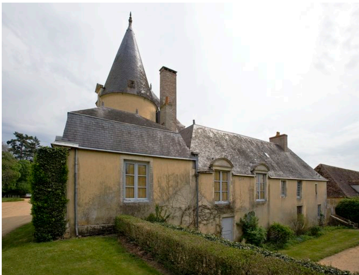
Aile ouest vue du nord-ouest
