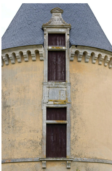
Détail de l'élévation sud de la tour. Phot. Yves Guillotin IVR52_20107202118NUCA
