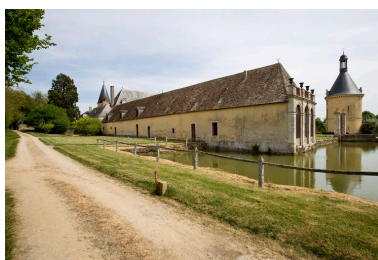
Les communs vus depuis le sud. Phot. Yves Guillotin IVR52_20107202103NUCA
