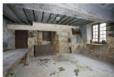
Cuisine de l'aile ouest. Phot. Yves Guillotin IVR52_20107202001NUCA
