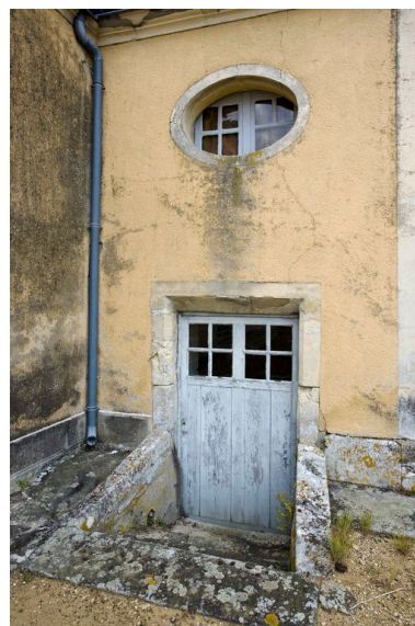
Escalier d'accès aux parties basses du logis depuis la terrasse. Phot. Yves Guillotin IVR52_20107202111NUCA
