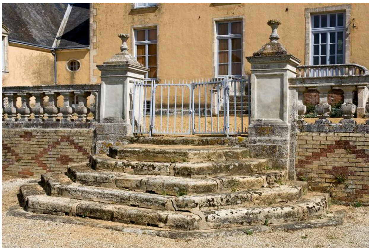
Dégré sud de la terrasse.
