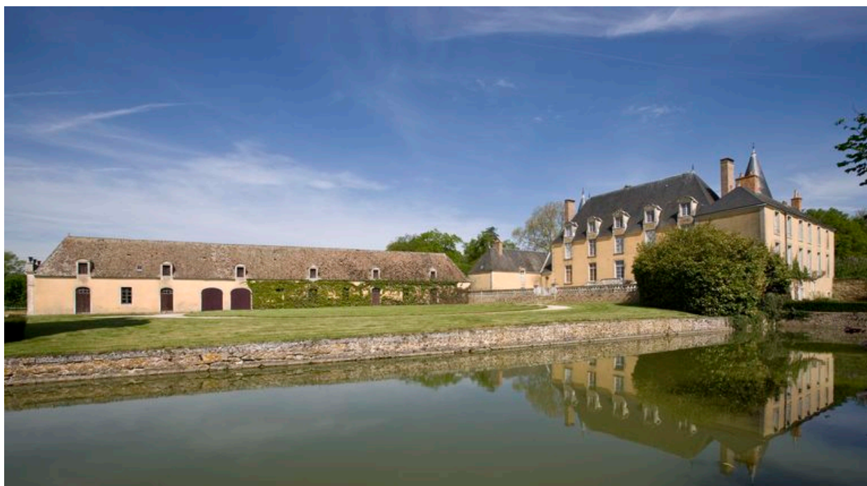
Ensemble depuis l'est.
