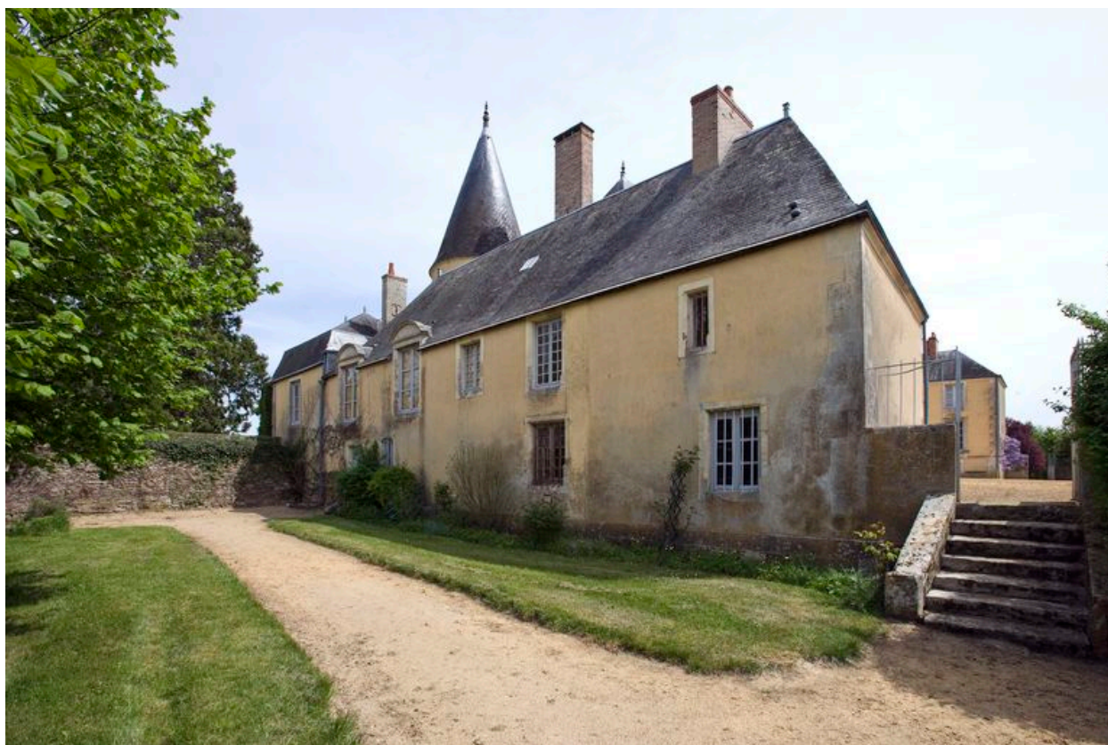
Aile ouest, vue depuis le sud-ouest.
