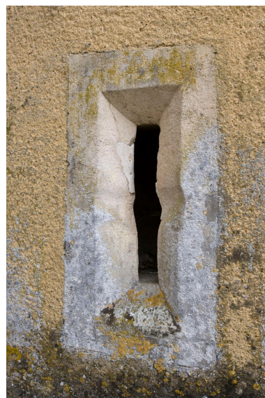
Canonnière de la tour ouest du logis. Phot. Yves Guillotin IVR52_20107202122NUCA
