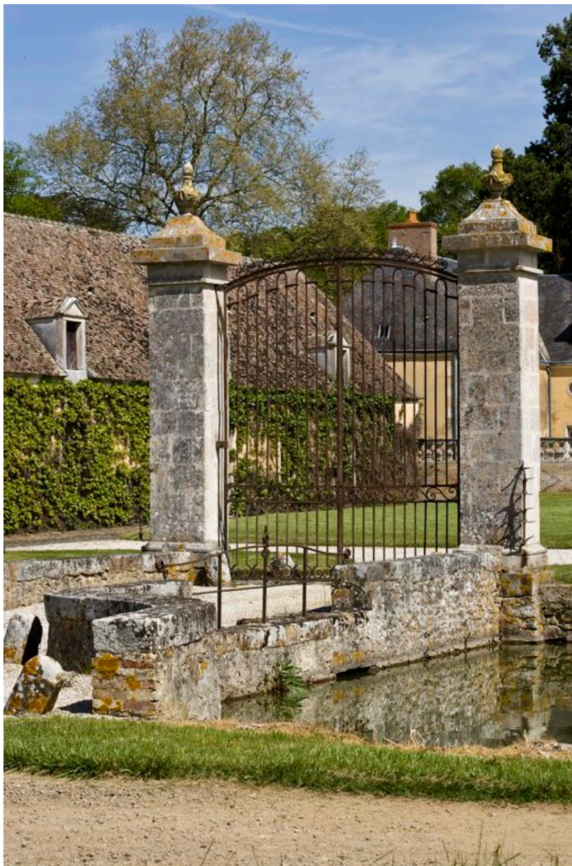
Pont et portail d'entrée de la basse-cour.
