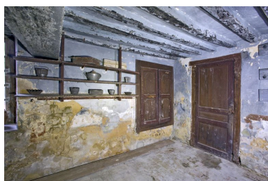
Cuisine de l'aile ouest : mur ouest et porte d'accès à la laiterie. Phot. Yves Guillotin IVR52_20107202005NUCA
