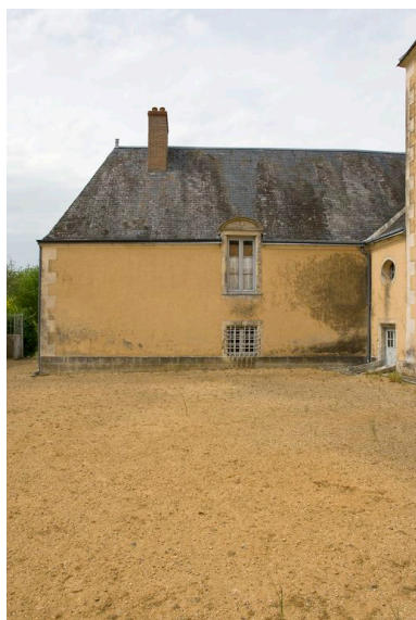
Logis, aile en retour ouest. Phot. Yves Guillotin IVR52_20107202110NUCA
