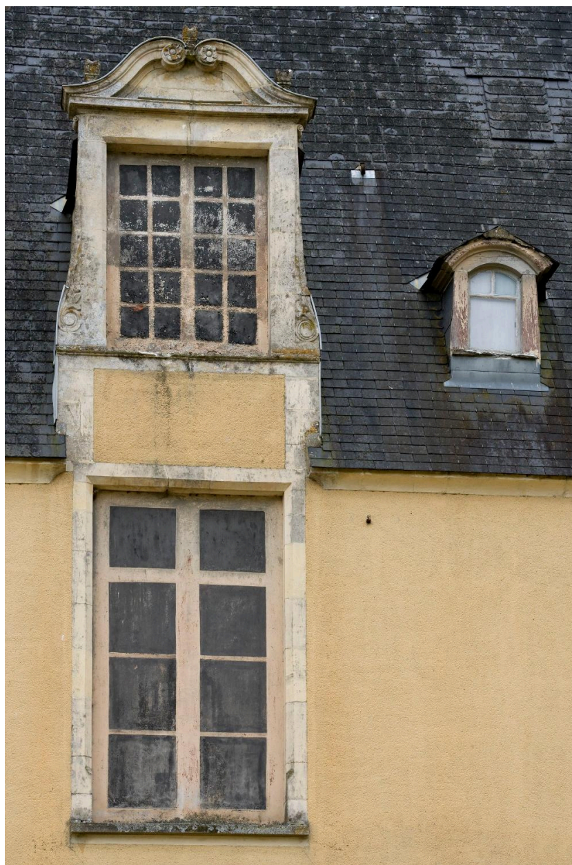
Première travée droite de l'élévation postérieure du logis, correspondant à l'escalier intérieur.
