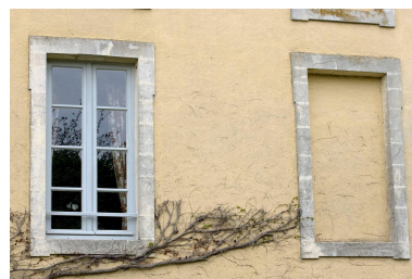
Fenêtres du rez-de-chaussée surélevé de l'élévation postérieure de l'aile en retour est. Phot. Yves Guillotin IVR52_20107202119NUCA
