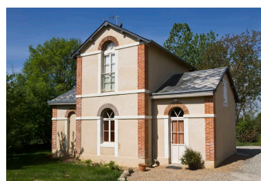
Maison du régisseur. Phot. Yves Guillotin IVR52_20107202075NUCA
