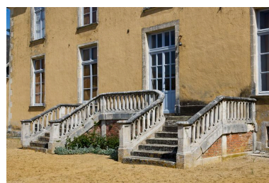
Escalier d'accès au corps central du logis. Phot. Yves Guillotin IVR52_20107202084NUCA
