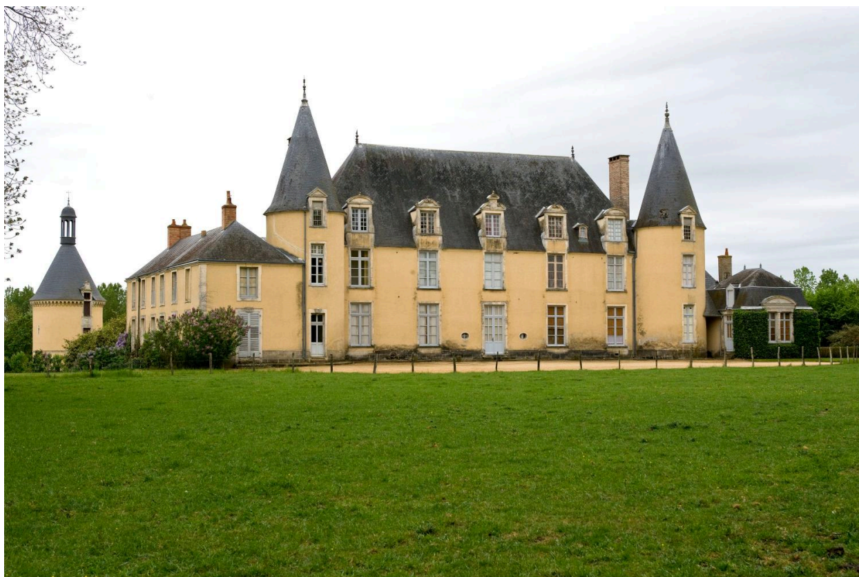
Elevation postérieure du logis.
