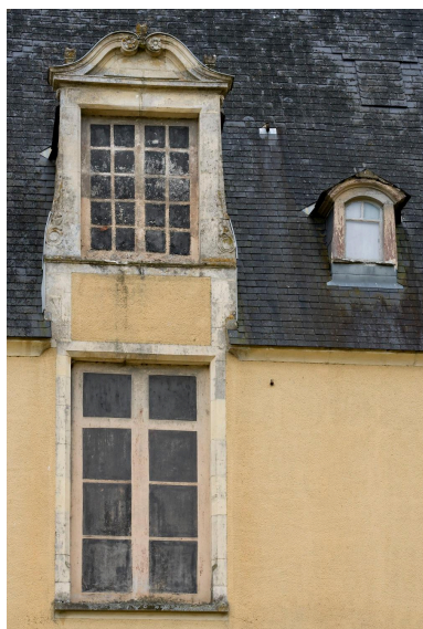
Première travée droite de l'élévation postérieure du logis, correspondant à l'escalier intérieur. Phot. Yves Guillotin IVR52_20107202125NUCA
