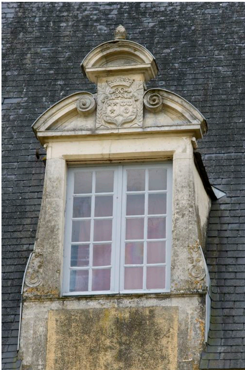
Lucarne de la travée centrale du logis.
