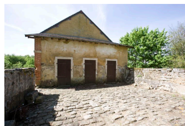
Détail des porcheries. Phot. Yves Guillotin IVR52_20107202079NUCA
