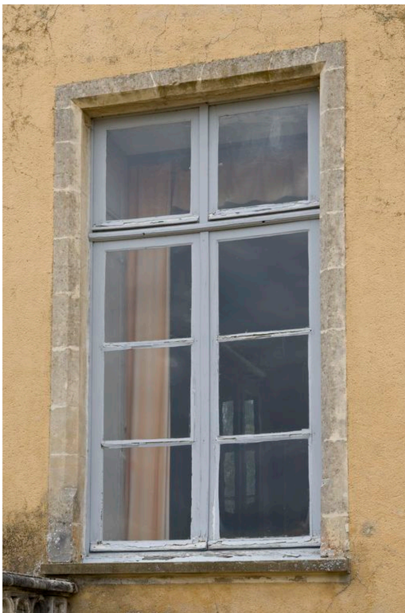
Fenêtre de l'élévation sud du corps central.
