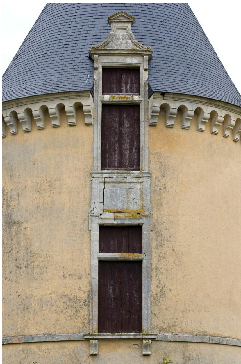
Détail de l'élévation sud de la tour.
