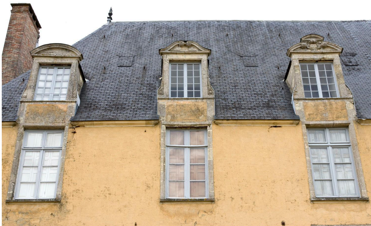
Parties hautes du corps central : travée centrale et travées gauches.
