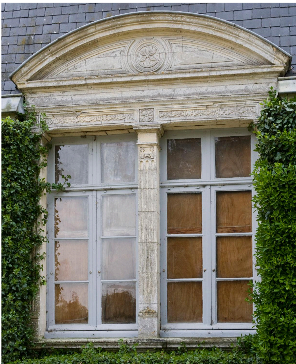
Fenêtre nord de l'aile ouest.
