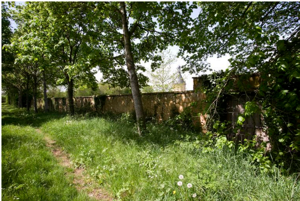
Mur de clôture du potager.
