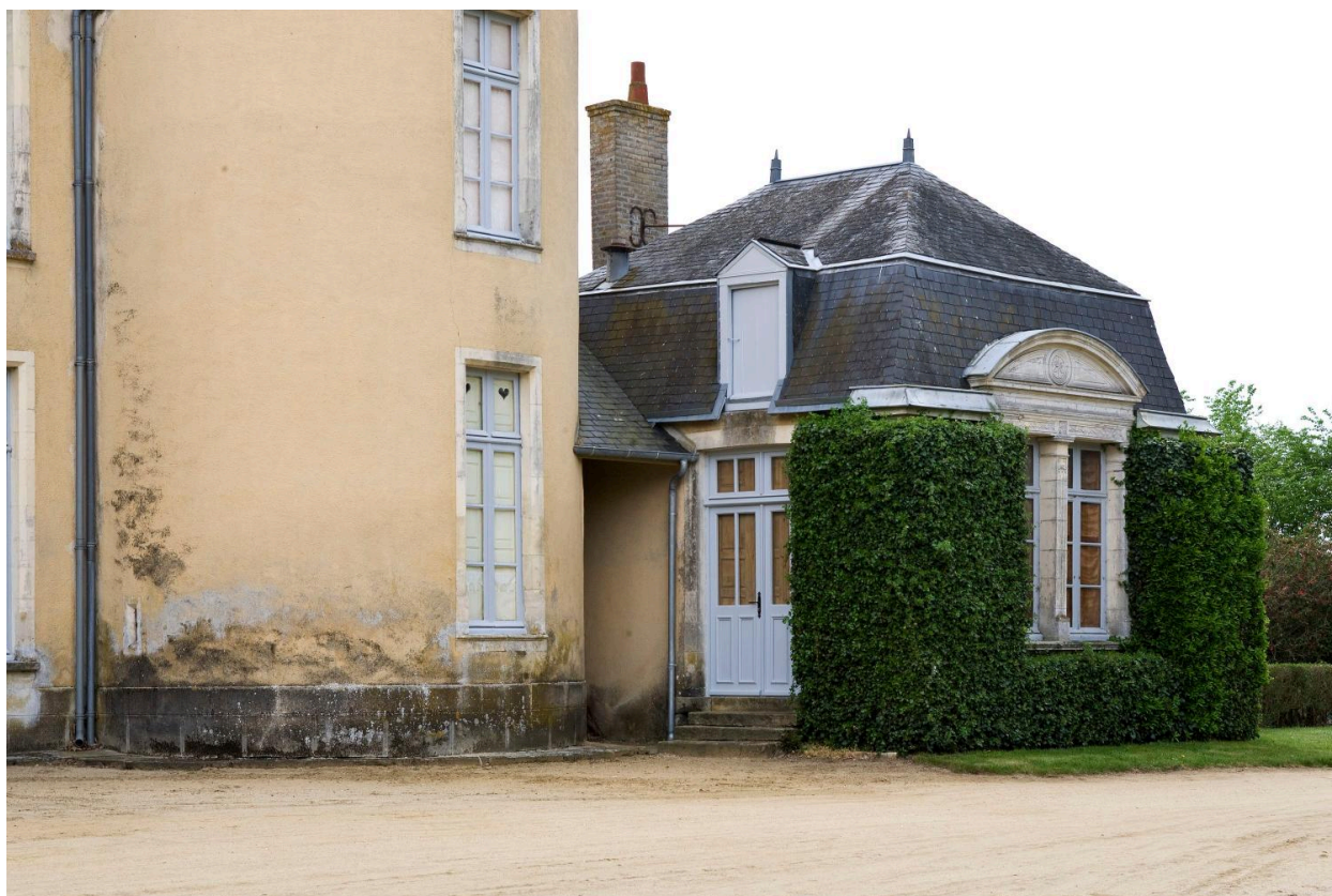
Prolongement nord de l'aile ouest du logis.
