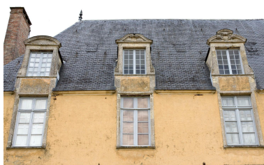
Parties hautes du corps central : travée centrale et travées gauches. Phot. Yves Guillotin IVR52_20107202115NUCA
