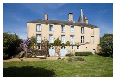
Élévation postérieure de l'aile en retour est du logis. Phot. Yves Guillotin IVR52_20107202086NUCA
