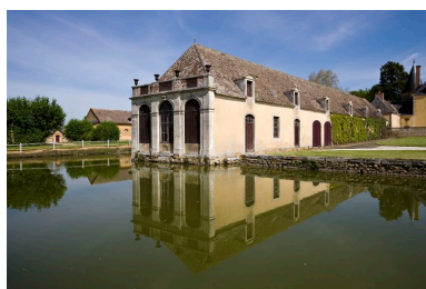
Les communs vus depuis le sud. Phot. Yves Guillotin IVR52_20107202073NUCA
