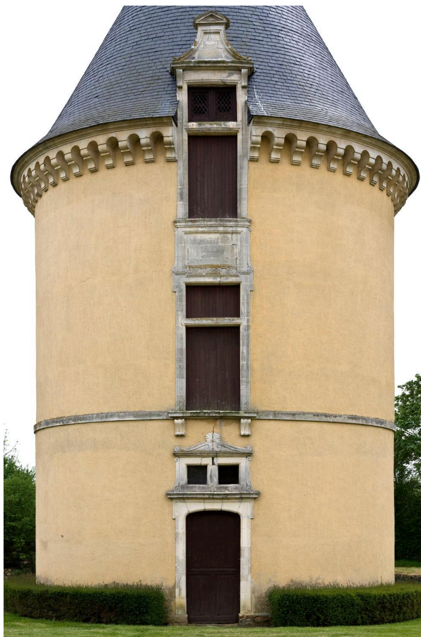
Détail de l'élévation nord de la tour.
