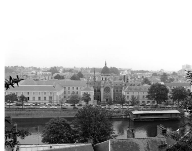
Vue d'ensemble depuis la rive droite. Phot. Jacques Le Callonnec IVR52_19805300220X
