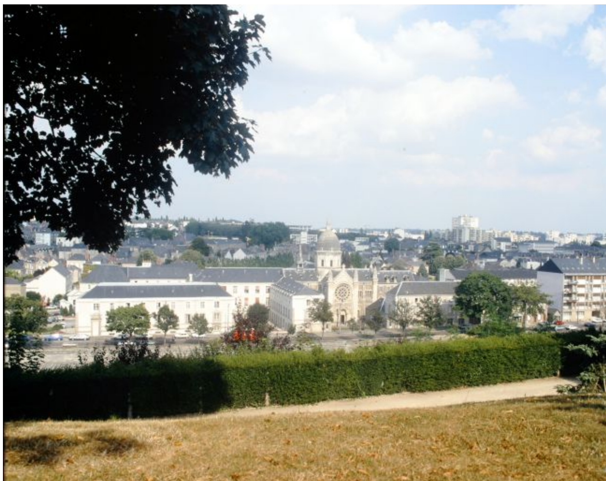
Vue d'ensemble depuis la rive droite.
