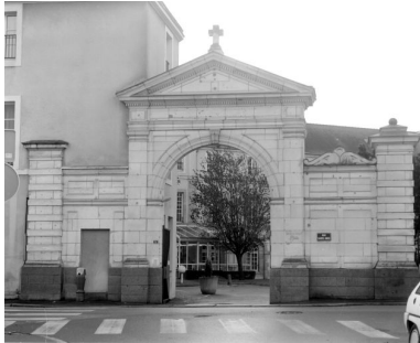
Hôpital Saint Julien : porche d'entrée sur la rue Sainte-Anne.
