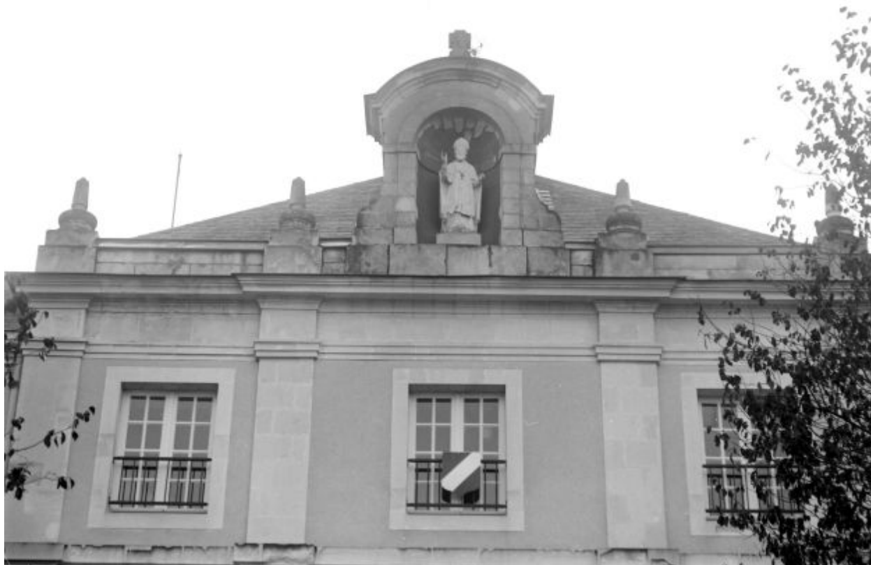
Hôpital Saint Julien : bâtiment principal détail de la niche abritant la statue de Saint Julien.
