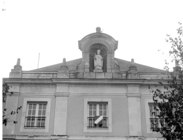
Hôpital Saint Julien : bâtiment principal détail de la niche abritant la statue de Saint Julien.
