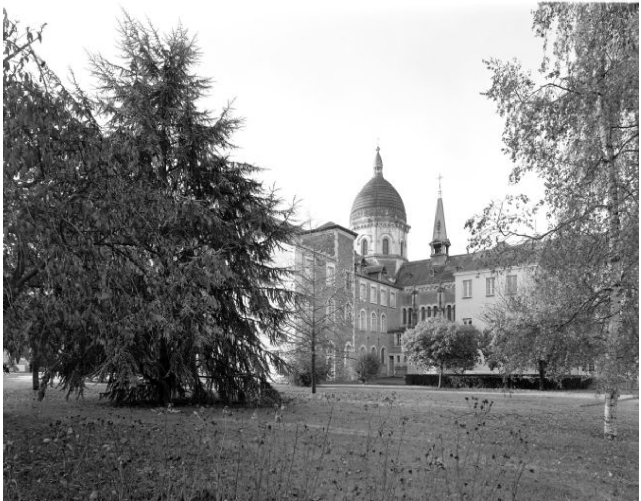
Vue d'ensemble prise de la cour : chapelle et bâtiments de l'hôpital, façades nord et est.
