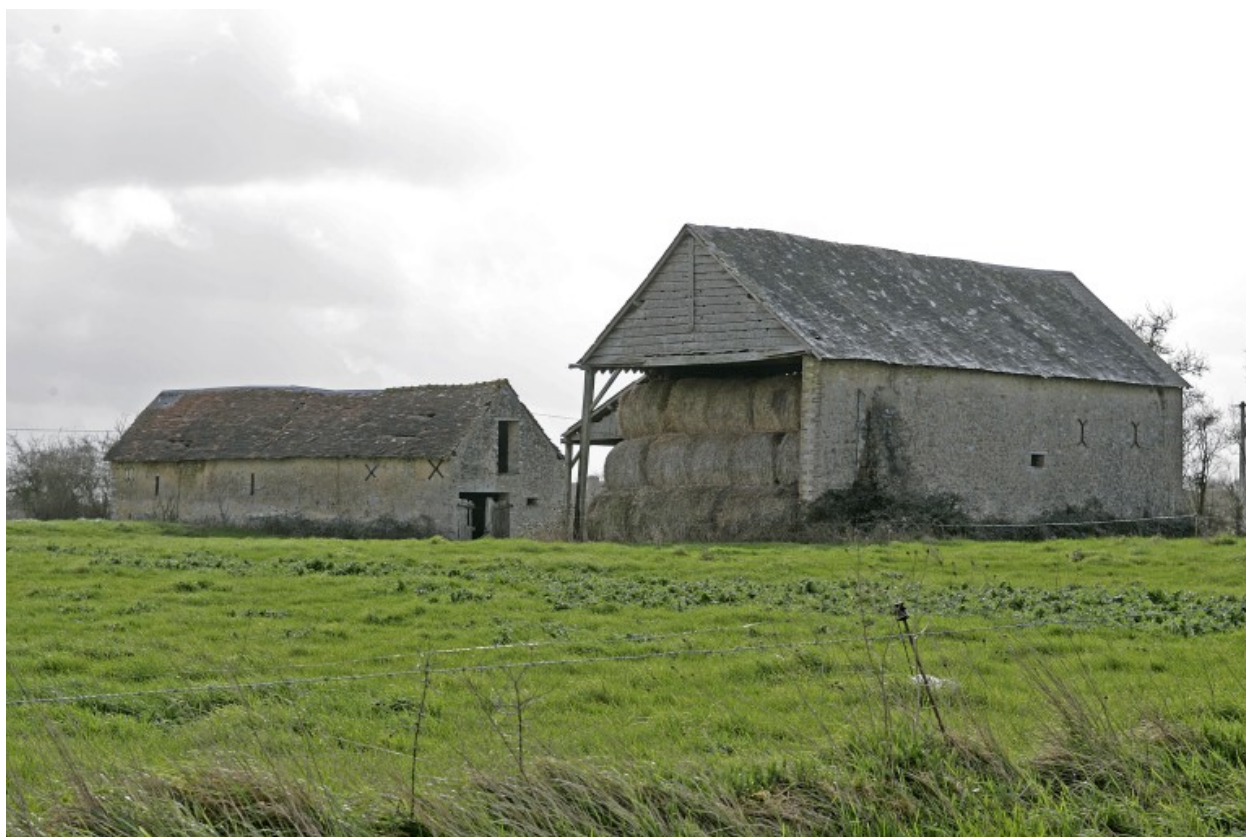
Vue d'ensemble depuis la route au nord : l'étable et la remise.
