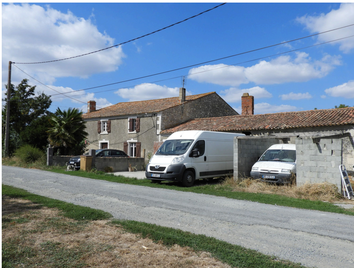
La ferme vue depuis le sud-est.
