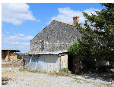
Le logis et la dépendance en appentis à l'arrière, percée de boulins à pigeons, le tout vu depuis le sud-ouest. Phot. Yannis Suire IVR52_20198500126NUCA
