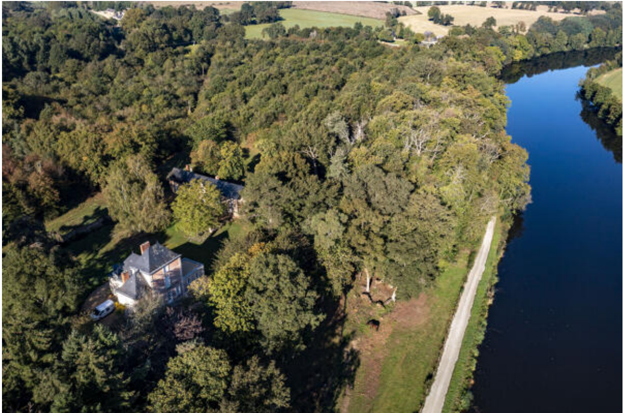
Une vue aérienne du logis des Sourdières.
