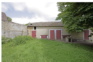
Porcheries, élévation sur cour. Phot. François Lasa IVR52_20077200748NUCA
