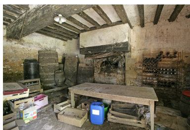
Fournil-remise : intérieur du fournil. Phot. François Lasa IVR52_20077200750NUCA
