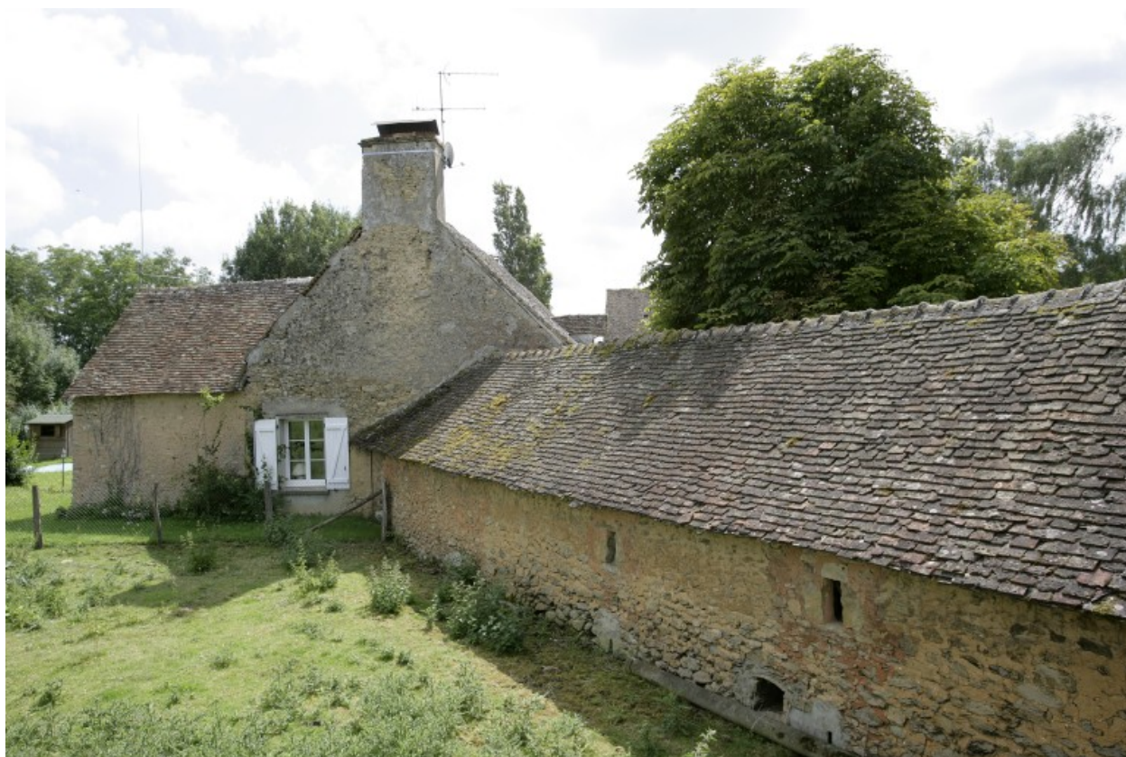
Logis : mur pignon ouest, et porcheries : élévation postérieure.
