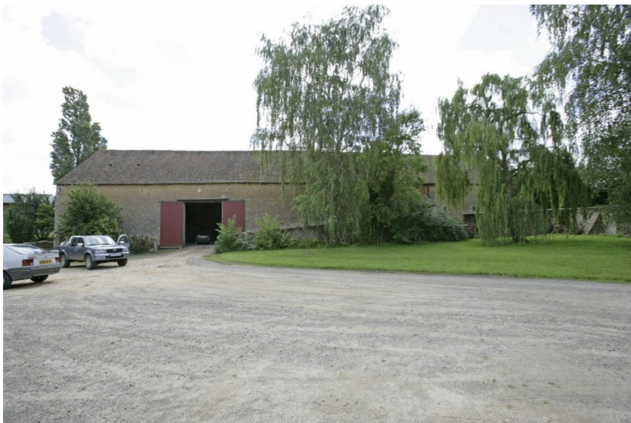
Grange-étables : élévation sur cour.
