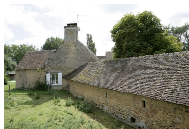
Logis : mur pignon ouest, et porcheries : élévation postérieure. Phot. François Lasa IVR52_20077200754NUCA
