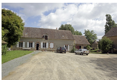
Logis : élévation sur cour. Phot. François Lasa IVR52_20077200741NUCA
