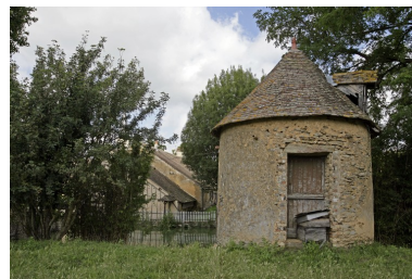
Four à chanvre. Phot. François Lasa IVR52_20077200744NUCA
