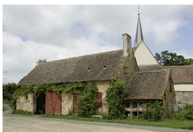
Fournil-remise : élévation sur cour. Phot. François Lasa IVR52_20077200747NUCA
