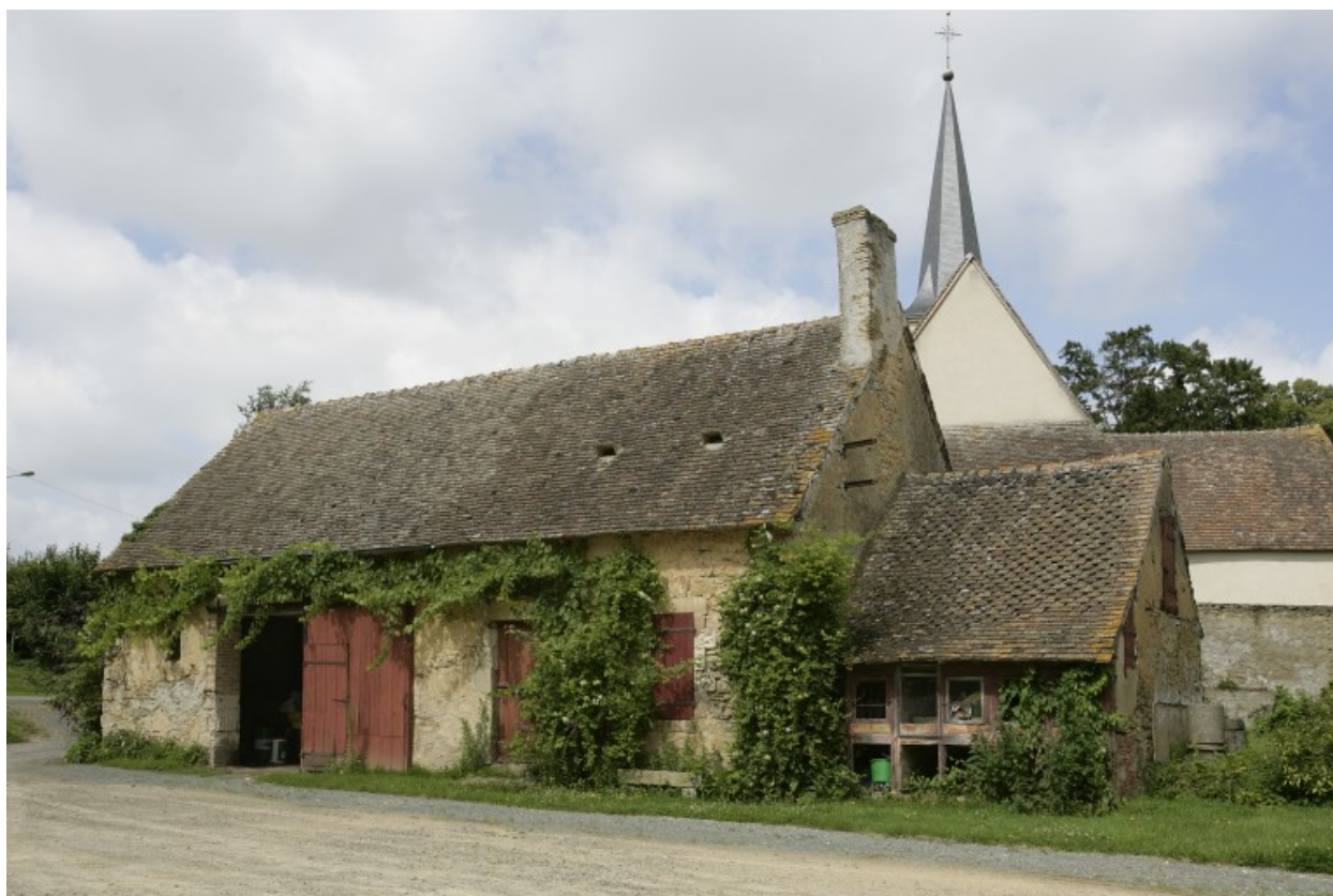
Fournil-remise : élévation sur cour.
