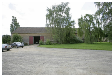
Grange-étables : élévation sur cour. Phot. François Lasa IVR52_20077200742NUCA
