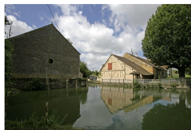
Vue générale depuis l'est. Phot. François Lasa IVR52_20077200745NUCA
