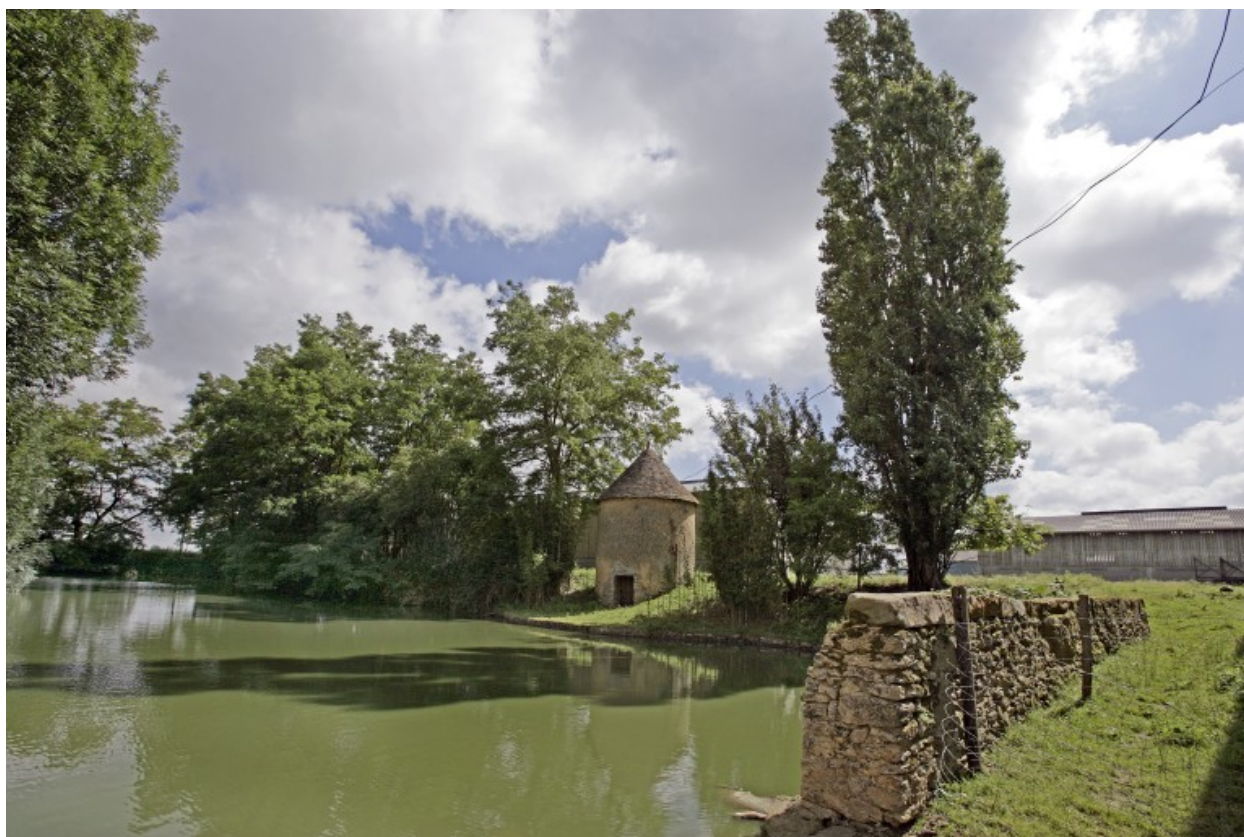
Four à chanvre : vue depuis la cour.
