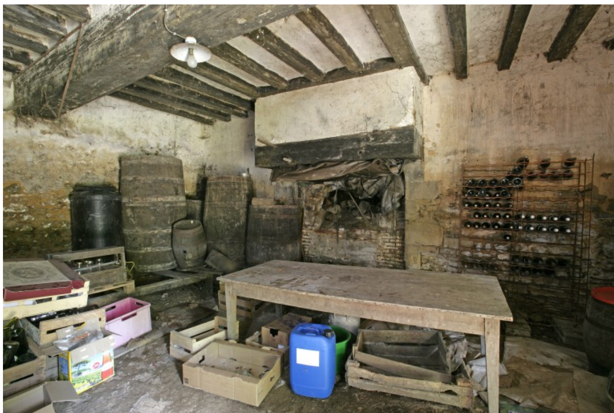
Fournil-remise : intérieur du fournil.
