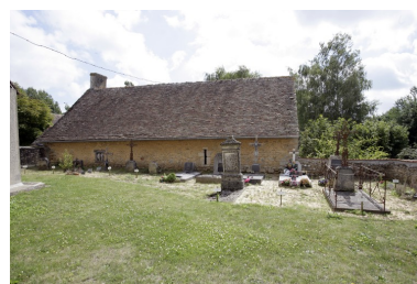
Fournil-remise : élévation postérieure. Phot. François Lasa IVR52_20077200753NUCA
