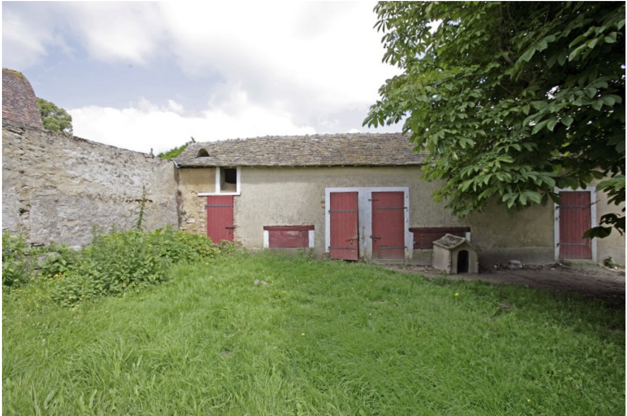
Porcheries, élévation sur cour.
