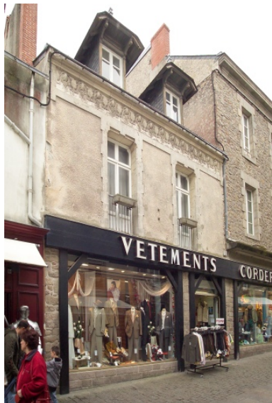
Vue de la façade sur rue. Phot. Denis Pillet IVR52_20074400889NUCA
