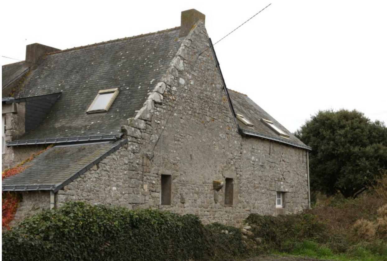
Vue du pignon sud du premier logis (2 rue de la Riandouille).
