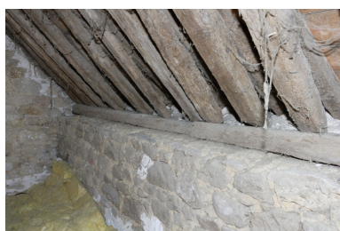
Détail d'une sablière de la charpente. Phot. Denis Pillet IVR52_20074401617NUCA
