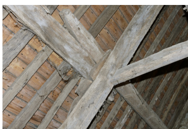
Détail de l'assemblage au niveau de la panne et du chevron-arbalétrier. Phot. Denis Pillet IVR52_20074401616NUCA
