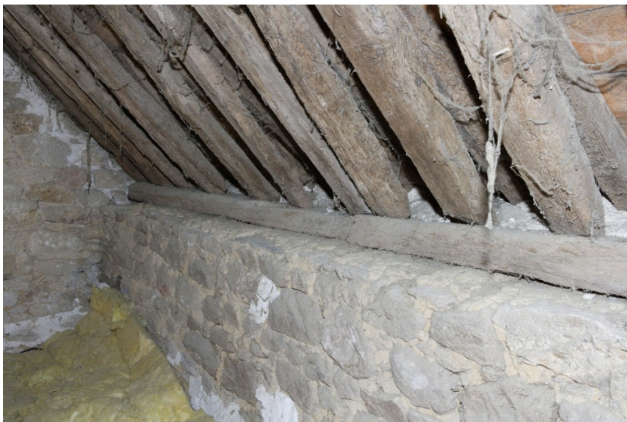
Détail d'une sablière de la charpente.
