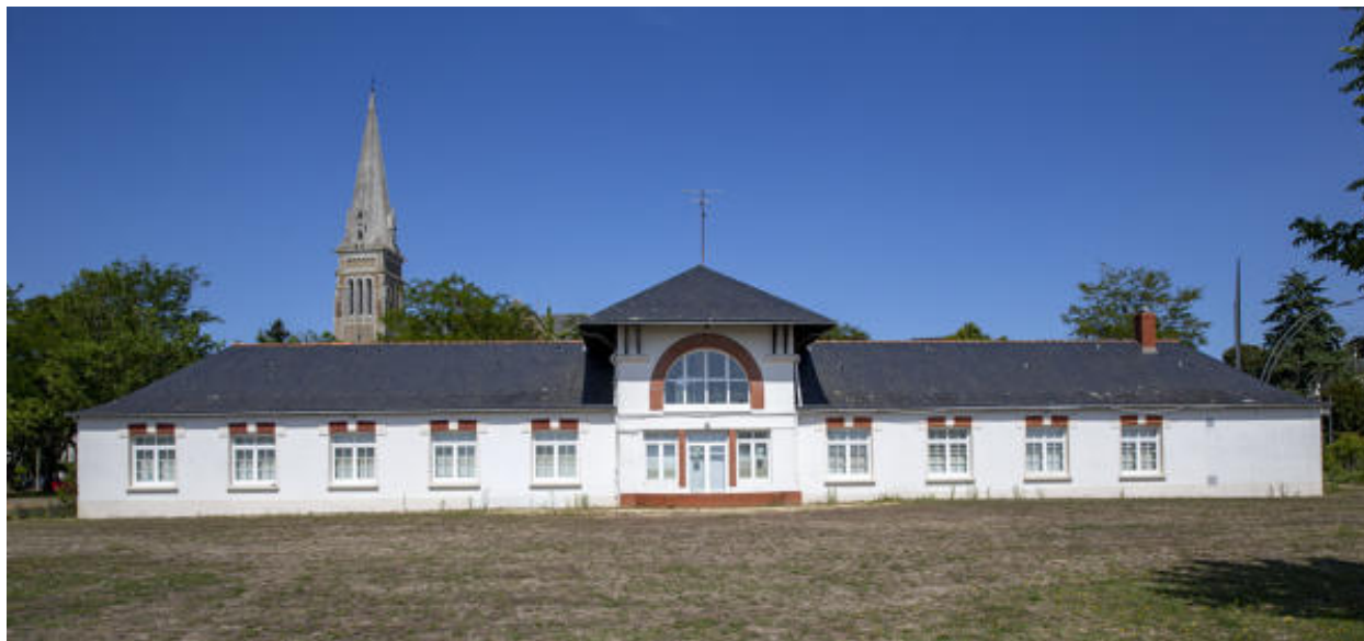
Vue générale depuis le sud.
