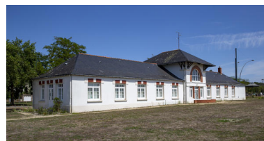
Vue générale depuis l'ouest. Phot. Pierre-Bernard Fourny IVR52_20194400616NUCA
