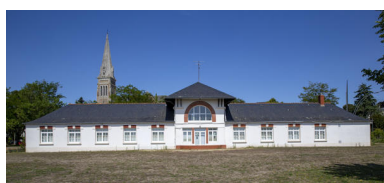
Vue générale depuis le sud. Phot. Pierre-Bernard Fourny IVR52_20194400617NUCA
