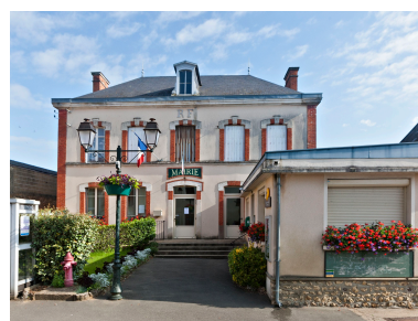
Elévation de la mairie- logement sur la rue. Phot. Yves Guillotin IVR52_20147201823NUCA
