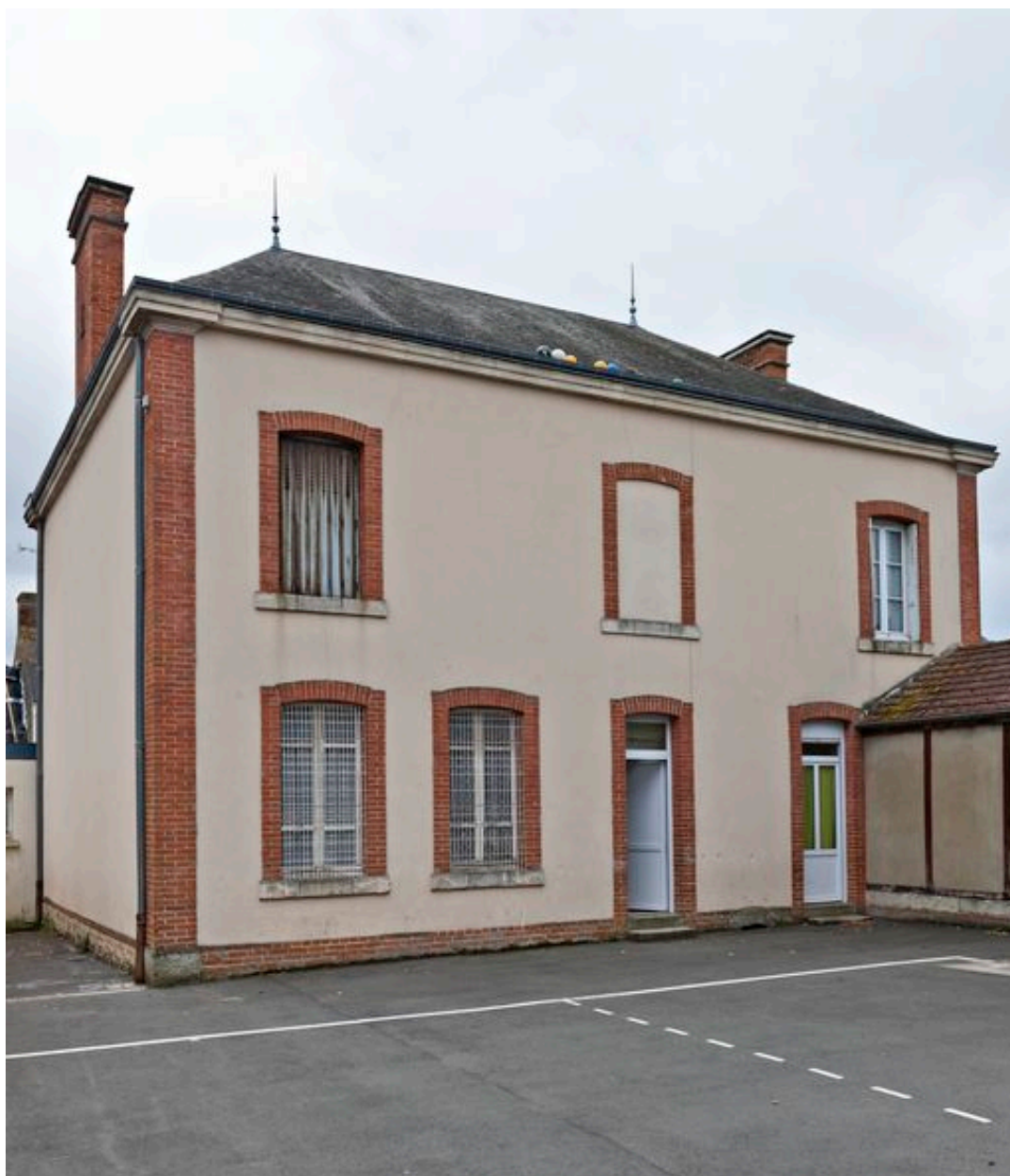
Mairie-logement, élévation postérieure.
