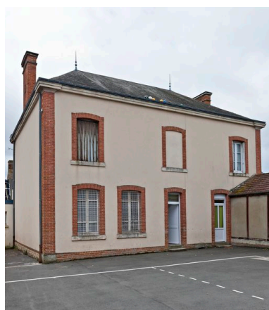
Mairie-logement, élévation postérieure. Phot. Yves Guillotin IVR52_20137200637NUCA
