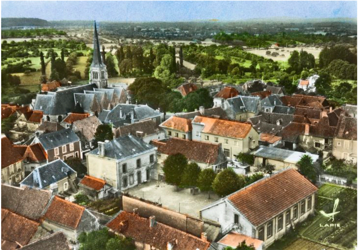
Vue aérienne de la mairie-école depuis le nord-est, 3e quart du XXe siècle.
