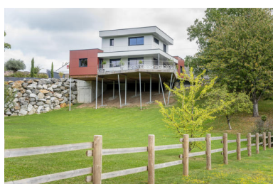
Une maison contemporaine sur pilotis à Beau-Rivage. Phot. Pierre-Bernard Fourny IVR52_20215301190NUCA
