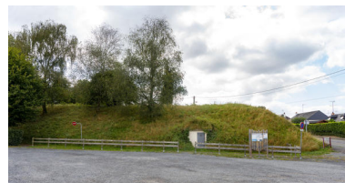
Le rempart gaulois ceinturant le bourg. Phot. Pierre-Bernard Fourny IVR52_20215301193NUCA
