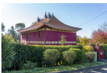
La "maison chinoise". Phot. Pierre-Bernard Fourny IVR52_20215301702NUCA
