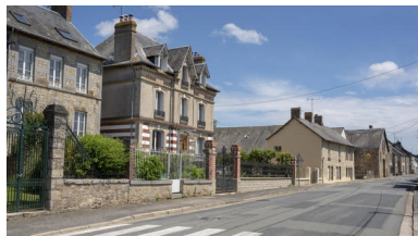
La maison dans la rue de Normandie. Phot. Pierre-Bernard Fourny IVR52_20215300336NUCA
