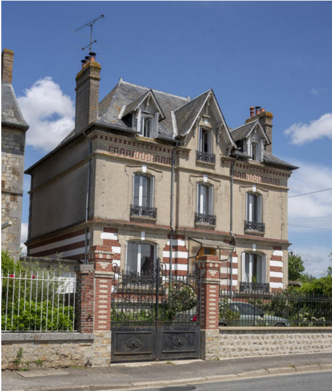
La façade antérieure de la maison.
