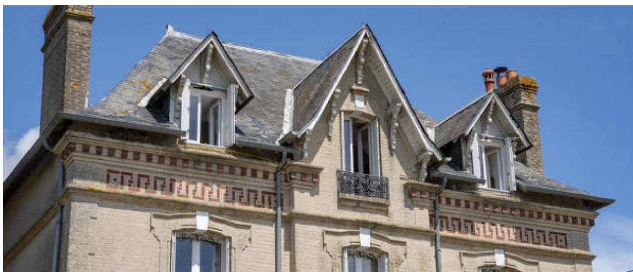
Un détail de la toiture et des lucarnes.
