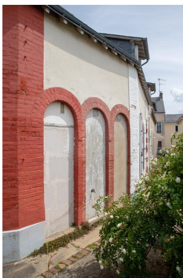
Vue des salles d'eau communes aujourd'hui condamnées. Phot. Pierre-Bernard Fourny IVR52_20197201385NUCA
