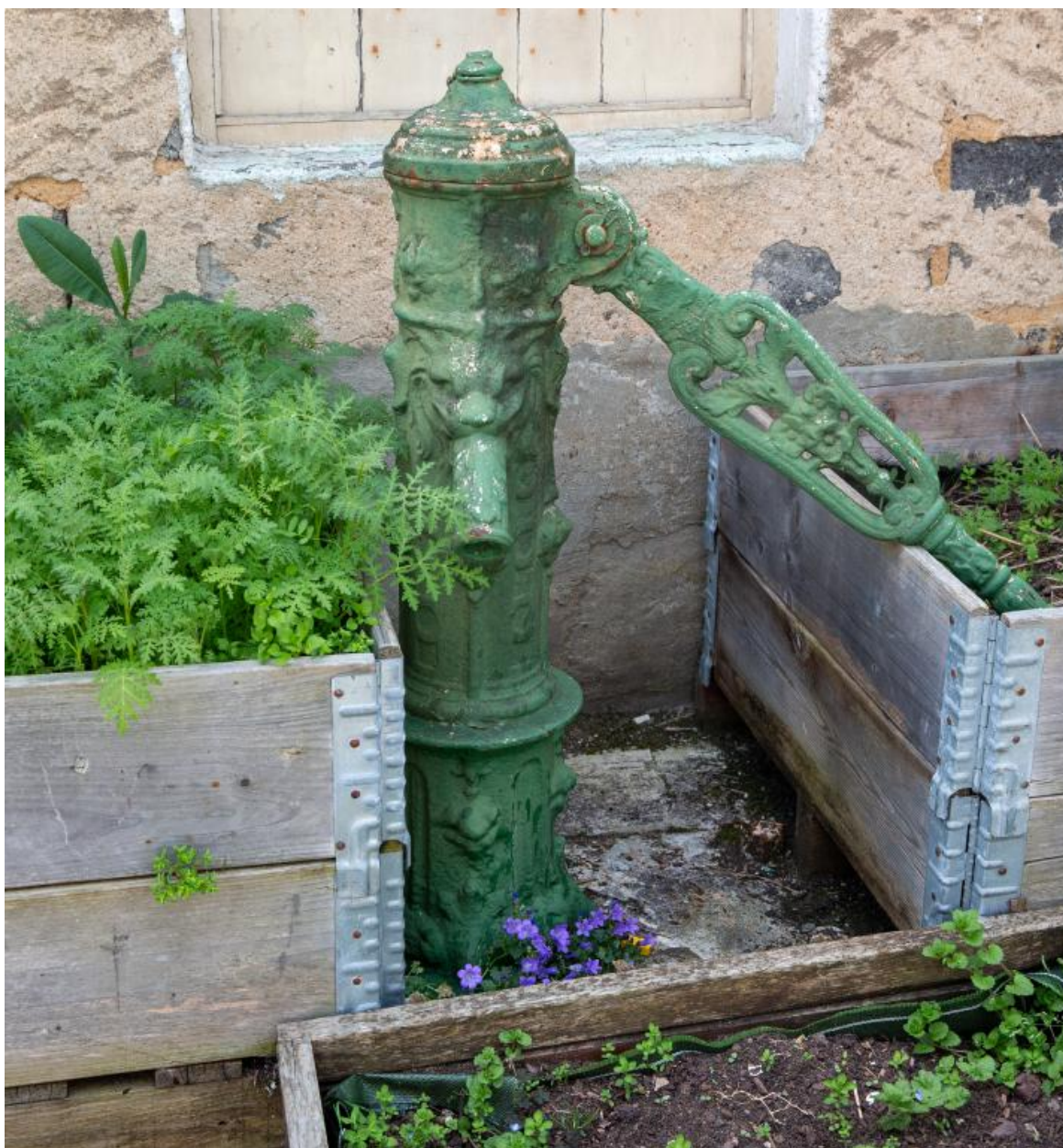
Vue de la pompe à eau dans la cour commune de la cité Doré.
